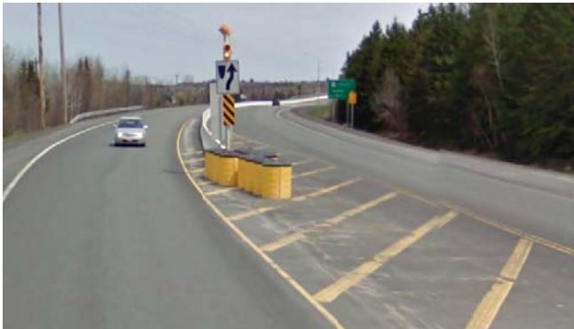
Fotografía N° 41: Ejemplo de atenuador de impacto colocado en terminal de barrera tipo New Jersey
