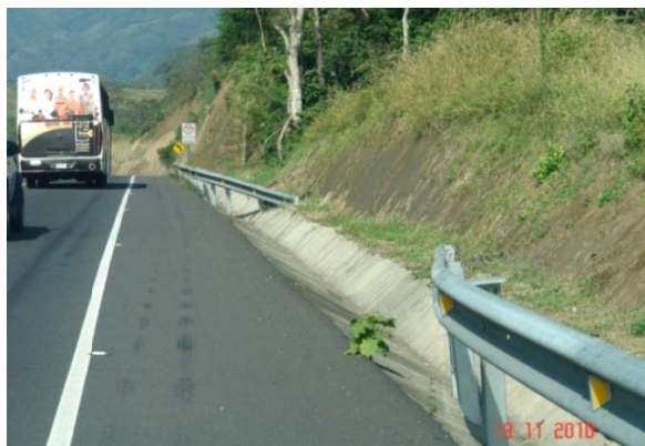
Fotografía N° 36: Guardavías discontinuo dejando expuesta la cuneta triangular
