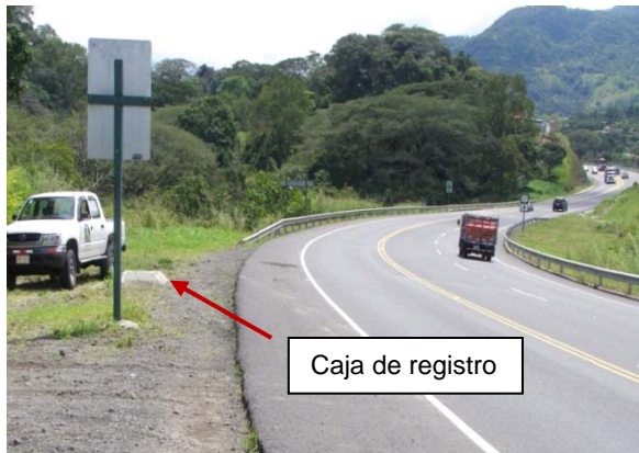
Fotografía N° 34: Obstáculo expuesto sin protección de guardavías en curva horizontal, estacionamiento 15+320
