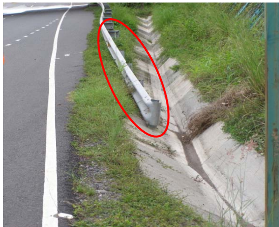
Fotografía N°27 Barreras flexibles con terminales abatidas sin correcto esviaje
