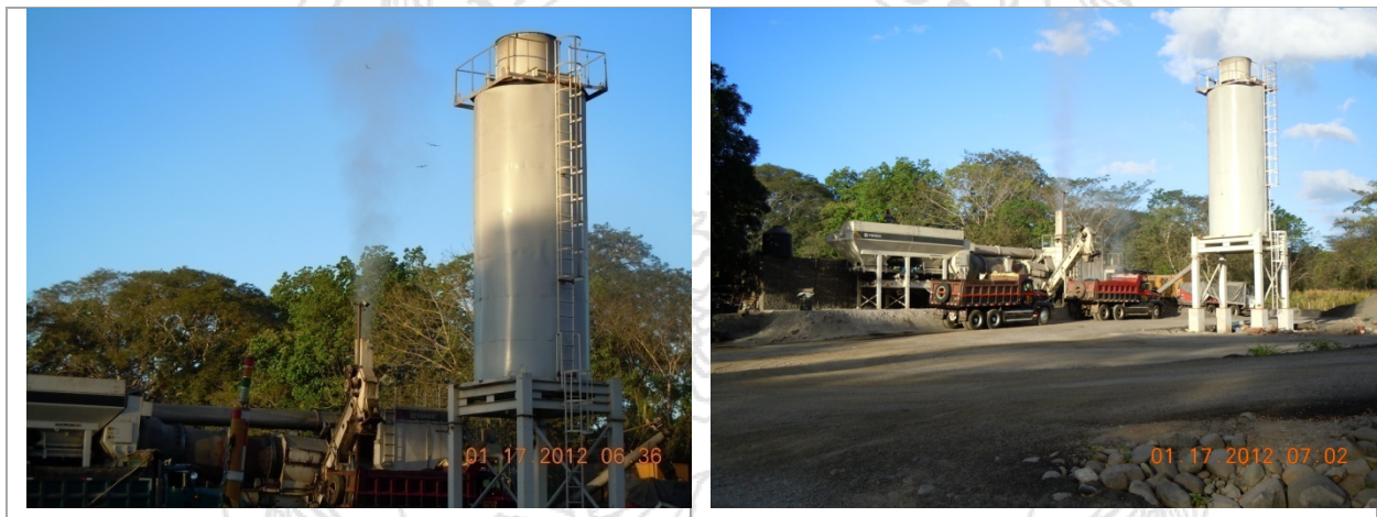
Fotografía 1 Silo principal de almacenaje de mezcla asfáltica producida sin utilizar
