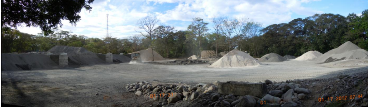
Fotografía 8 Zona de apilamientos de agregados.
