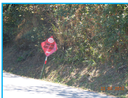
Fotografía 15: Señal confeccionada con un vinil de color que no corresponde a lo indicado en el contrato.
