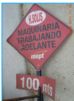
Fotografía 14: Señal confeccionada con un vinil material de color que no corresponde a lo indicado en el contrato.
