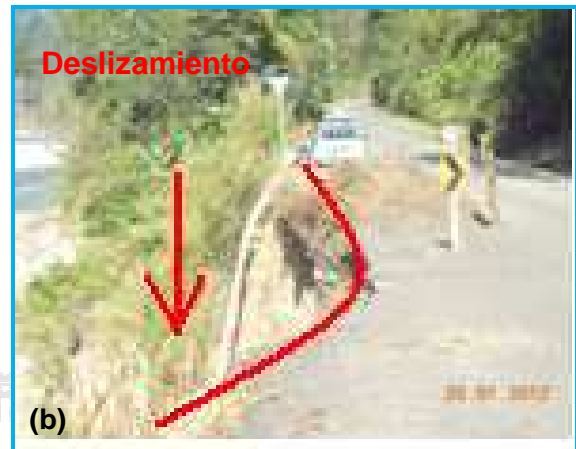
Fotografía 3. a) Uso de cola de pez, b) Deslizamiento paralelo al cauce del Río Térraba. Ubicación: aproximadamente 6 Km de Palmar Norte hacia Paso Real sobre la Ruta Nacional No.2. Fuente: Unidad de Auditoría Técnica, LanammeUCR.
