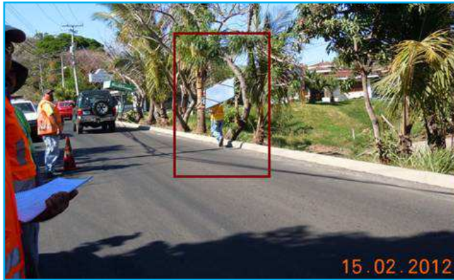
Fotografía 12: Se observa donde llevan el rótulo una vez que el Equipo Auditor hace presencia en el proyecto Ubicación: Guácima de Alajuela Fuente: Unidad de Auditoría Técnica, LanammeUCR.
