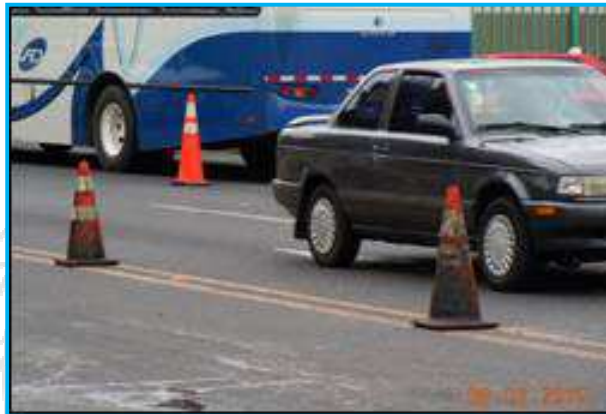
Fotografía 10: Conos con liga asfáltica y falta base de hierro.
