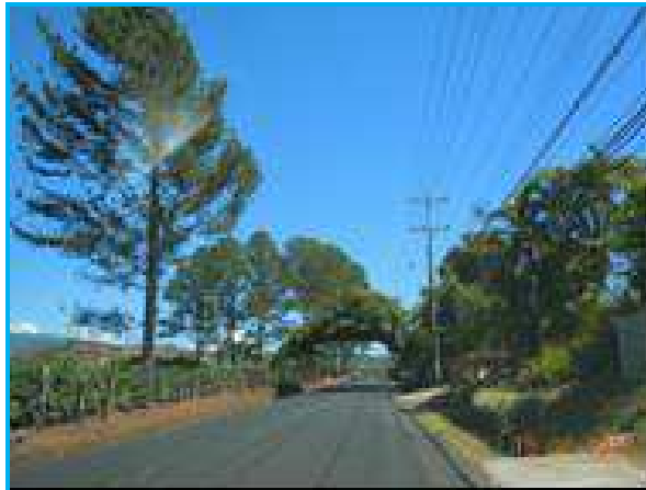
Fotografía A3: Ruta 107, desde la intersección con la Ruta 118 en el Cacao hacia San Pedro de Poás Visita: 15 de Febrero 2012. Fuente: Unidad de Auditoría Técnica, LanammeUCR.
