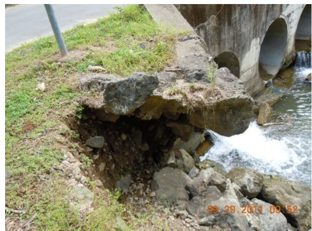
Figura 6: Fotografías de daños en alcantarilla sobre Río Zelaya. Taponamiento de entrada por troncos y sedimento, daños en los delantales de descarga, barandas y accesos
