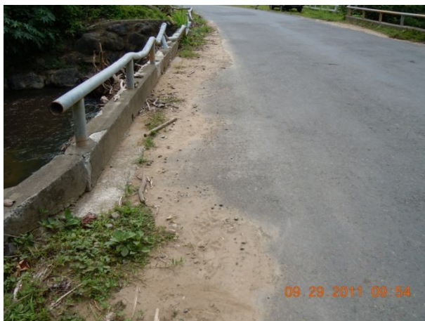
Figura 6: Fotografías de daños en alcantarilla sobre Río Zelaya. Taponamiento de entrada por troncos y sedimento, daños en los delantales de descarga, barandas y accesos
