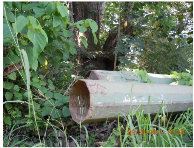
Figura 2: Fotografías de alcantarilla sobre Quebrada Congos. Ausencia de cabezales, aletones y delantales. Pérdida de material de relleno. Condiciones inseguras y señalización insuficiente. Vigas encontradas en sitio para posible construcción de puente.
