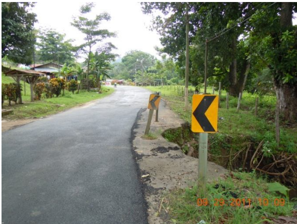
Figura 4: Alcantarilla sector de Valle Azul. Pérdida de material de relleno y reducción de vía a causa de socavación en alcantarillas.
