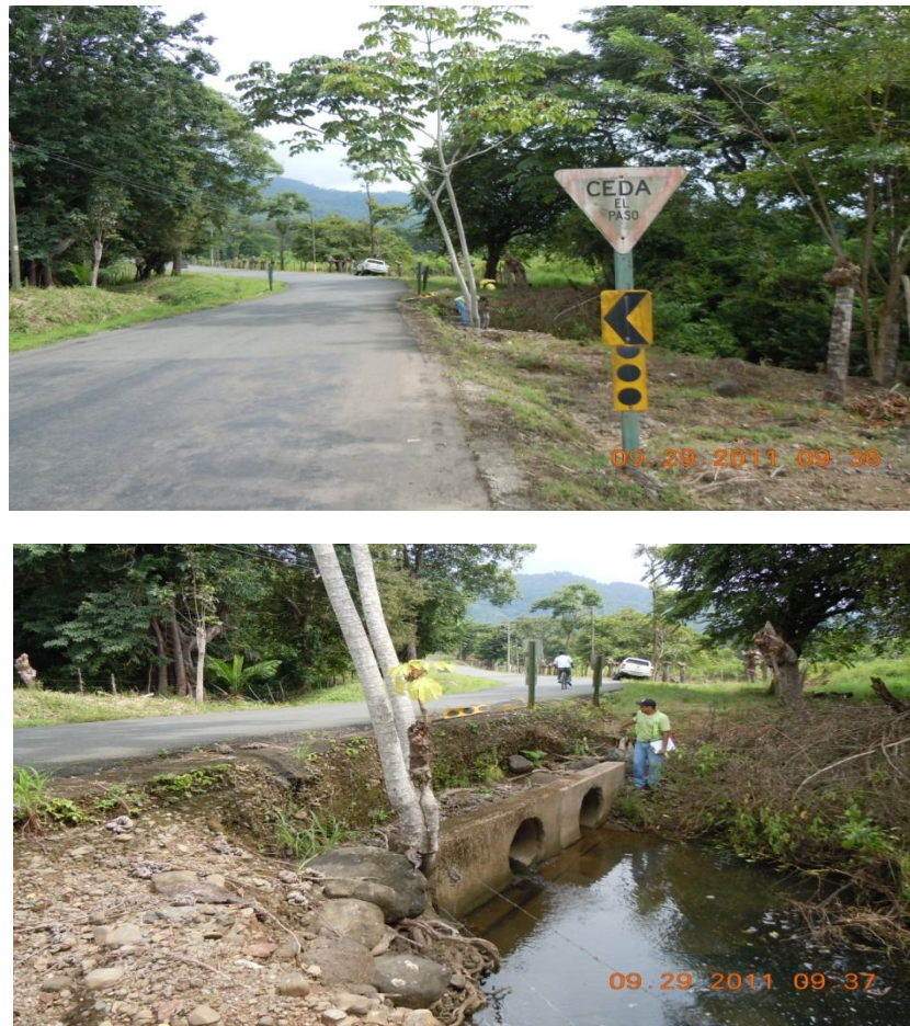
Figura 5: Alcantarilla sobre Quebrada Pica Pica. Señalización en mal estado y desnivel importante entre nivel de rasante y la alcantarilla.
