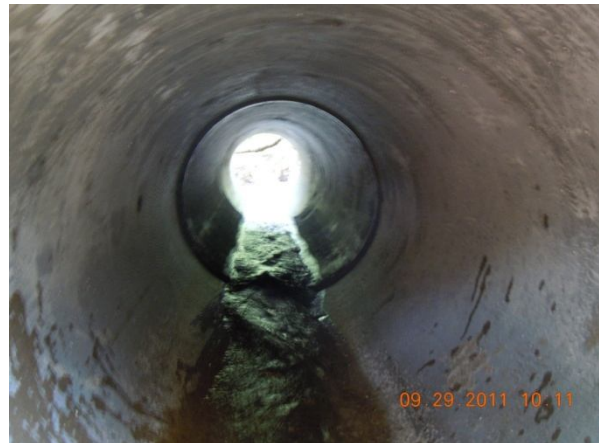
Figura 4: Alcantarilla sector de Valle Azul. Pérdida de material de relleno y reducción de vía a causa de socavación en alcantarillas.
