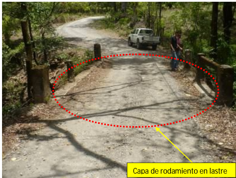
Figura 7. Superficie de rodamiento de lastre y con irregularidades.
