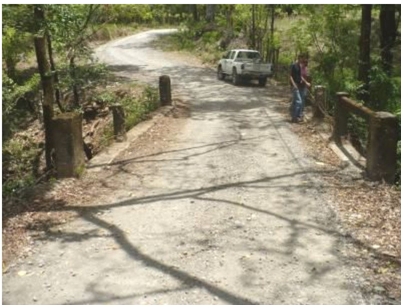
Figura 2. Vista a lo largo de la línea centro del puente La Libertad- Quebrada Honda
