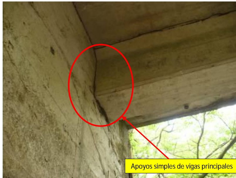
Figura 4. Apoyo simple de vigas principales,
