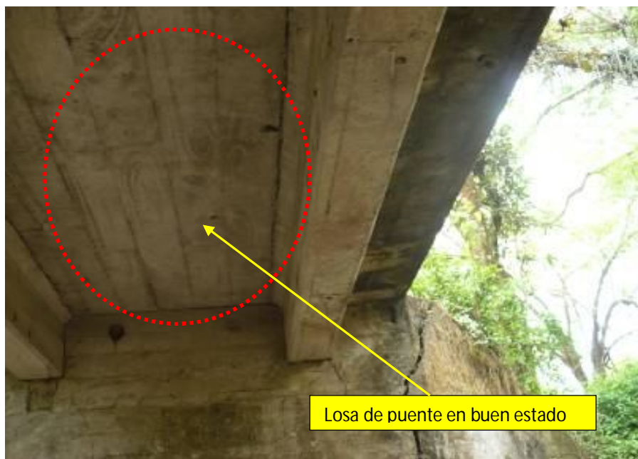
Figura 10. Losa de puente se encuentra en buen estado en su parte inferior.
