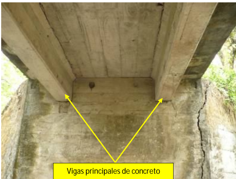
Figura 3. Vista inferior del puente La Libertad
