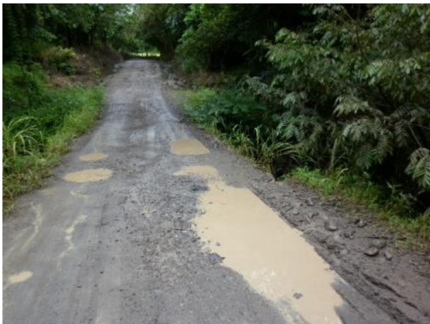
Figura 2. Vista a lo largo de la línea de centro del Puente Catsa, Quebrada Honda
