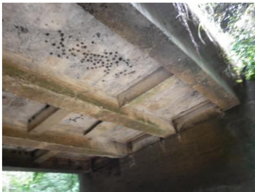
Figura 3. Vista inferior del puente Catsa en el sector Este
