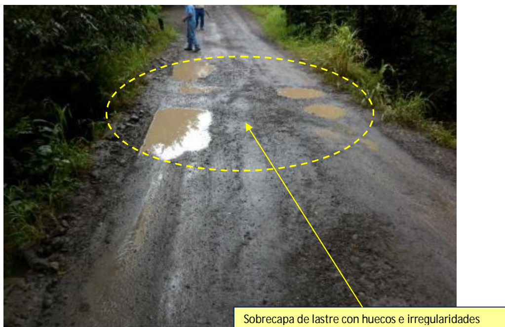
Figura 9. Estado de la superficie de rueda
