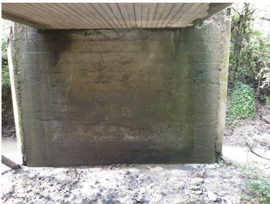
Figura 5. Pila central de apoyo
