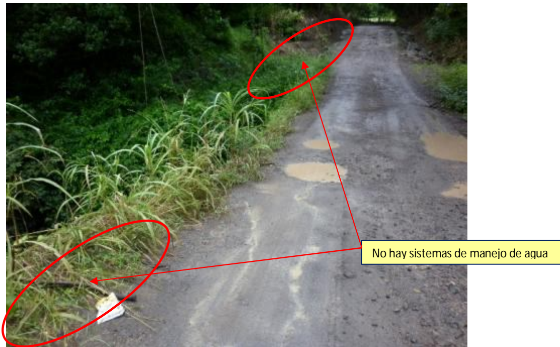
Figura 10. Accesos del puente presentan ausencia de drenajes laterales
