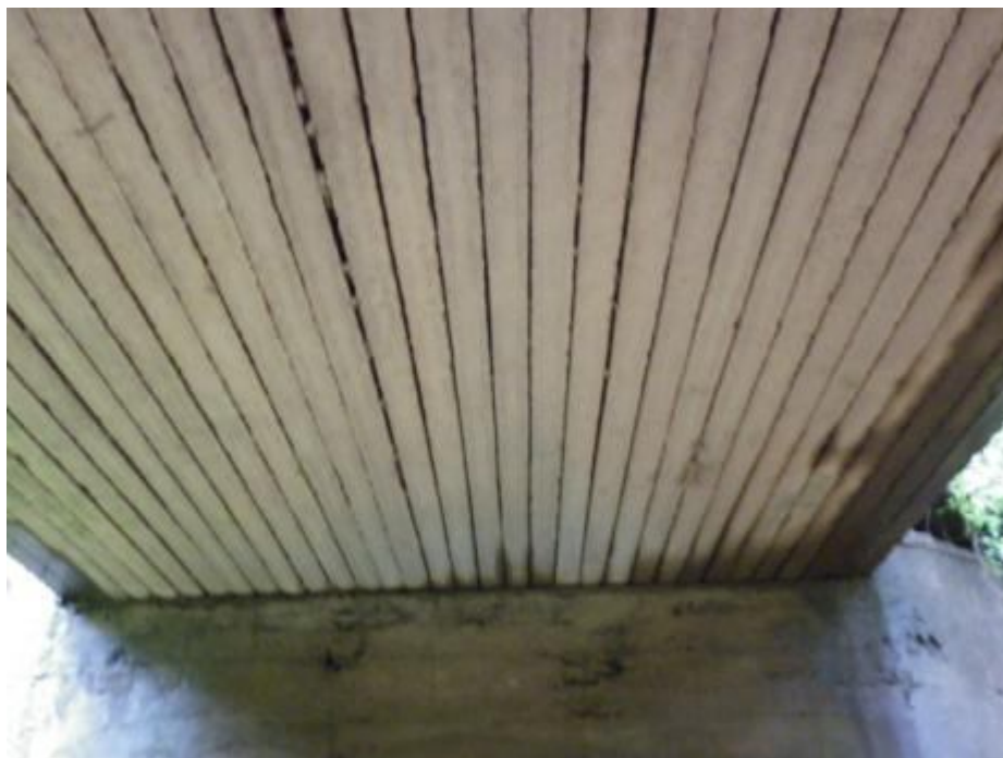
Figura 4. Vista inferior del puente Catsa en el sector Oeste
