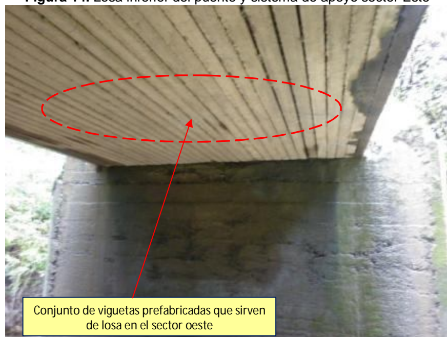
Figura 15. Losa inferior del puente y sistema de apoyo sector Oeste
