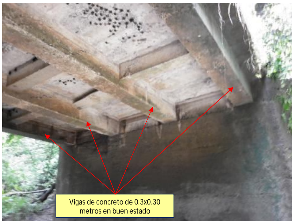
Figura 14. Losa inferior del puente y sistema de apoyo sector Este
