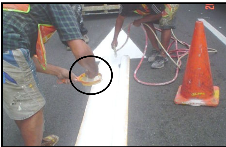
Fotografía No.1: Uso de un “colador” de cocina para la aplicación en campo de las microesferas de vidrio en una señal de flecha.
