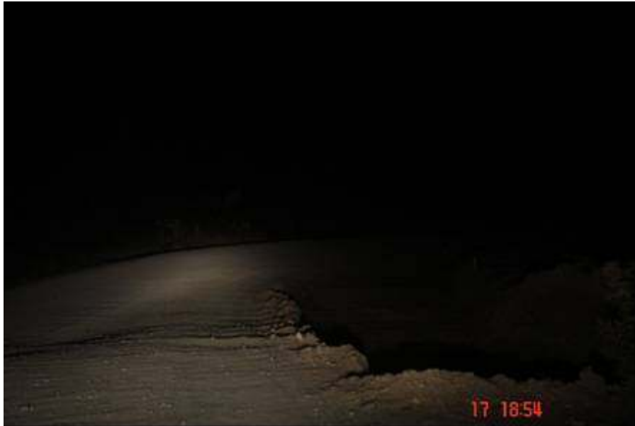
Fotografía No.9: Excavación realizada para la ampliación de la vía que no cuenta con ningún tipo de señalización. Fotografía fue tomada el 17 de marzo del 2009.
