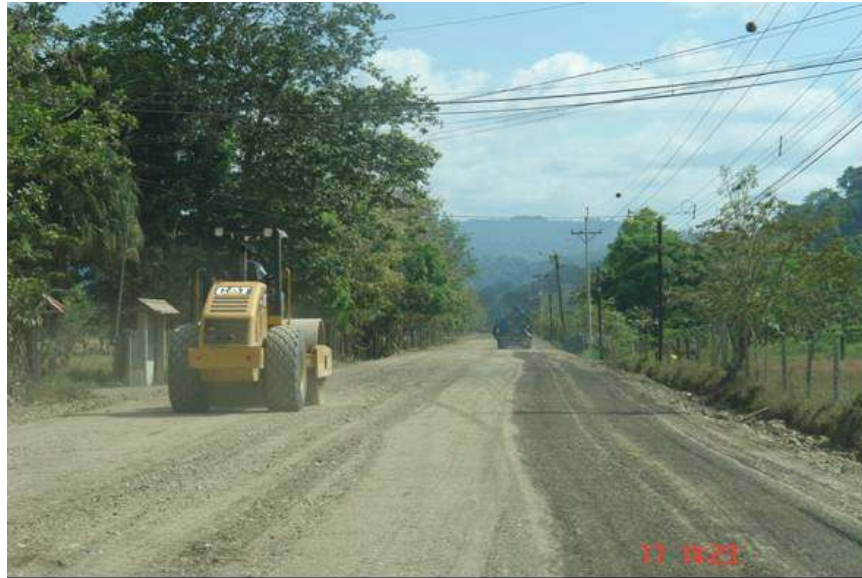
Fotografía No.2: Trabajos de compactación y de riego sobre el material recién colocado. No existe una canalización del tránsito. Fotografía tomada el 17 de marzo del año 2009.
