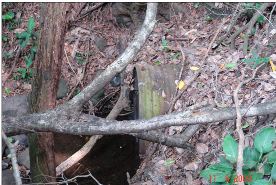
Fotografía 9. Alcantarilla Est. 99+460. (LanammeUCR, 2009).
