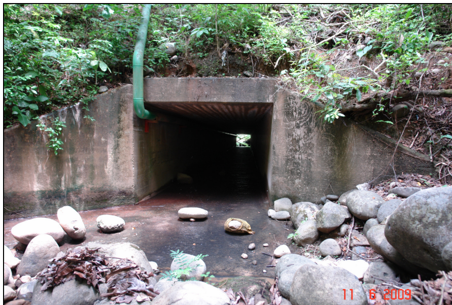
Fotografía 3. Paso de agua Est. 93+230. (LanammeUCR, 2009).
