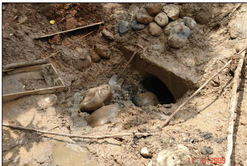
Fotografía 2. Alcantarilla Est. 92+500. (LanammeUCR, 2009).
