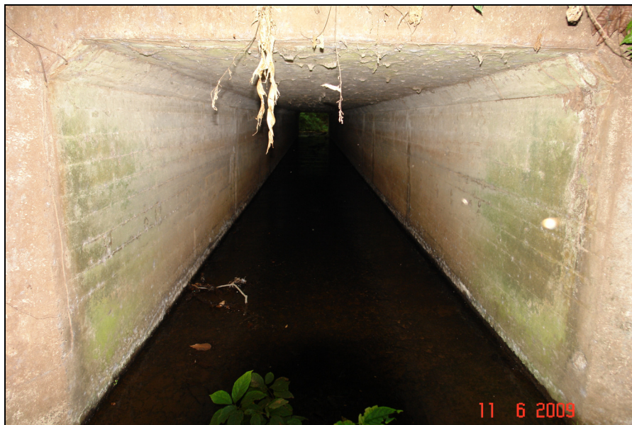
Fotografía 13. Alcantarilla Est. 103+130. (LanammeUCR, 2009).
