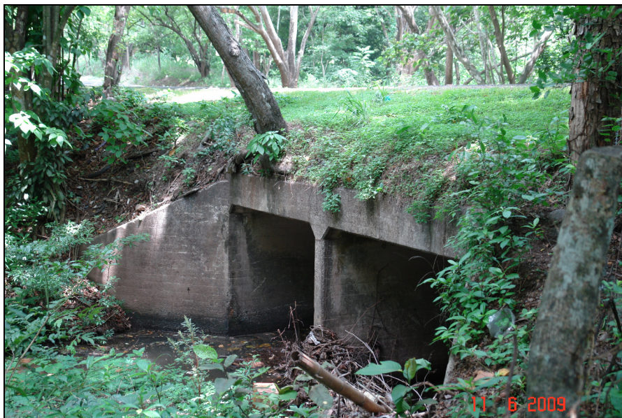
Fotografía 6. Alcantarilla doble Est. 96+170. (LanammeUCR, 2009).
