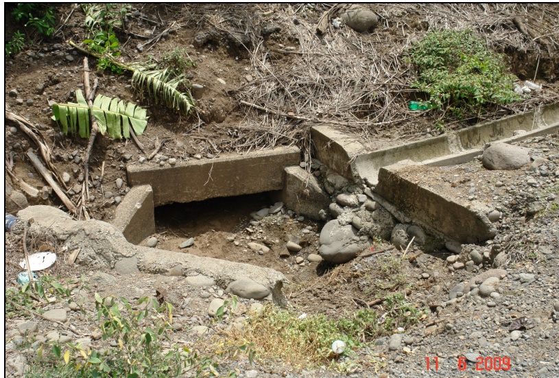
Fotografía 1. Alcantarilla Est. 91+720 (LanammeUCR, 2009).
