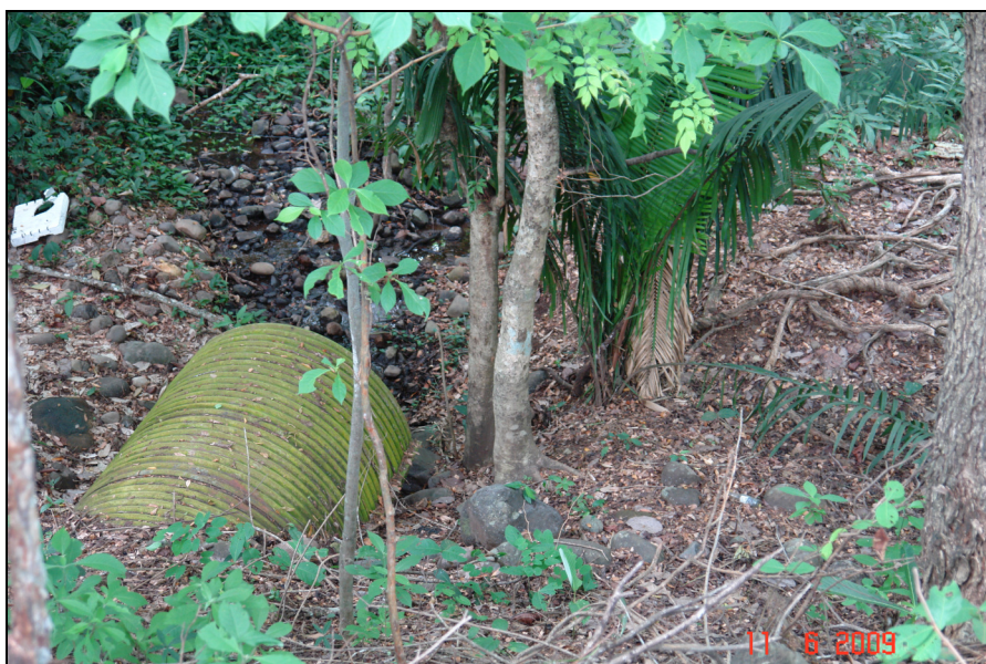
Fotografía 8. Alcantarilla Est. 98+880. (LanammeUCR, 2009).
