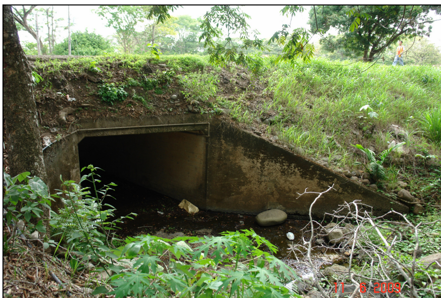
Fotografía 12. Alcantarilla Est. 102+300. (LanammeUCR, 2009).
