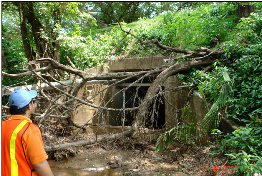
Fotografía 5. Paso de agua Est. 94+980. (LanammeUCR, 2009).
