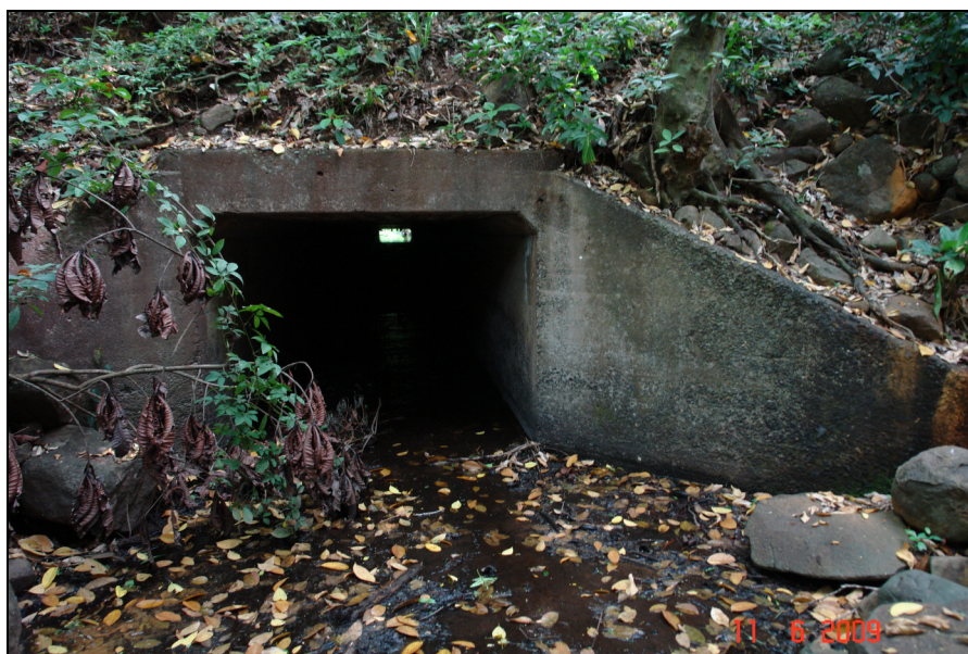
Fotografía 14. Alcantarilla Est. 106+350. (LanammeUCR, 2009)
