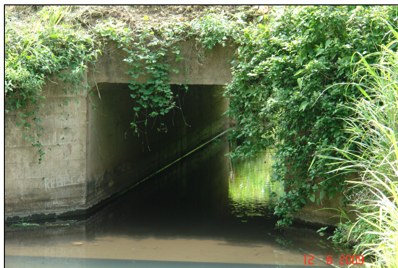
Fotografía 16. Paso de agua Est. 163+990. (LanammeUCR, 2009).
