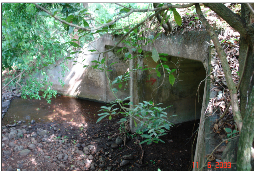
Fotografía 10. Alcantarilla Est. 100+430. (LanammeUCR, 2009).
