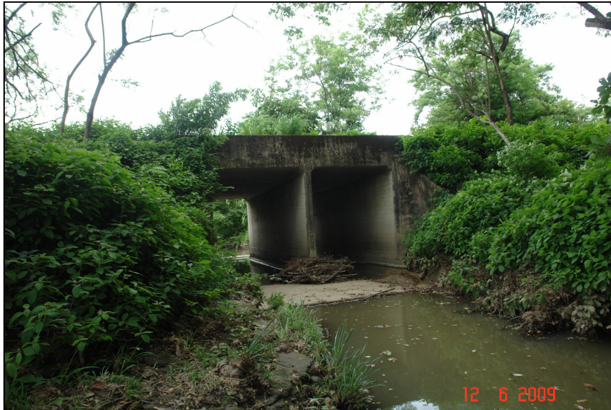
Fotografía 17. Paso de agua Est. 201+540. (LanammeUCR, 2009).
