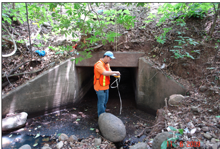
Fotografía 4. Paso de agua Est. 94+650. (LanammeUCR, 2009).
