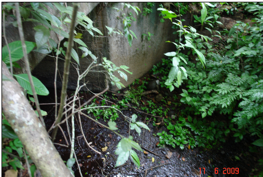
Fotografía 11. Alcantarilla Est. 100+700. (LanammeUCR, 2009).
