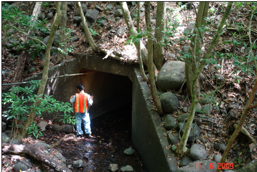
Fotografía 7. Alcantarilla Est. 98+220. (LanammeUCR, 2009).
