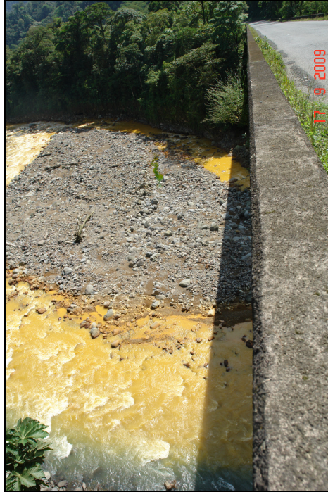
Fotografía 15. Depositación de material en fondo del cauce del Río Sucio. (LanammeUCR, 2009).
