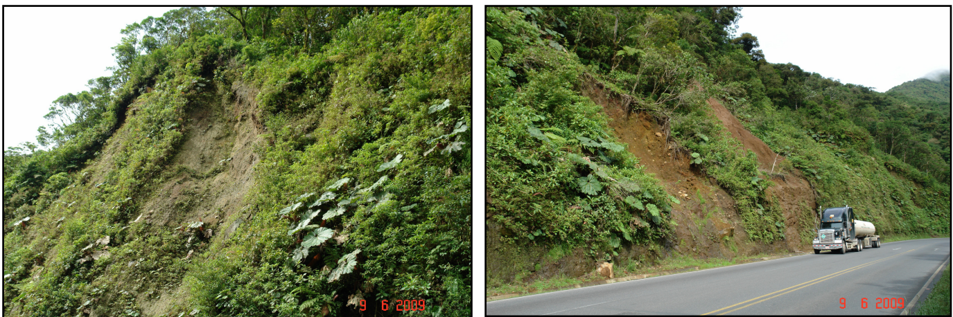
Fotografías 1 y 2. Deslizamientos registrados entre estacionamientos 18+400 y 18+700.
