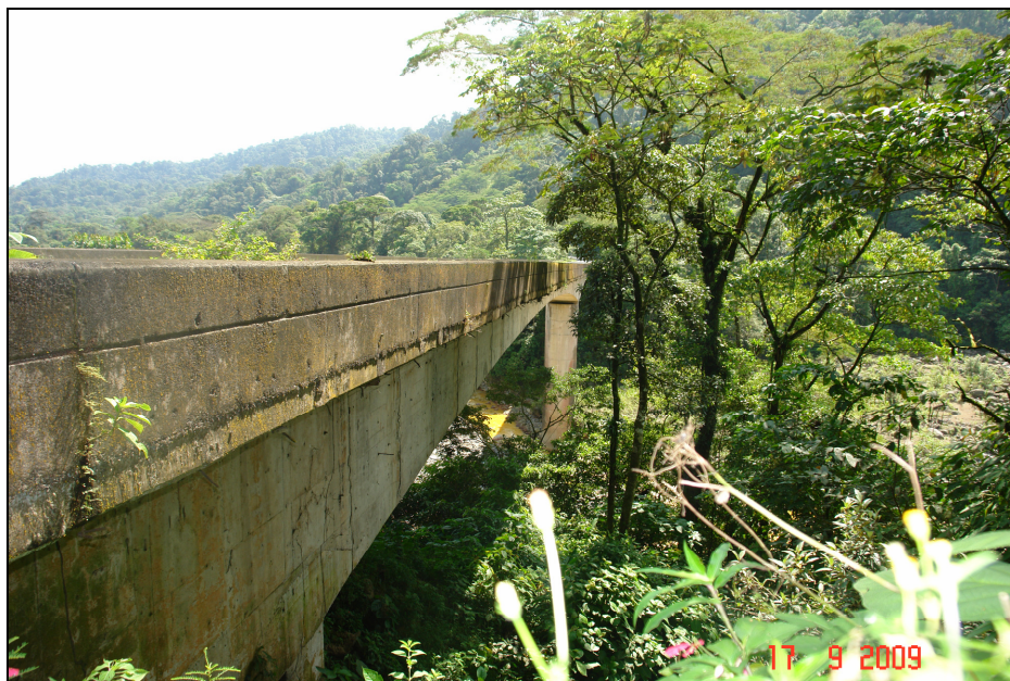
Fotografía 12. Puente sobre el Río Sucio. (LanammeUCR, 2009)
