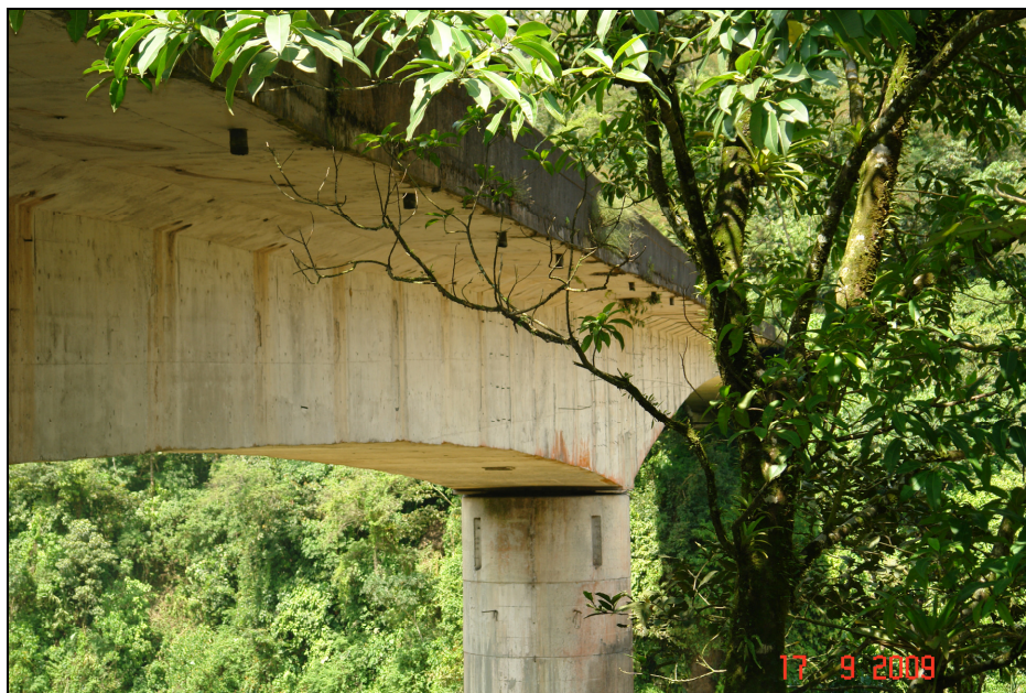
Fotografía 11. Puente sobre el Río Sucio. (LanammeUCR, 2009)
