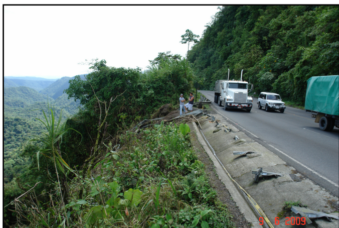
Fotografías 9 y 10. Deslizamiento registrados entre estacionamientos 25+700 y 25+850.
