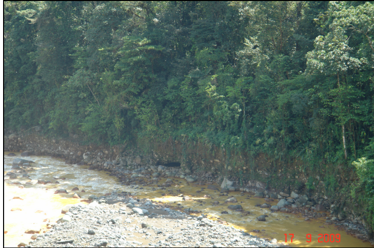
Fotografía 13. Erosión en cauce Río Sucio, aguas abajo del puente. (LanammeUCR, 2009).
