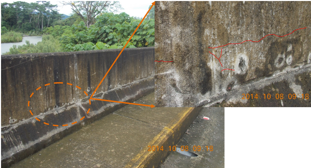
Figura 1: Estado de las barreras vehiculares; porosidad, grietas y agujeros en el concreto.
