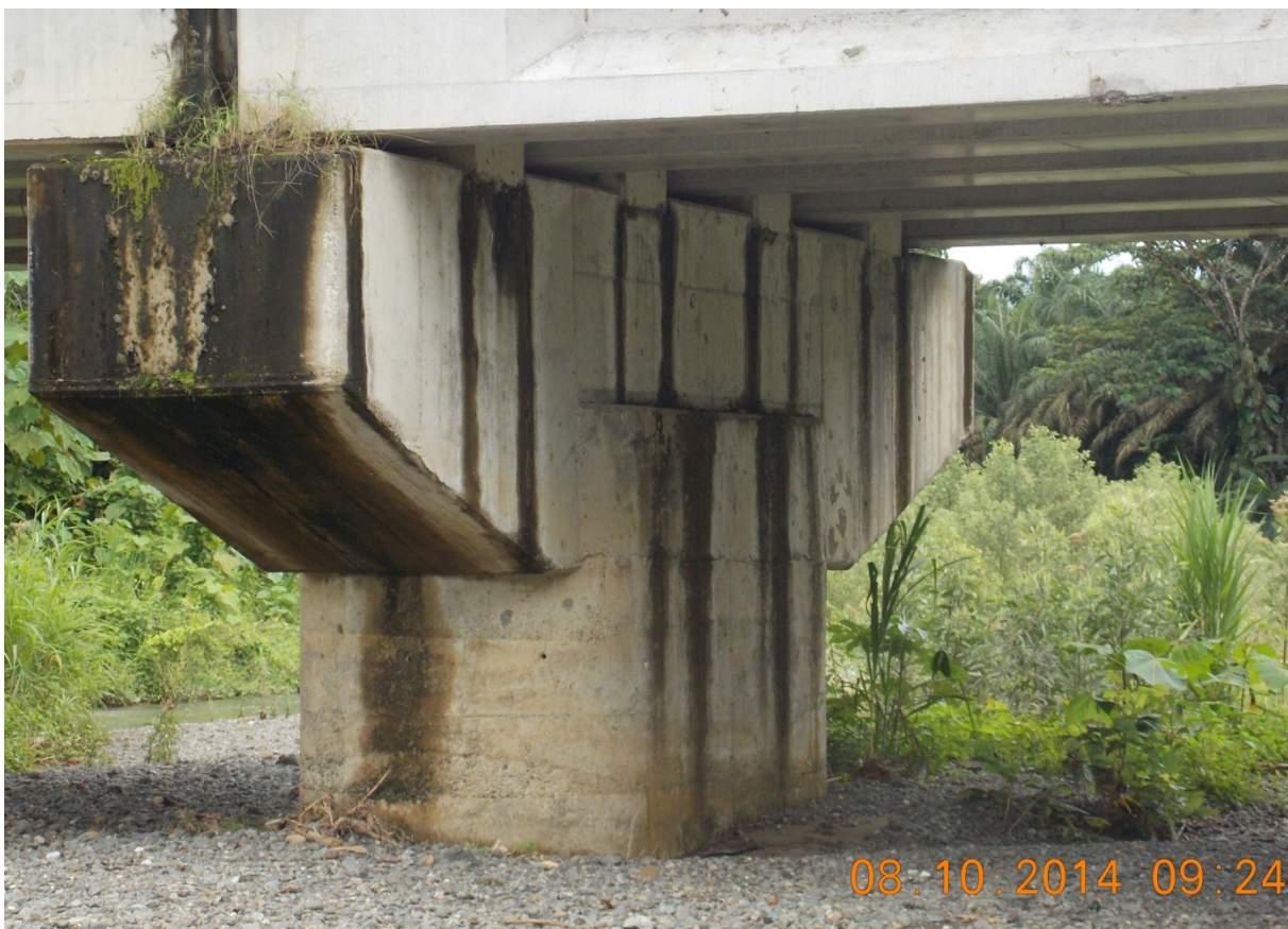
Figura 13: Evidencia de filtraciones al cuerpo de la pila 1 desde las juntas, presencia de vegetación sobre el cabezal de la pila.
