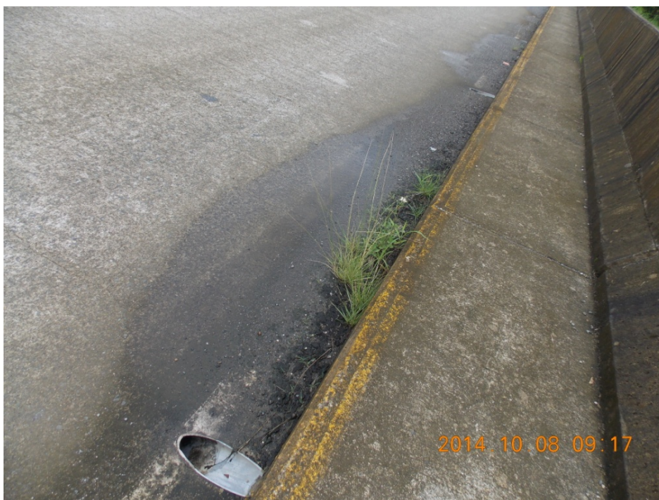
Figura 4: Estado regular, poco visible de la demarcación vial.
