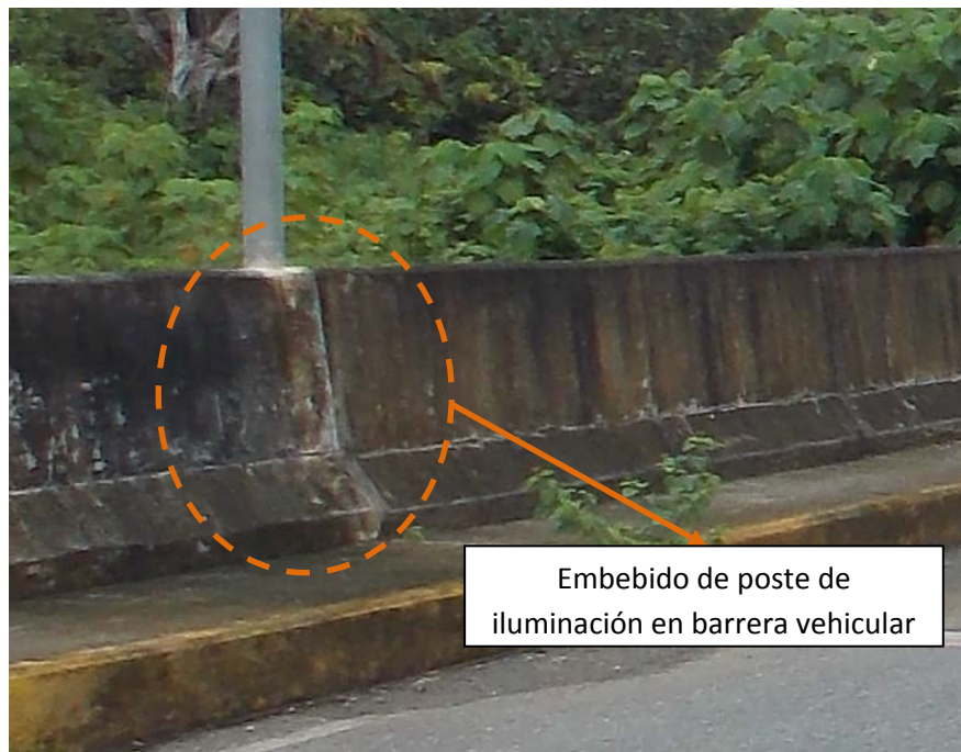
Figura 5: Poste de iluminación embebido en la barrera vehicular.
