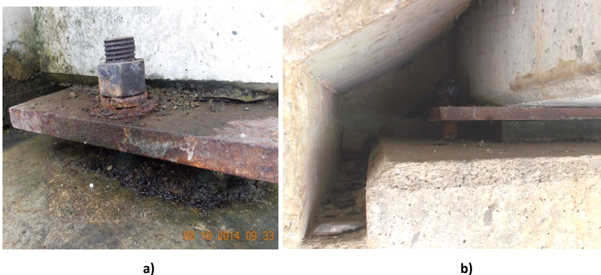
Figura 10: Apoyos en bastiones: a) corrosión en las placas de acero a los costados del puente; b) acumulación de escombros y detalle neopreno/placa de acero
