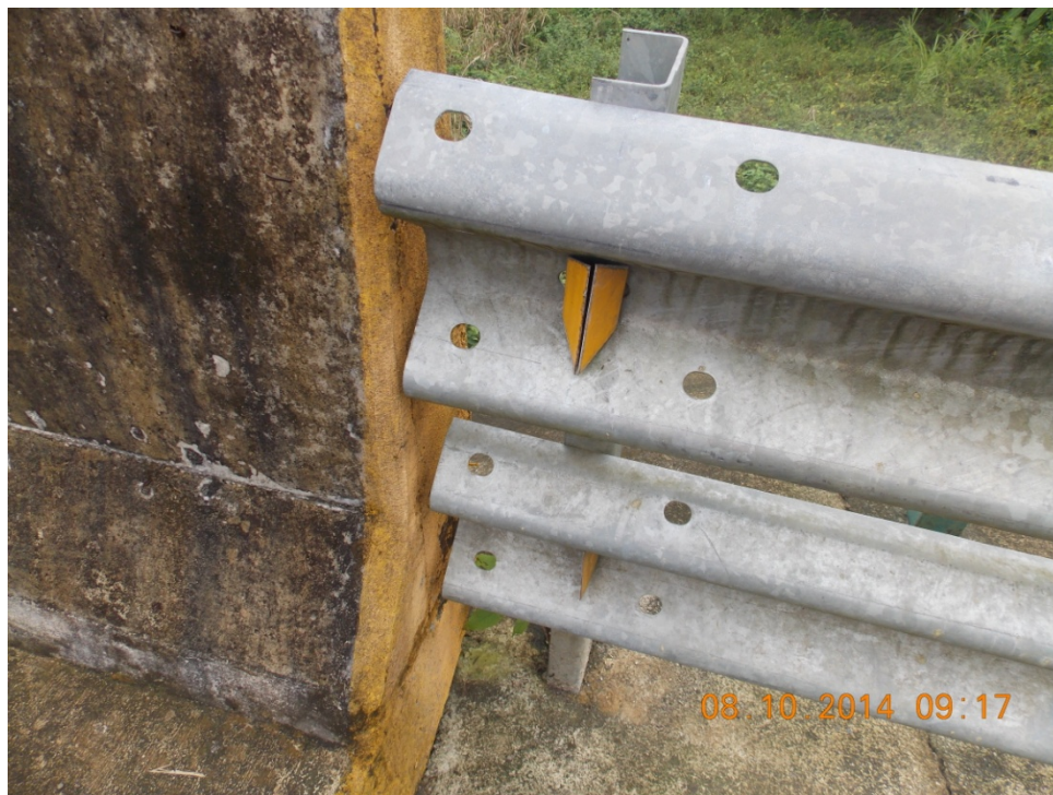
Figura 2: Barrera vehicular y guardavía desvinculados.
