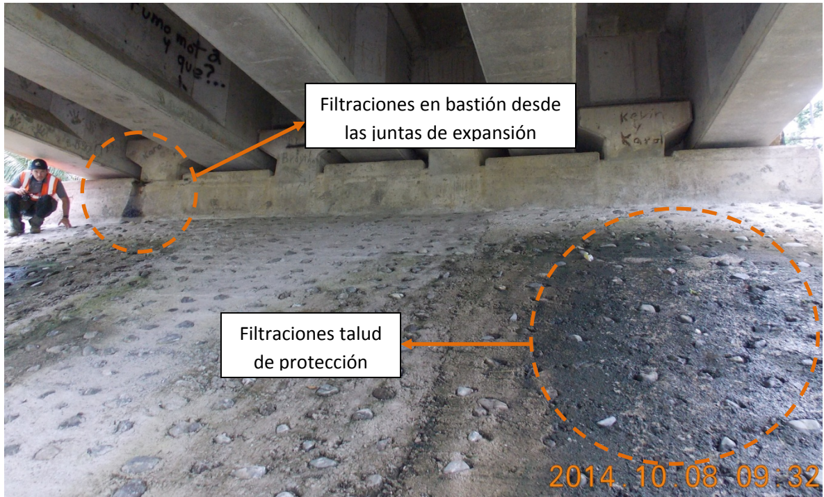
Figura 11: Evidencia de filtraciones de agua sobre el bastión 1 y el talud de protección.
