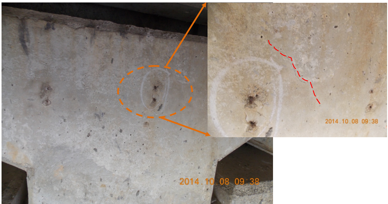
Figura 12: Presencia de grietas y agujeros en las llaves de cortante del bastión 1.
