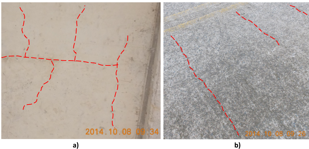
Figura 8: Patrones de agrietamiento en losa: a) cara inferior; b) cara superior.
