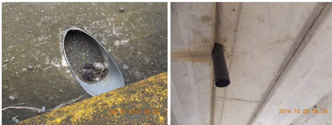
Figura 6: Tubería de drenaje obstruida e insuficiente longitud de desarrollo del tubo de drenaje.
