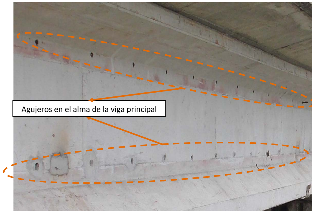
Figura 9: Agujeros en almas de las vigas principales
