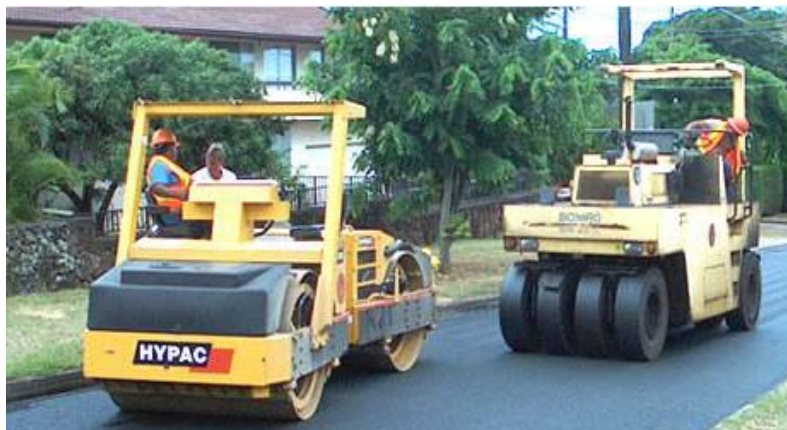
Figura 9: Compactador de rodillo y de llanta de hule.
