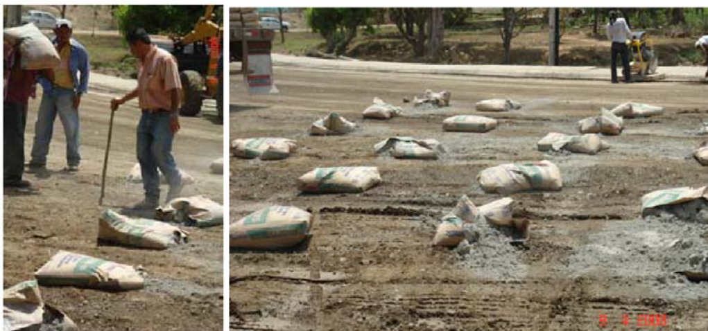
Figura 7: Dosificación manual de cemento en polvo
