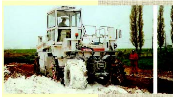
Figura 10: Construcción con cal.
