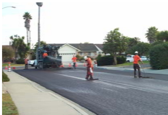
d. Trabajo manual en la junta longitudinal Tomada de presentación Intermountain 2006 ISSA President Award
