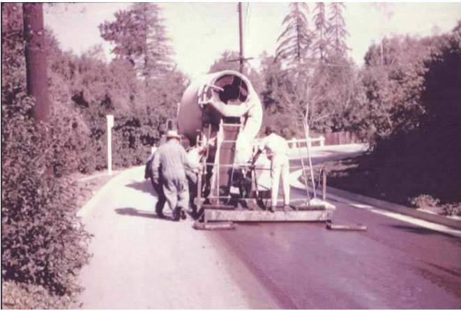
a. Primer sello de lechada asfáltica
