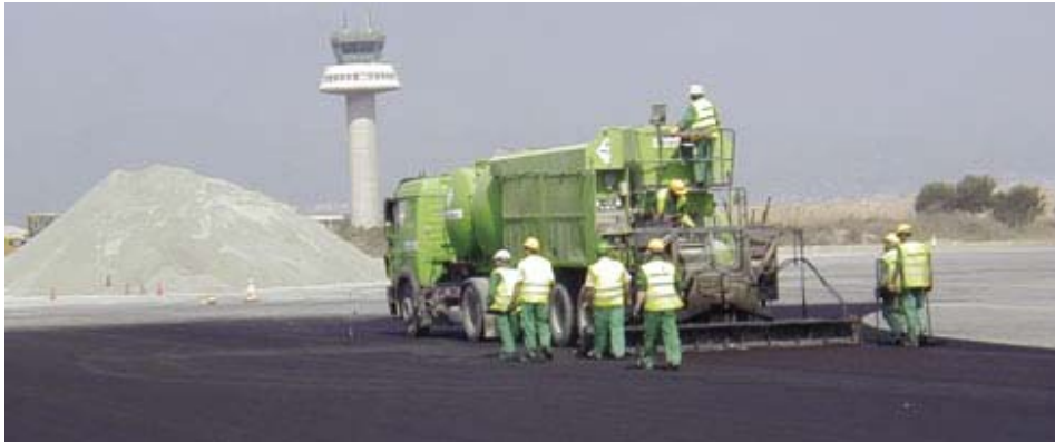
Figura 14: Aplicación de sellos de lechada asfáltica en Aeropuerto de Barcelona.
