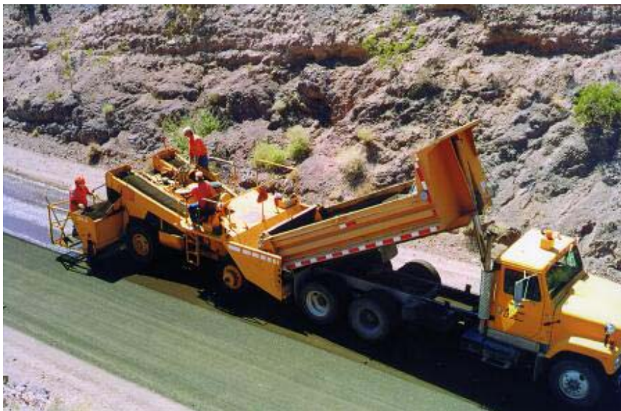
Figura 5: Sello de arena (Sand seal). Foto cortesía de Western Emulsion
