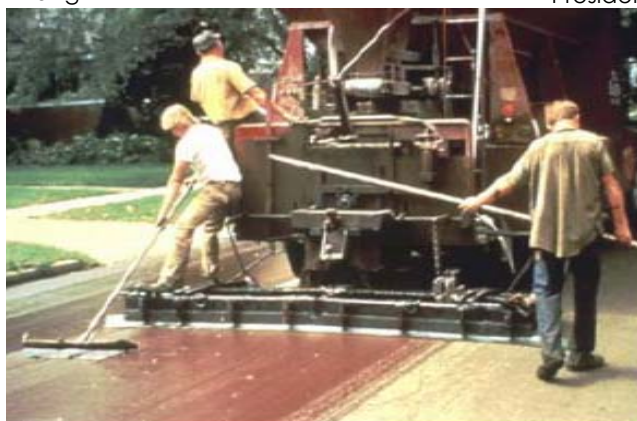
c. Rastrillo con trapeador al igual que la caja distribuidora Tomada de presentación de Richard Sampson y Dustin Lang
