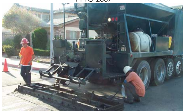
d. Uso de tela en el enrasador Figura tomada de Presentación de Intermountain en ISSA 2006
