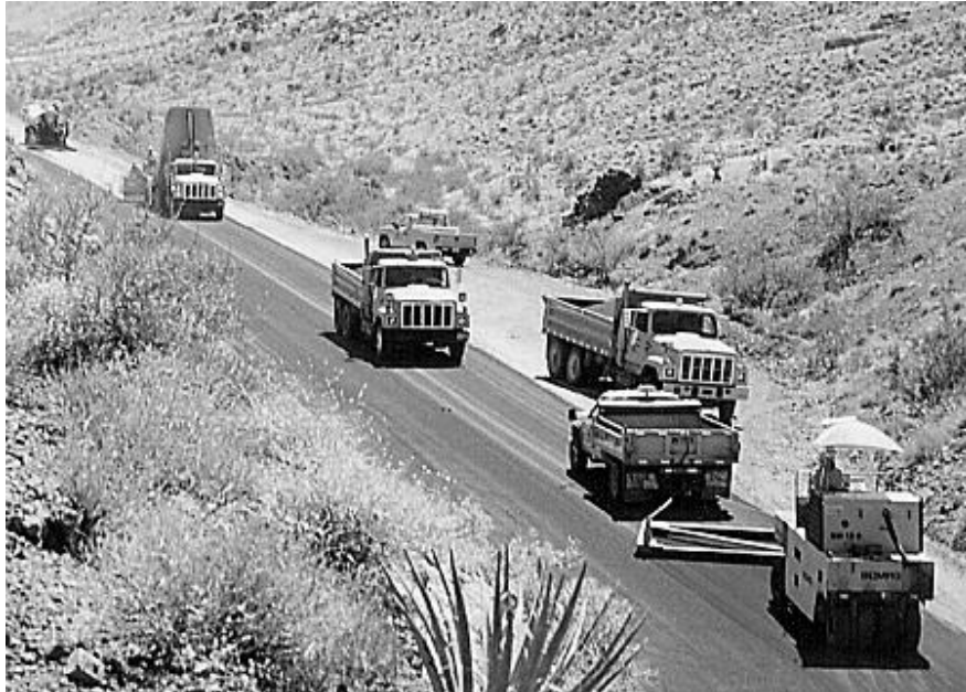
Figura 6: Proceso de colocación del sello de arena (Scrub seal). Foto cortesía de Western Emulsion
