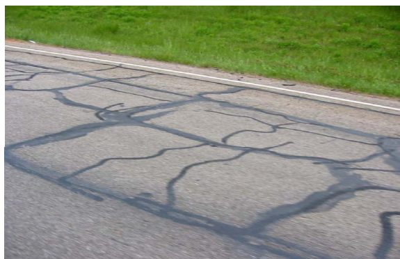
a. Sellado de fisuras
