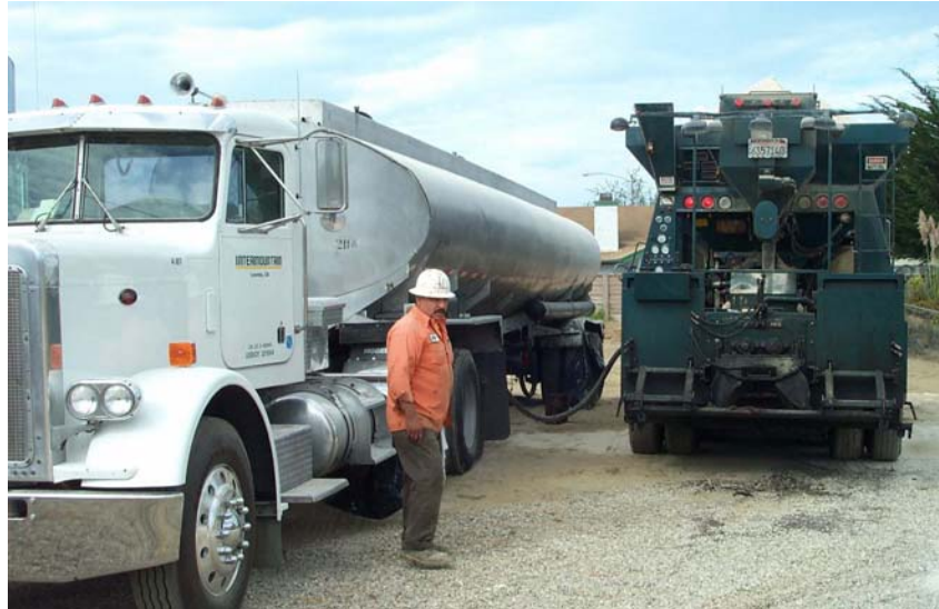
Figura 32: Carga de la emulsión en la máquina mezcladora.
