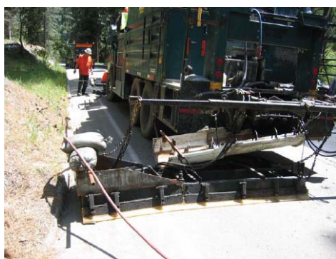
c. Uso de dispositivos especiales para distintas geometrías Figura tomada de Presentación de Scott Metcalf en Conferencia PPTG 2007
