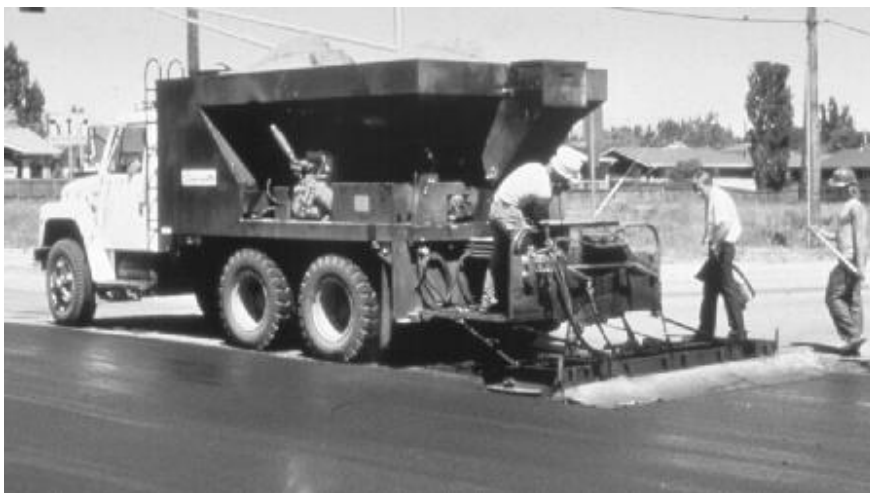
Figura 8: Aplicación de un sello de lechada asfáltica.
