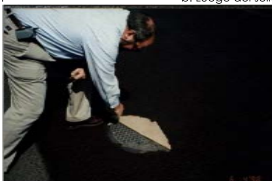
c. Remoción de la protección
