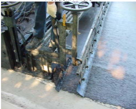
c. Junta línea central Tomada de presentación de Scott Metcalf, PPTG 2007 Conference
