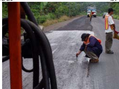
c. Equipo de mezclado y colocación
