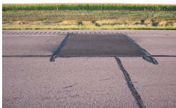
b. Reparación de baches
