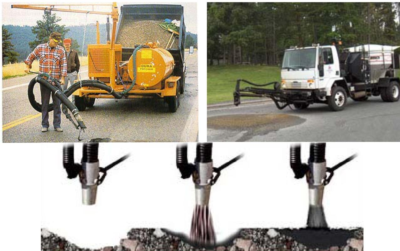
**Figura 40:** Técnica de inyección a presión.
