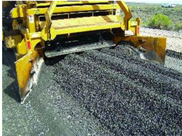
**Figura 30:** Mezcla colocada en el carril en camellón.
