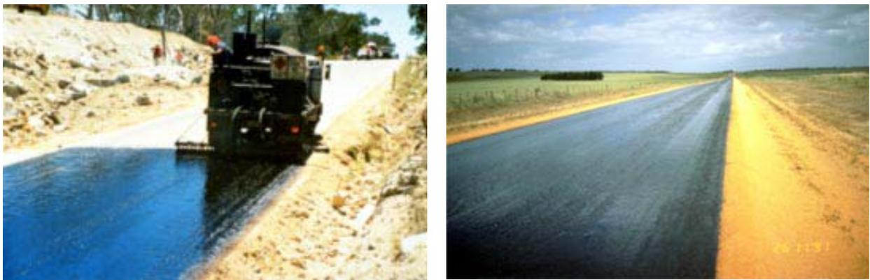
**Figura 26:** Aplicación de la capa de imprimación.
