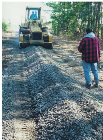
**Figura 28:** Camellón de agregado antes del mezclado.
