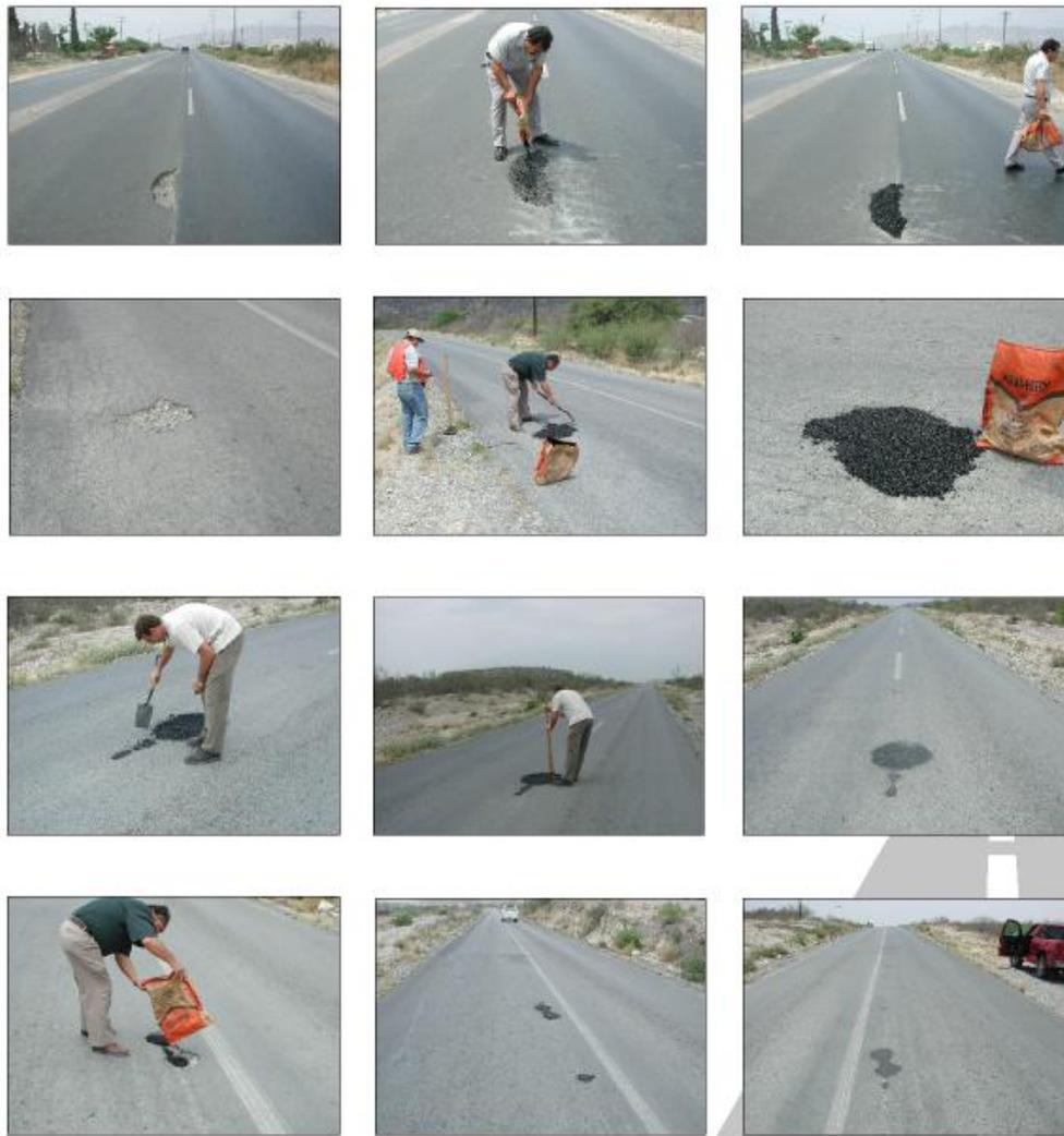
**Figura 38:** Técnica colocar y compactar.
