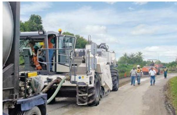
**Figura 16:** Equipo de reciclado en frío en sitio.
