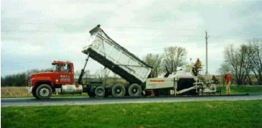
**Figura 18:** Equipo planta móvil equipada con tolva.
