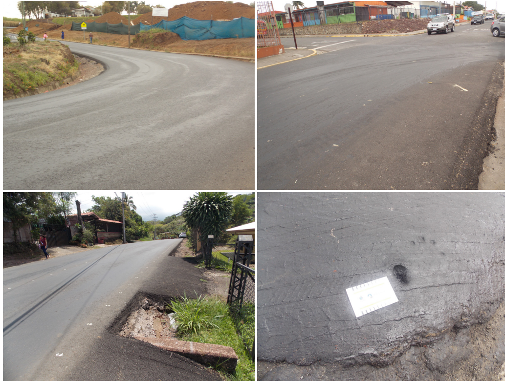
Figura 6. Exceso de mezcla asfáltica en la superficie de una carretera Fuente: Unidad de Auditoría Técnica (PITRA-LanammeUCR), 2018
