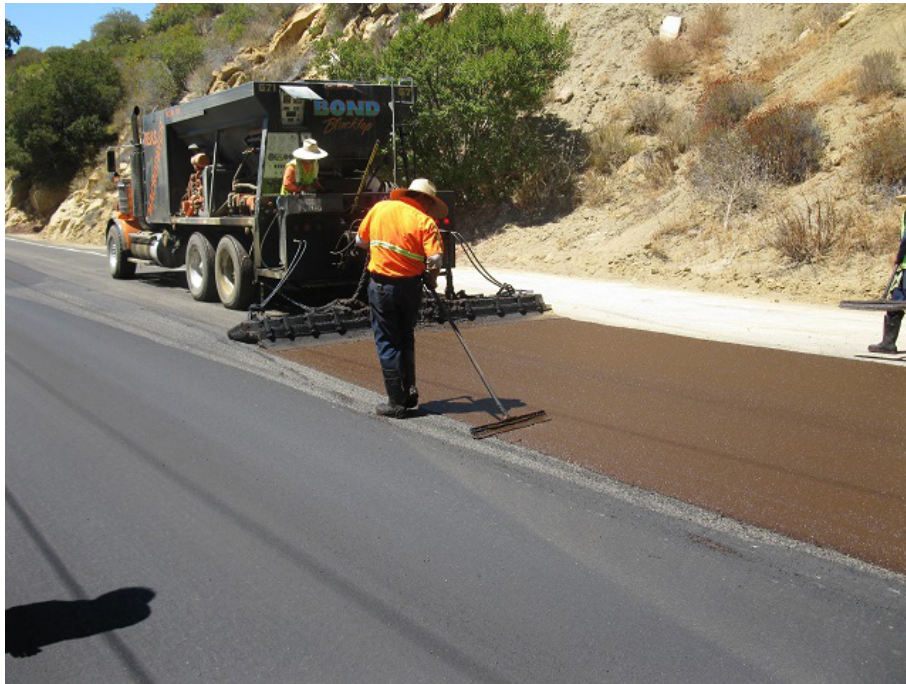
Figura 9. Colocación de microsuperficie.
