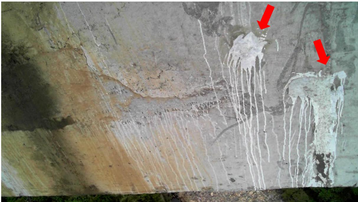
Figura 22. Vista más cercana de las reparaciones realizadas en la pared aguas abajo de la viga cajón
