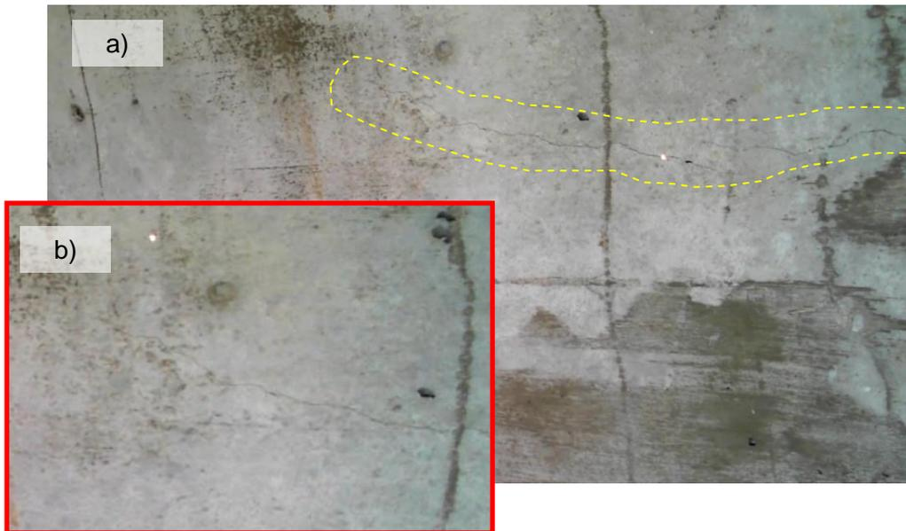
Figura 16. Posible grieta inclinada cerca de nodo 49 a) extensión total, b) acercamiento de extremo izquierdo de la grieta
