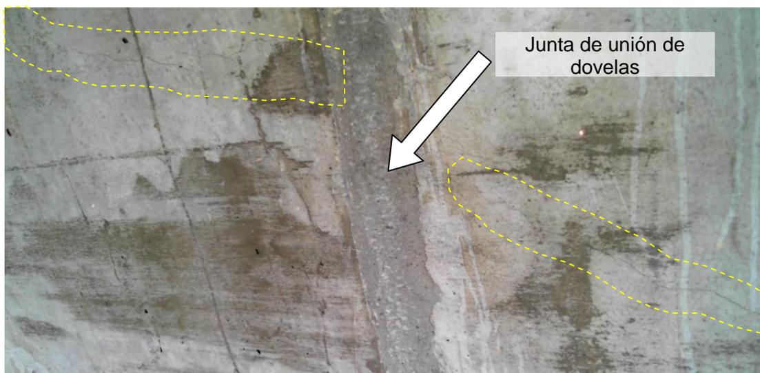
Figura 18. A la izquierda, parte superior del posible agrietamiento y a la izquierda, posible extensión del agrietamiento después de la junta de unión de dovelas
