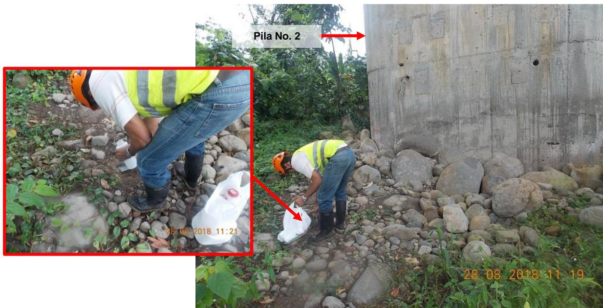
**Figura A.3.** Extracción de la muestra de suelo en Pila No. 2 (Suelo P2).
