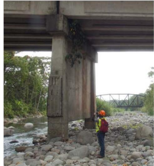
**F52:** Puente sobre el río Cimarrones. Socavación de los elementos de la subestructura que no ha alcanzado las cimentaciones.
