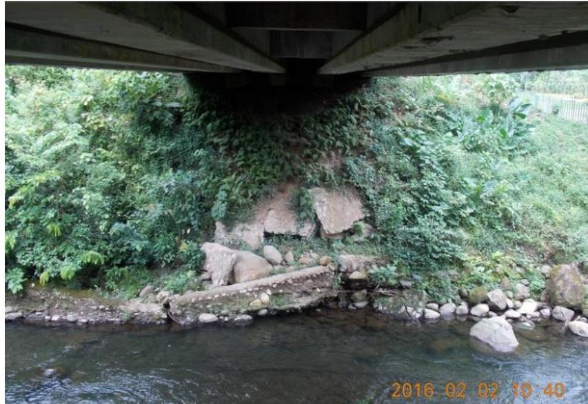
**F28:** Puente sobre el río Guacimito. Colapso de la protección del talud ubicado frente al bastión 2.
