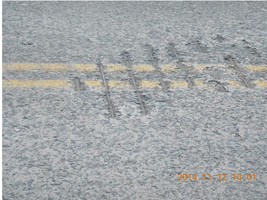
**F46:** Puente sobre el río Pacuare. Exposición del refuerzo principal en la losa del tablero
