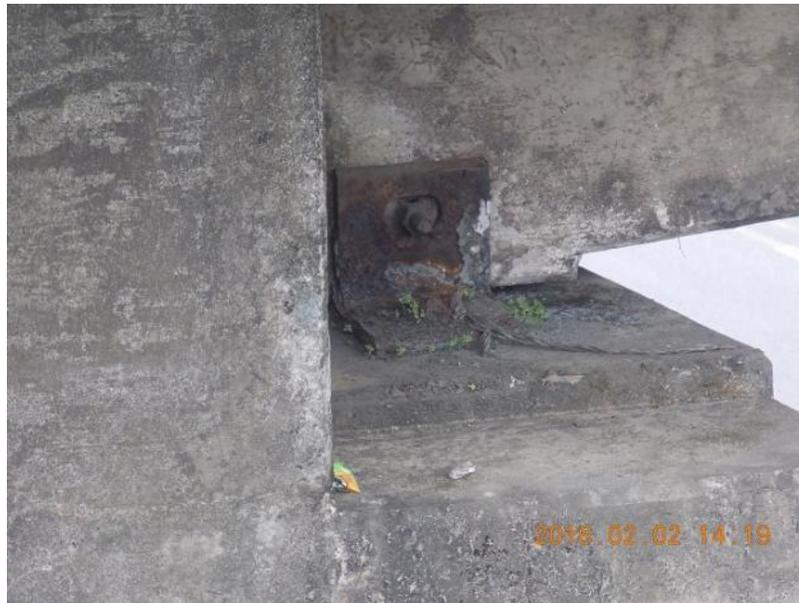
**F42:** Paso sobre Ruta Nacional No. 32. Oxidación generalizada en los elementos metálicos de apoyo exterior sobre el bastión 1
