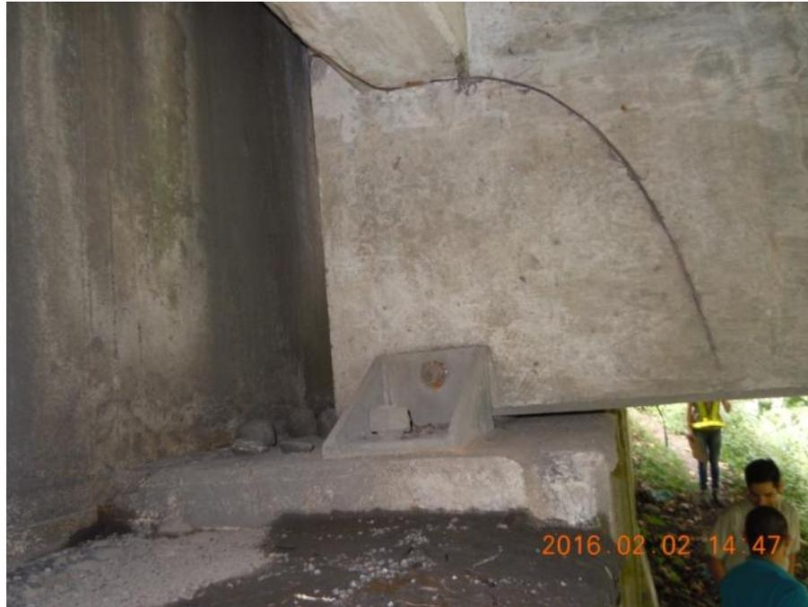
**F38:** Paso sobre el ferrocarril. Oxidación de perno en elemento metálico de un apoyo sobre el bastión 2.
