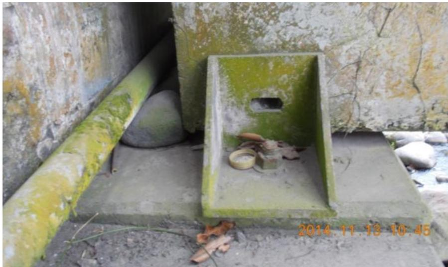
**F12:** Puente sobre el río Blanco (Guápiles). Pernos faltante en elementos de apoyo sobre el bastión 2 y musgo cubriendo el elemento debido a ambiente húmedo.
