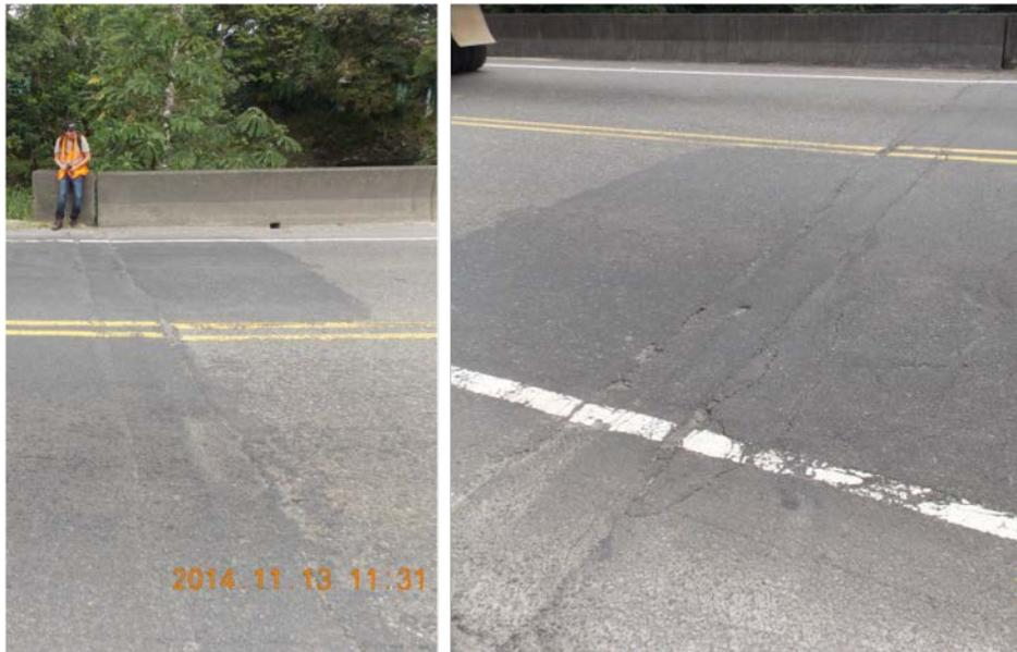
**F8:** Puente sobre el río Costa Rica. Obstrucción de las juntas de expansión con una sobrecapa asfáltica.
