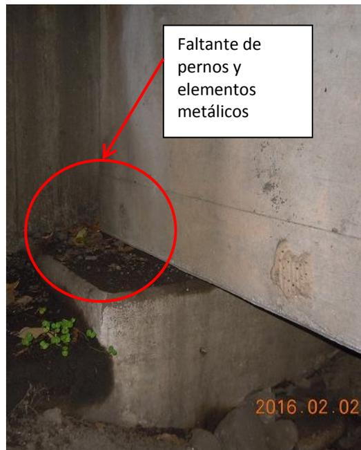
**F24:** Puente sobre el río Guácimo. Apoyos en contacto con sedimentos, oxidación de elementos metálicos y de pernos.
