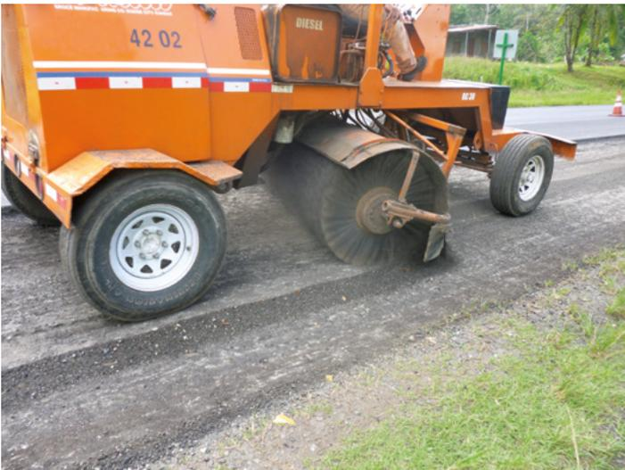
**Figura 18. Limpieza de la superficie a intervenir con barredora mecánica**
