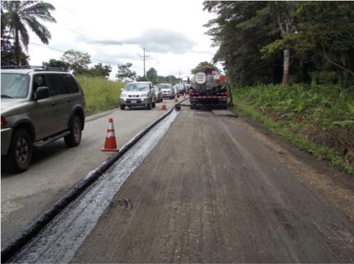
Figura 34. Adecuada cobertura en cortes de junta longitudinal
