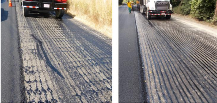
**Figura 48. Cobertura no uniforme (riego de liga en rayas) producto de incorrecta altura de la barra rociadora y/o inadecuada presión del bombeo de emulsión**
