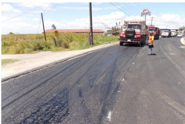
Figura 59. Vagonetas estacionadas sobre el riego de liga
