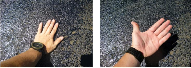
Figura 36. Tiempo de curado antes de la colocación de la sobrecapa
