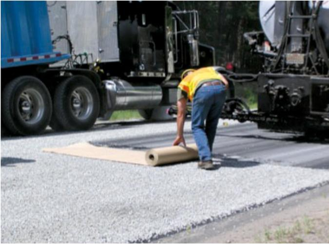
**Figura 19. Colocación de papel en juntas**
