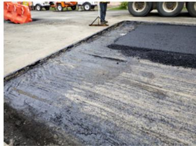
Figura 53. Cobertura deficiente en las juntas longitudinales y transversales
