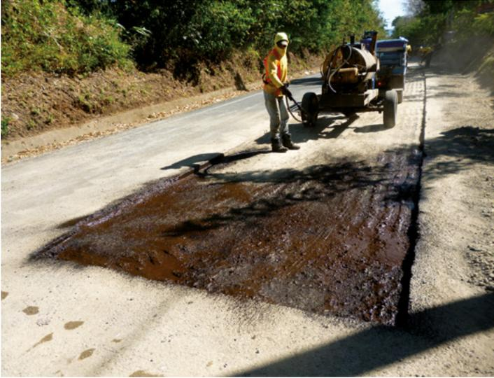
**Figura 40. Riego de liga excesivo para compensar superficie empolvada**
