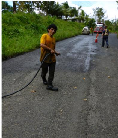
Figura 54. Aplicación manual del riego de liga sin equipo de seguridad
