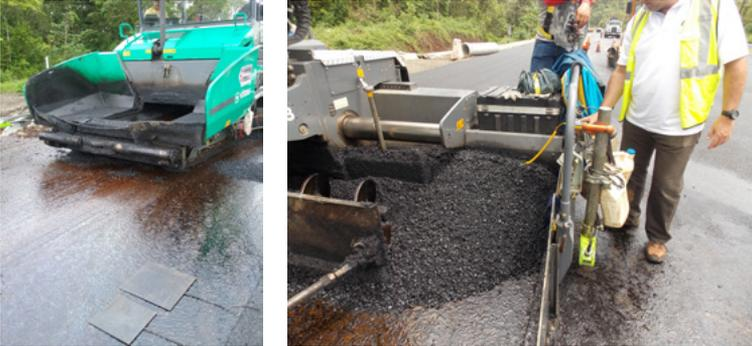
Figura 61. Colocación de mezcla asfáltica sobre emulsión sin romper y con humedad
