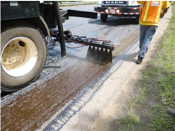
Figura 33. Cobertura triple del material, re aplicación de emulsión en área donde se perdió el riego de liga
