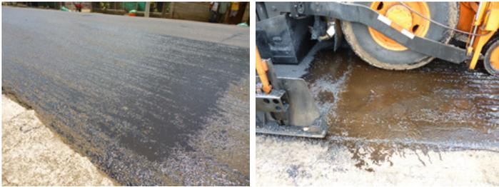
Figura 56. Concentración de riego de liga por traslape entre aplicaciones en tramos adyacentes
