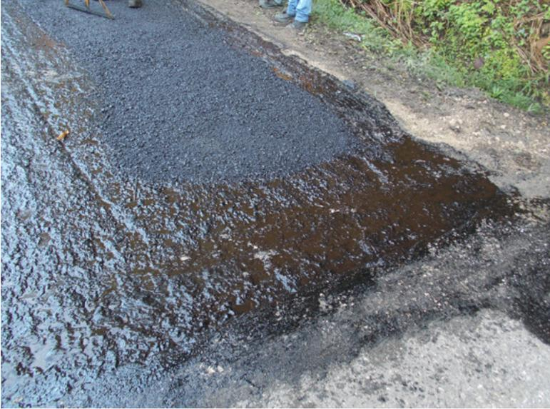
**Figura 62. Colocación mezcla asfáltica en emulsión sin romper**
