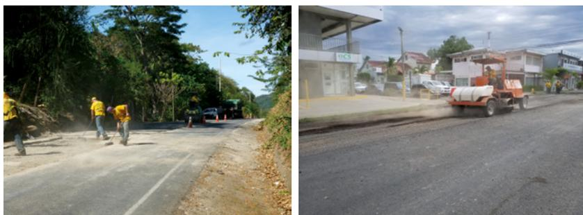
Figura 27. Limpieza de la superficie a intervenir con cepillos o barredora mecánica
