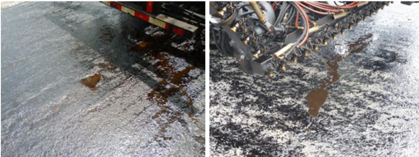
Figura 57. Derrame de emulsión asfáltica debido a fugas en la barra rociadora del camión dosificador
