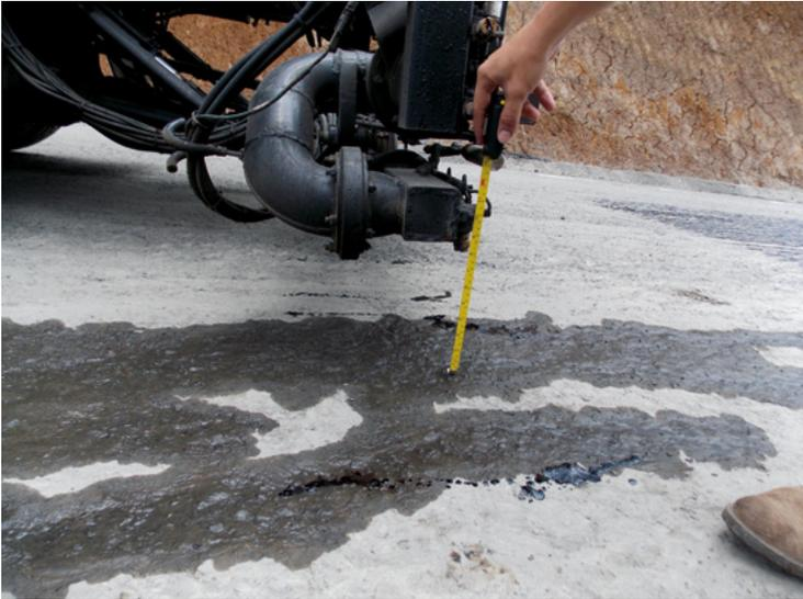
Figura 31. Medición de la altura de la barra rociadora respecto a la superficie
