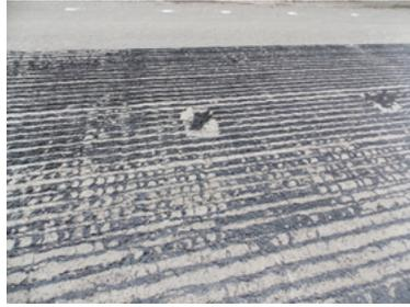
Figura 52. Tasas de aplicación de emulsión asfáltica menores a las señaladas por la ingeniería de proyecto. La cobertura del riego de liga de las áreas ensayadas es deficiente
