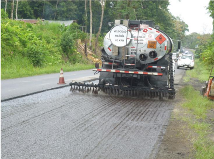
Figura 32. La aplicación del riego de liga es uniforme y homogénea, con paredes recubiertas
