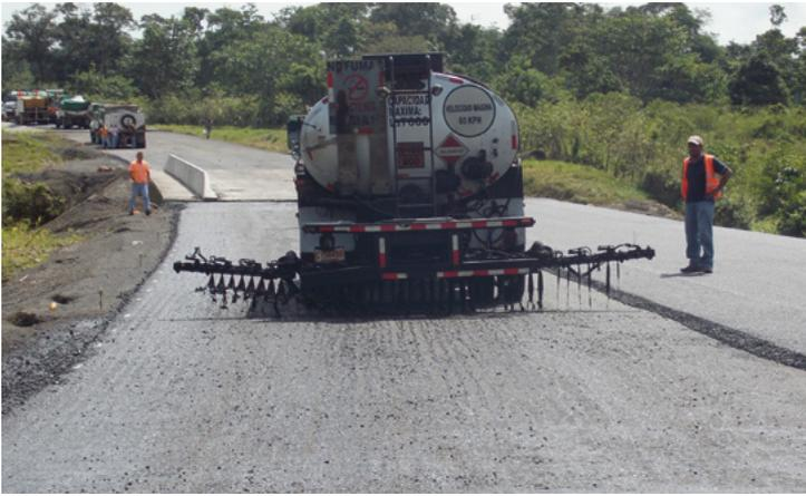
Figura 46. Variación de la altura a lo largo de la barra rociadora
