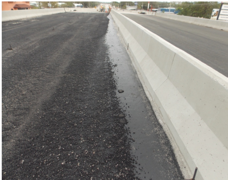
Fotografía 1. Mezcla colocada en los sobre el tablero del intercambio de Liberia. Ubicación: Sobre la Ruta 1 ,Intercambio de Liberia Sección Cañas Liberia, Fecha 10 de setiembre de 2015. Fuente: LanammeUCR.
