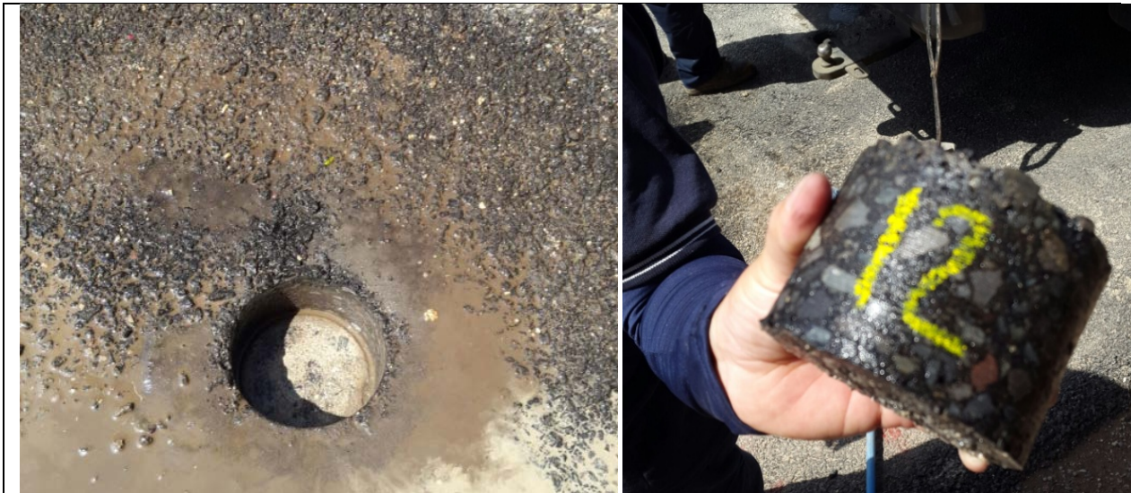
Fotografía 9 y 10. Extracción de núcleos en la carpeta asfáltica. Ubicación: Sobre la Ruta 1 Ramales ,Intercambio de Bagaces Sección Cañas Liberia , Fecha 30 de setiembre de 2015. Fuente: LanammeUCR.
