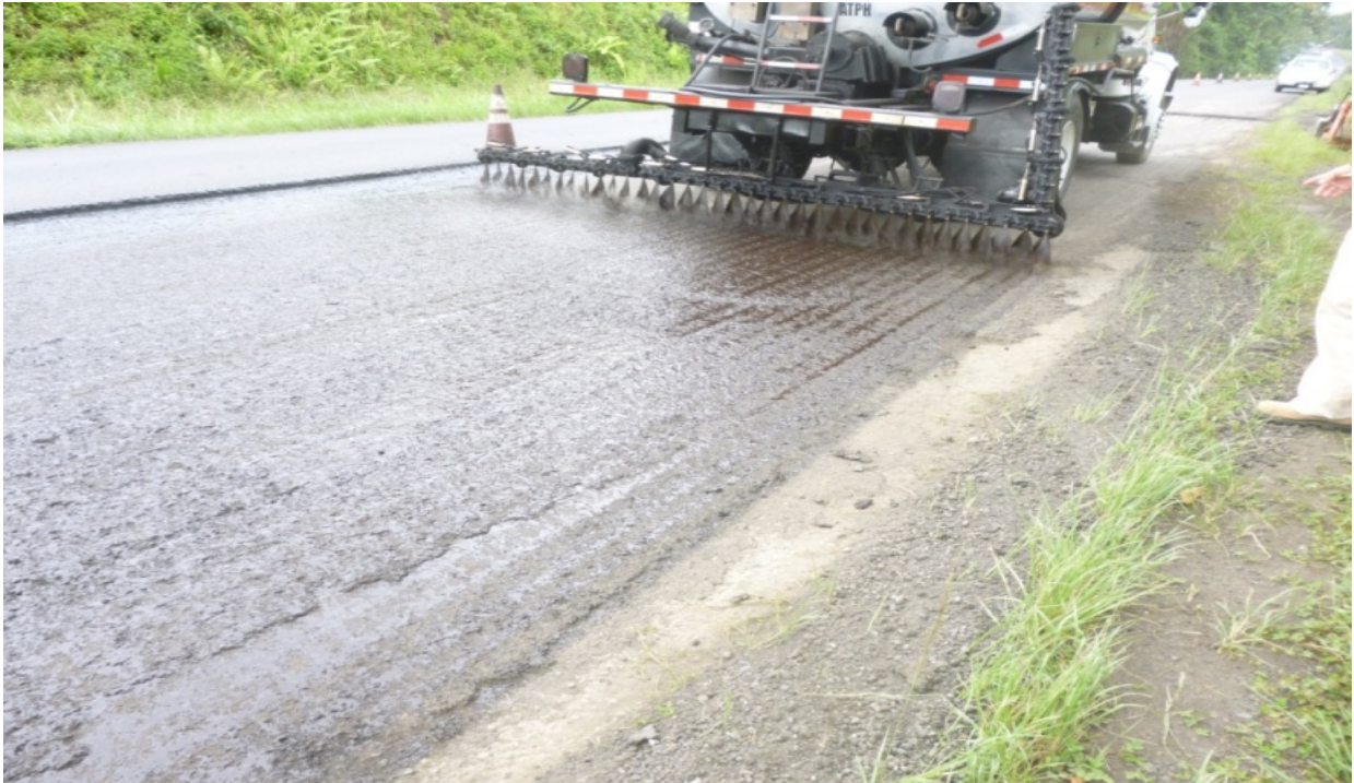
Fotografía 24. Aplicación de riego de liga adecuado sobre superficie perfilada.
