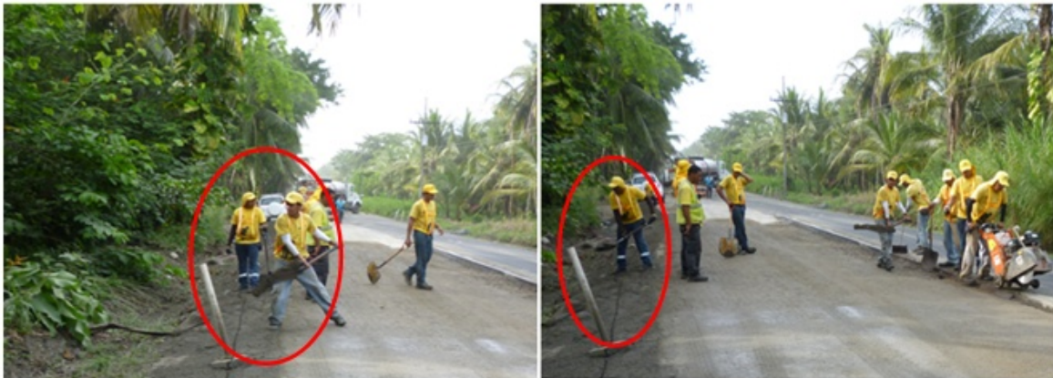
Fotografía 44. Operarios desechando material de sobrecapa existente a zonas verdes al costado de la vía. Ubicación: Ruta Nacional 36, Sección de Control 70040, Río Banano - Río Tuba. Aproximadamente en el kilómetro 4+580 desde el puente sobre la desembocadura al mar del Río Estero Negro. Fecha: 17 de marzo de 2015. Fuente: UAT-LanammeUCR
