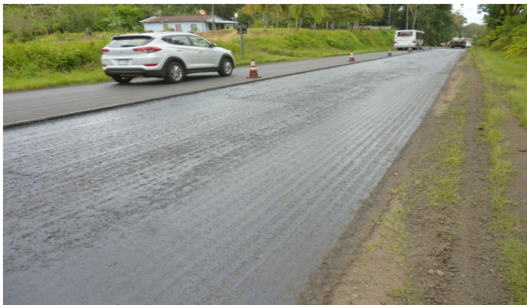
Fotografía 25. Cobertura total y uniforme del riego de liga sobre la superficie a intervenir.
