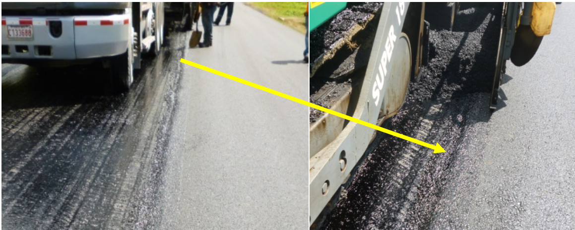
Fotografía 7. El borde interno de la capa colocada otro día no es cortado para construir la junta longitudinal.
