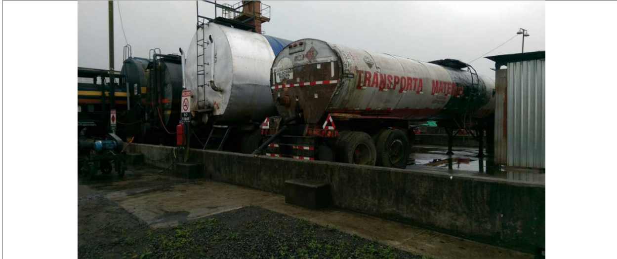
Fotografía 12. Barreras perimetrales de los tanques de materiales combustibles
