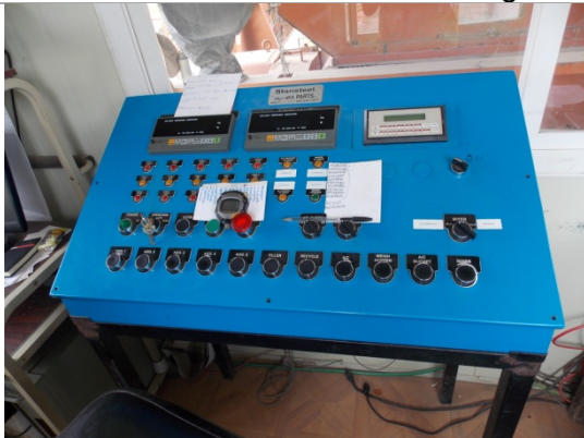
Fotografía 3. Cabina de Control
