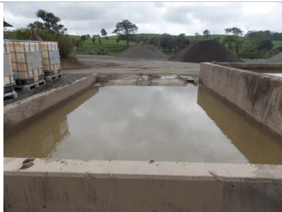
Fotografía 11. Laguna de sedimentación
