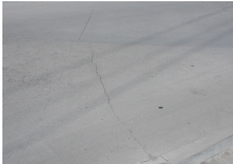
Fotografía 5 Agrietamiento en losas de concreto con geometría irregular. Ubicación: Sobre la Ruta 1, Sección Cañas Liberia Estacionamiento 216+500 Sentido Liberia La Cruz, Fecha 6 de noviembre de 2015. Fuente: LanammeUCR.
