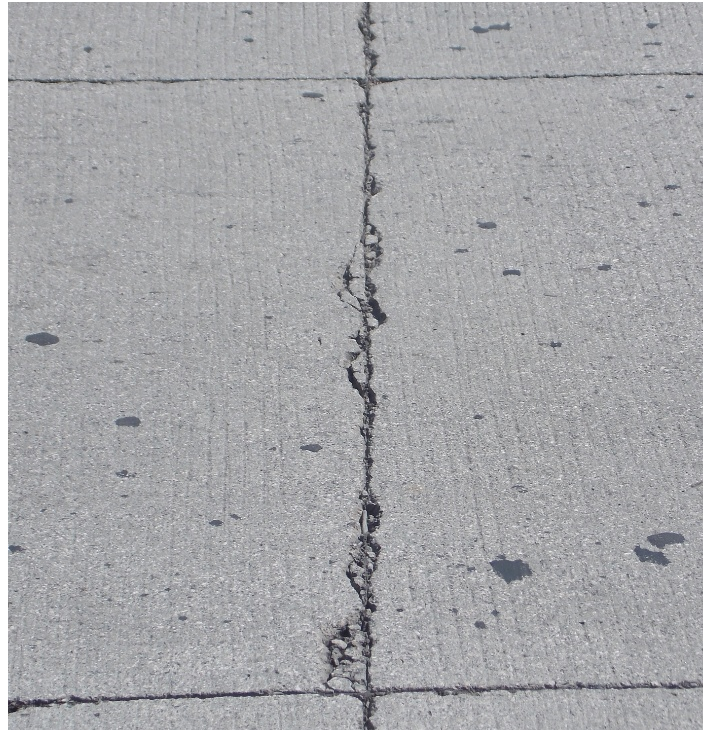
Fotografía 8 Daño de los bordes en losas de concreto. Ubicación: ramales del paso a desnivel del Barrio La Cruz Sobre la Ruta 1, Sección Cañas Liberia Estacionamiento 213+730 Sentido Liberia Cañas, Fecha 6 de noviembre de 2015. Fuente: LanammeUCR.
