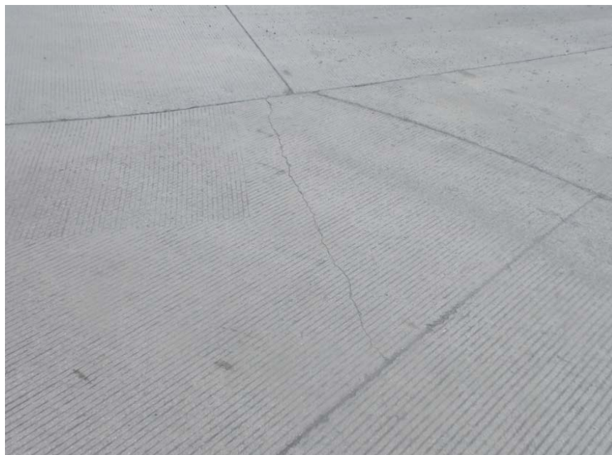
Fotografía 7 Agrietamiento en losas de concreto con geometría irregular. Ubicación: Sobre la Ruta 1, Sección Cañas Liberia Estacionamiento 216+500 Sentido Liberia La Cruz, Fecha 20 de julio de 2016. Fuente: LanammeUCR.
