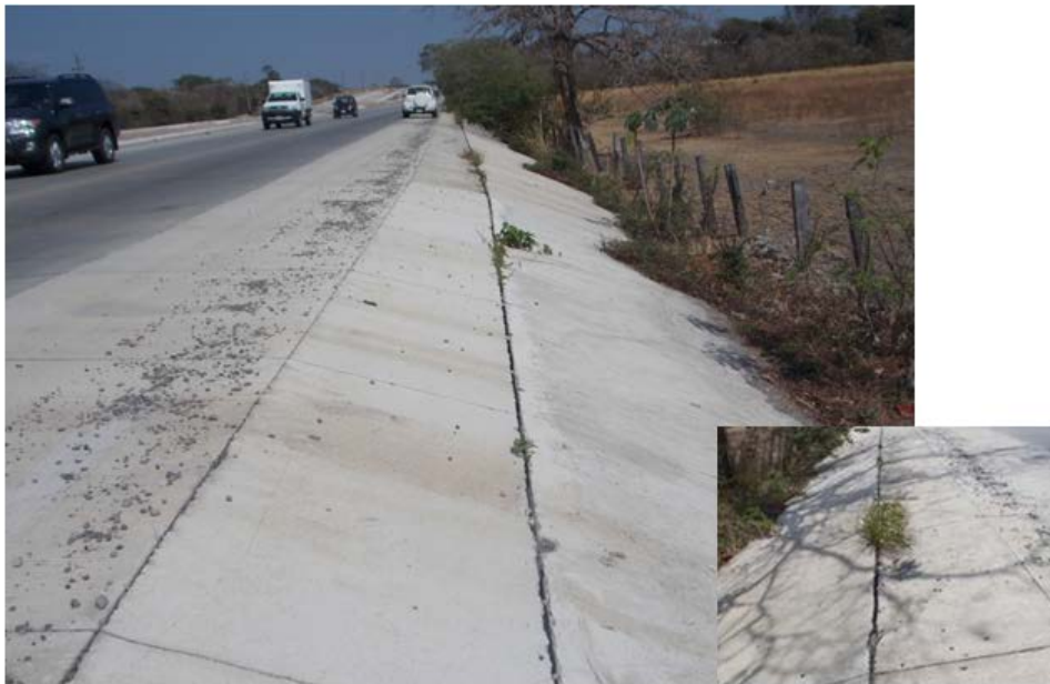
Fotografía 2. Abertura en junta entre espaldón y revestimiento de talud con presencia de vegetación. Ubicación: Sobre la Ruta 1, Sección Cañas Liberia. Estacionamiento 195+071 Sentido Cañas Liberia, oficio LM-AT-076-15. Fecha 5 de mayo de 2015. Fuente: LanammeUCR.
