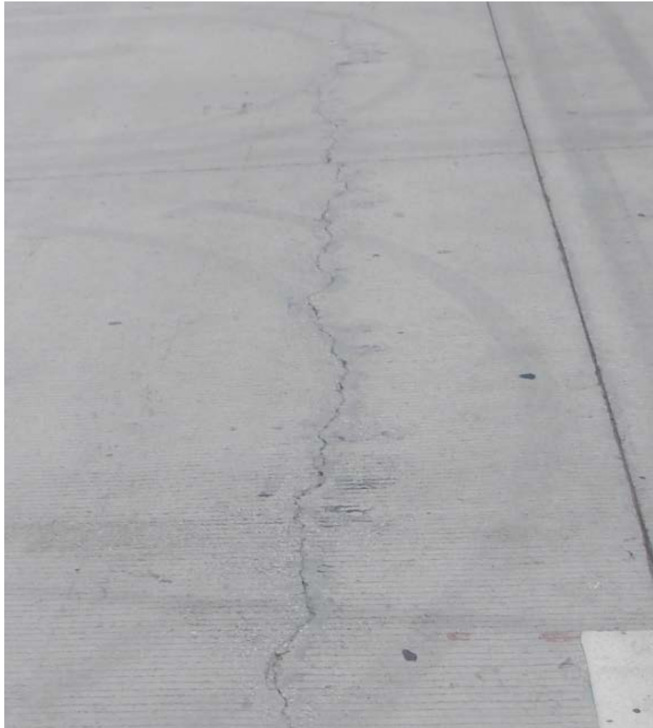
Fotografía 11 Daño en sello de grietas en losas de concreto. Ubicación: Sobre la Ruta 1, Sección Cañas Liberia Estacionamiento 213+730 Sentido Liberia Cañas, Fecha 13 de abril de 2016. Fuente: LanammeUCR.
