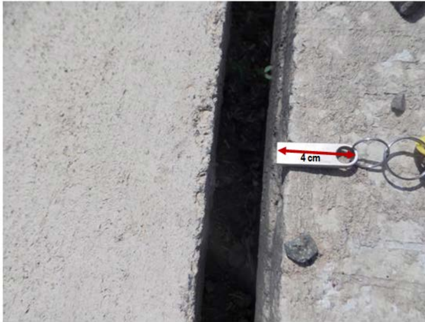
Fotografía 3. Abertura en junta entre espaldón y revestimiento de talud. Ubicación: Sobre la Ruta 1, Sección Cañas Liberia. Estacionamiento 194+935 Sentido Cañas Liberia, oficio LM-AT-076-15. Fecha 5 de mayo de 2015. Fuente: LanammeUCR.
