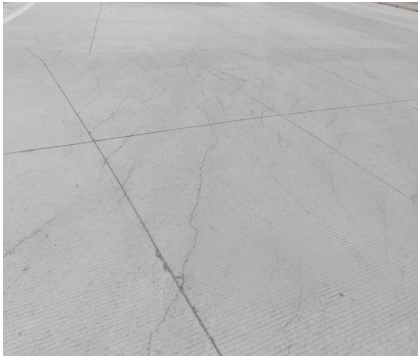
Fotografía 6 Agrietamiento en losas de concreto con geometría irregular. Ubicación: Sobre la Ruta 1, Sección Cañas Liberia Estacionamiento 202+100 Sentido Liberia Cañas, Fecha 20 de julio de 2016. Fuente: LanammeUCR.
