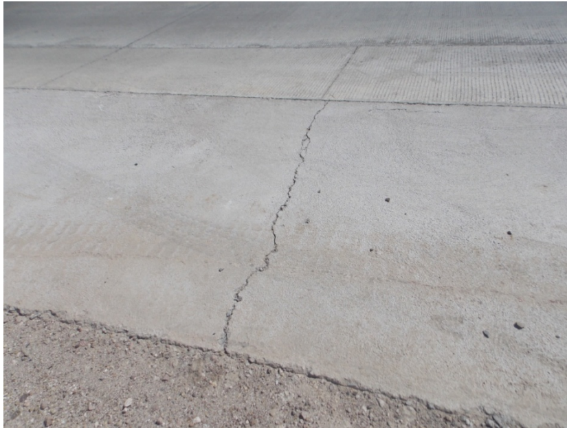
Fotografía 1. Grietas transversales en los taludes revestidos. Ubicación: Sobre la Ruta 1, Sección Cañas Liberia. Estacionamiento 194+935 Sentido Cañas Liberia, oficio LM-AT-076-15. Fecha 5 de mayo de 2015. Fuente: LanammeUCR.
