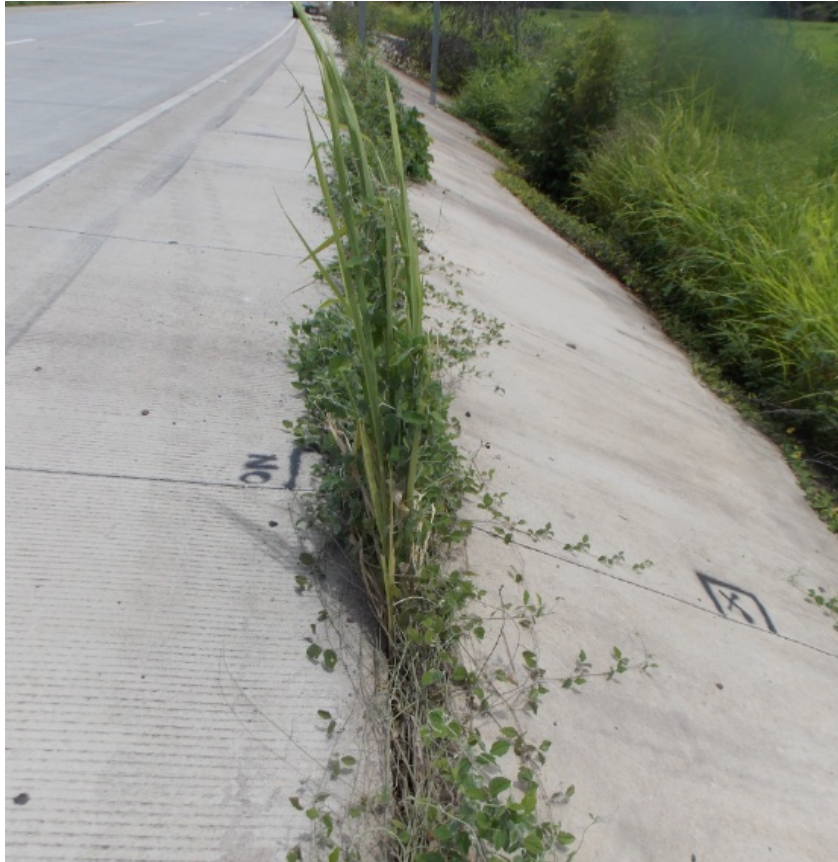
Fotografía 4. Abertura en junta entre espaldón y revestimiento de talud, la cual tiene agrietamiento en el talud revestido. Ubicación: Sobre la Ruta 1, Sección Cañas Liberia Estacionamiento 194+935 Sentido Cañas Liberia, Fecha 20 de julio de 2016. Fuente: LanammeUCR.
