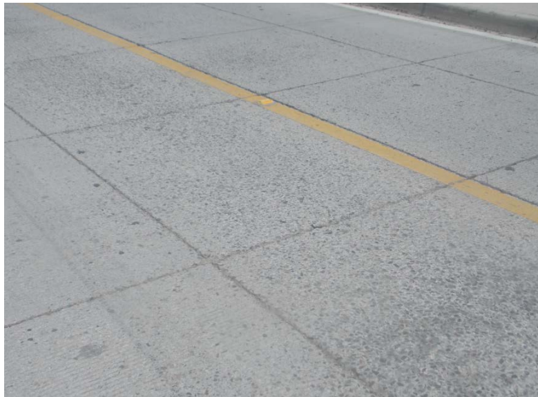
Fotografía 9 Daño de los bordes en losas de concreto. Ubicación: ramales del paso a desnivel del Barrio La Cruz Sobre la Ruta 1, Sección Cañas Liberia Estacionamiento 213+730 Sentido Liberia Cañas, Fecha 20 julio de 2016. Fuente: LanammeUCR
