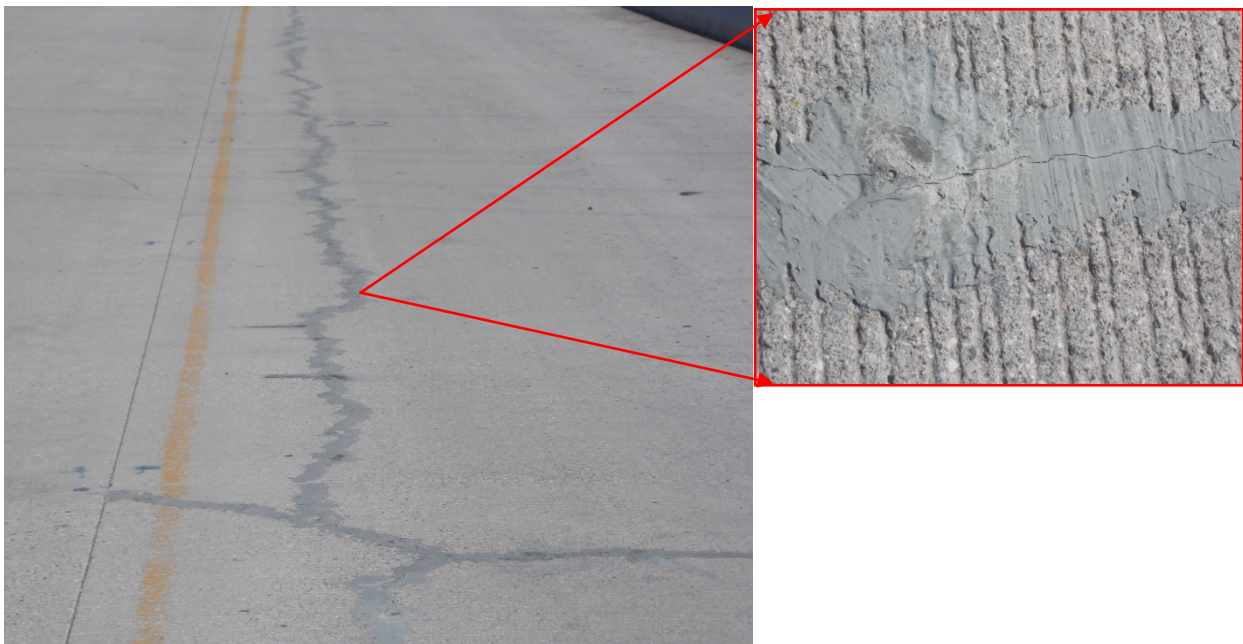
Fotografía 10 Daño en sello de grietas en losas de concreto. Ubicación: Sobre la Ruta 1, Sección Cañas Liberia Estacionamiento 213+730 Sentido Liberia Cañas, Fecha 6 de noviembre de 2015. Fuente: LanammeUCR.
