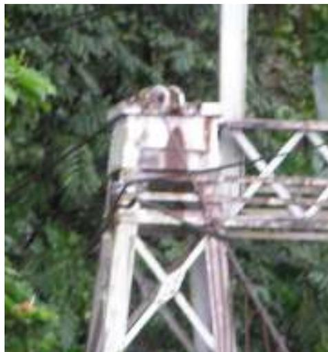
**Fotografías 4 y 5:** Vista de la torre donde ocurrió la falla de los cables y detalle del elemento metálico de la torre en que se apoyaba el cable (montura). Fecha 22 de octubre 2009
