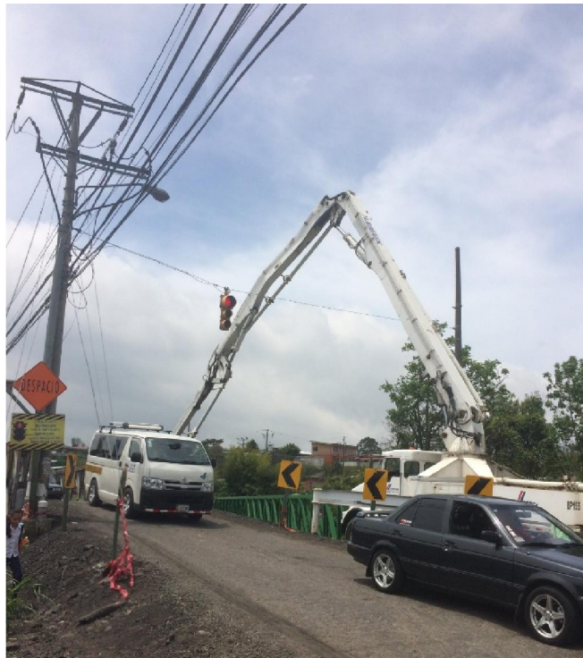
Fotografía 3. Bomba telescópica cerca de cables eléctricos. Ubicación: Sobre la Ruta 220, Fecha 17 de mayo de 2016. Fuente: LanammeUCR.
