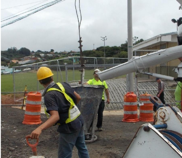
Fotografía 4. Colocación con balde de grúa. Fecha: 7 de setiembre 2016 Fuente LanammeUCR
