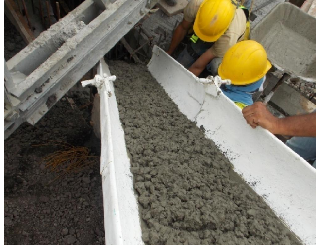
Fotografía 5. Colocación con canoas mediante descarga directa. Fecha: 7 de setiembre 2016 Fuente: LanammeUCR
