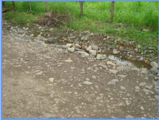
Fotografías N°14. Estación 0+200 y 0+400, superficie de ruedo con bombeo inadecuado, sin definición de cunetas y material con sobre-tamaño granulométrico. (Fecha de fotografías 08-Junio-2010)
