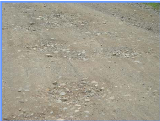
Fotografía N°15: Estación 1+000, Superficie de ruedo con bombeo inadecuado, sin buena definición de cunetas y con material con sobre-tamaño granulométrico. (Fecha de fotografía 08-Junio-2010)
