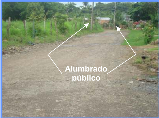
(A) Estacionamiento 0+400. Servicio público de electricidad.
