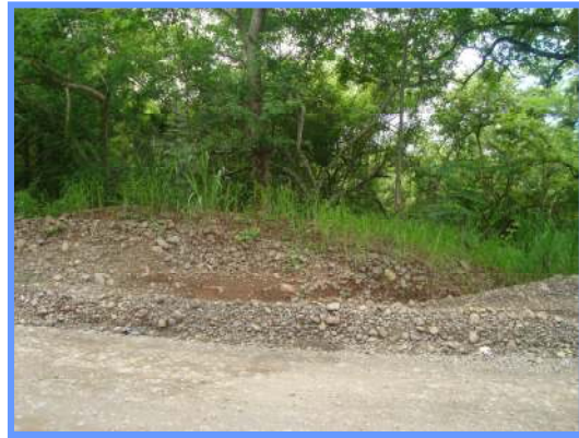
Fotografías N°8: Tramo entre estación 16+200 y 16+300, material de lastre con sobretamaño, depositado en el margen de la calzada obstruyendo las cunetas. (Fecha de fotografías 08-Junio-2010)
