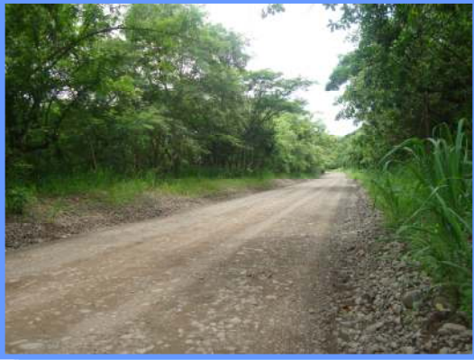
Fotografías N°7: Tramo entre estación 15+900 y 16+100, material de lastre con sobretamaño, depositado en el margen de la calzada obstruyendo las cunetas. (Fecha de fotografías 08-Junio-2010)
