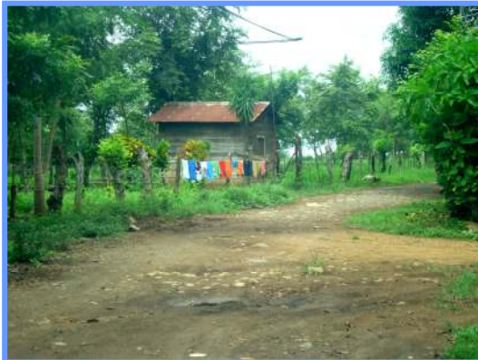
(B) Estacionamiento 0+150 Superficie en tierra con algo de lastre
