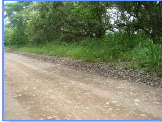
Fotografías N°7: Tramo entre estación 15+900 y 16+100, material de lastre con sobretamaño, depositado en el margen de la calzada obstruyendo las cunetas. (Fecha de fotografías 08-Junio-2010)
