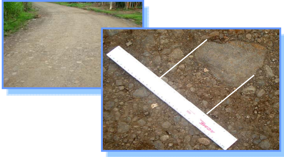
Fotografías N° 3: Estación 0+600, Acceso por Villa Bruselas. Material con sobre-tamaño granulométrico, diámetro de 4.75". (Fecha de fotografías 08-Junio-2010)
