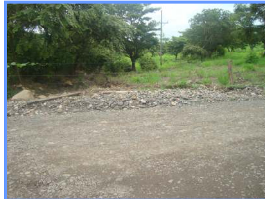
Fotografías N°5: Estación 0+400, Acceso por Villa Bruselas. Material con sobre-tamaño depositado en las cunetas. (Fecha de fotografías 08-Junio-2010)
