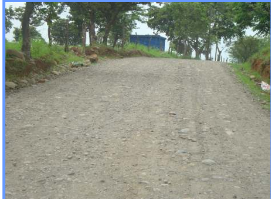
Fotografías N°14. Estación 0+200 y 0+400, superficie de ruedo con bombeo inadecuado, sin definición de cunetas y material con sobre-tamaño granulométrico. (Fecha de fotografías 08-Junio-2010)
