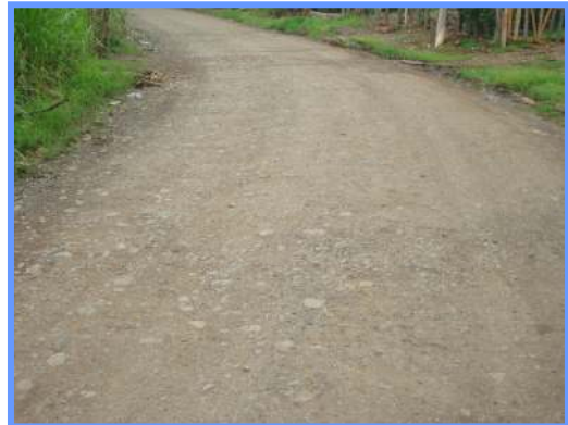
(B) Estacionamiento 0+600. Acabado de superficie existente.
