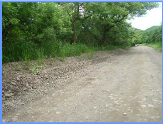
Fotografías N°8: Tramo entre estación 16+200 y 16+300, material de lastre con sobretamaño, depositado en el margen de la calzada obstruyendo las cunetas. (Fecha de fotografías 08-Junio-2010)
