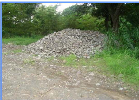
Fotografías N°5: Estación 0+400, Acceso por Villa Bruselas. Material con sobre-tamaño depositado en las cunetas. (Fecha de fotografías 08-Junio-2010)
