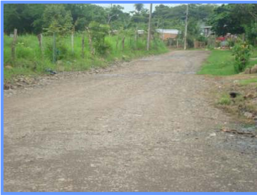
Fotografías N°5: Estación 0+400, Acceso por Villa Bruselas. Material con sobre-tamaño depositado en las cunetas. (Fecha de fotografías 08-Junio-2010)
