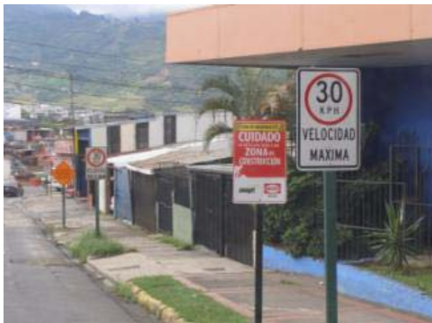
Fotografía 9. Señalización acceso Norte. 18/11/09
