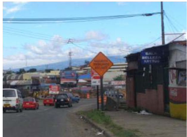
Fotografía 10. Señalización acceso Sur. 18/11/09
