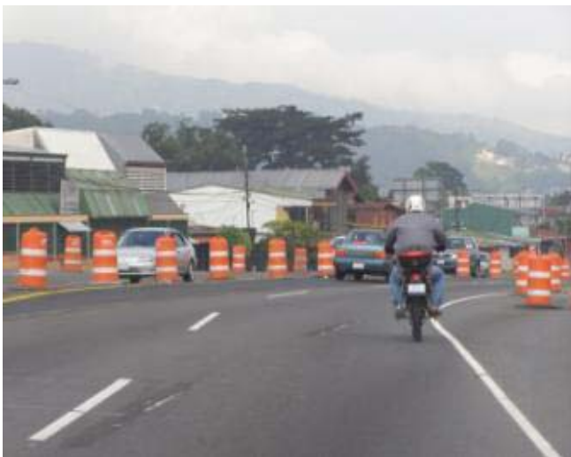
Fotografía 1 y 2. Canalización del flujo vehicular a través del área de trabajo. Estañones de señalización con separación uniforme. 16/10/09
