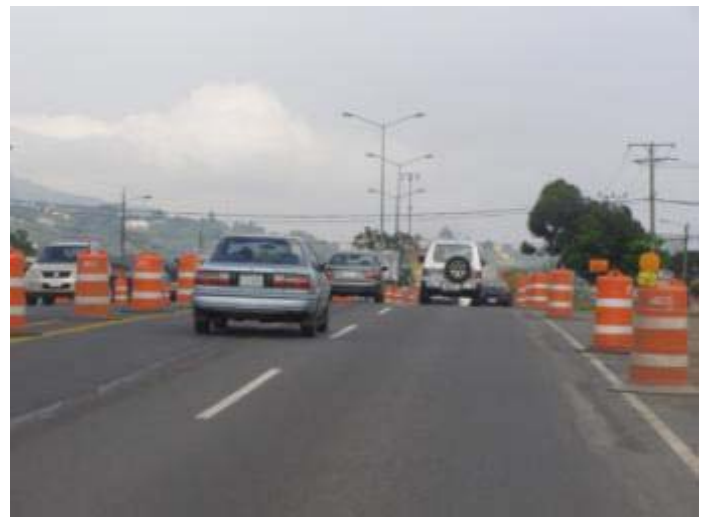
Fotografía 1 y 2. Canalización del flujo vehicular a través del área de trabajo. Estañones de señalización con separación uniforme. 16/10/09
