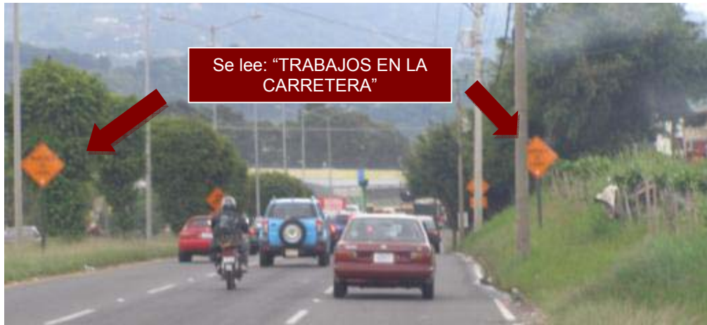
Fotografía 8. Demarcación vertical de inicio del trabajo. Acceso Oeste. Sentido Oeste-Este. 18/11/09
