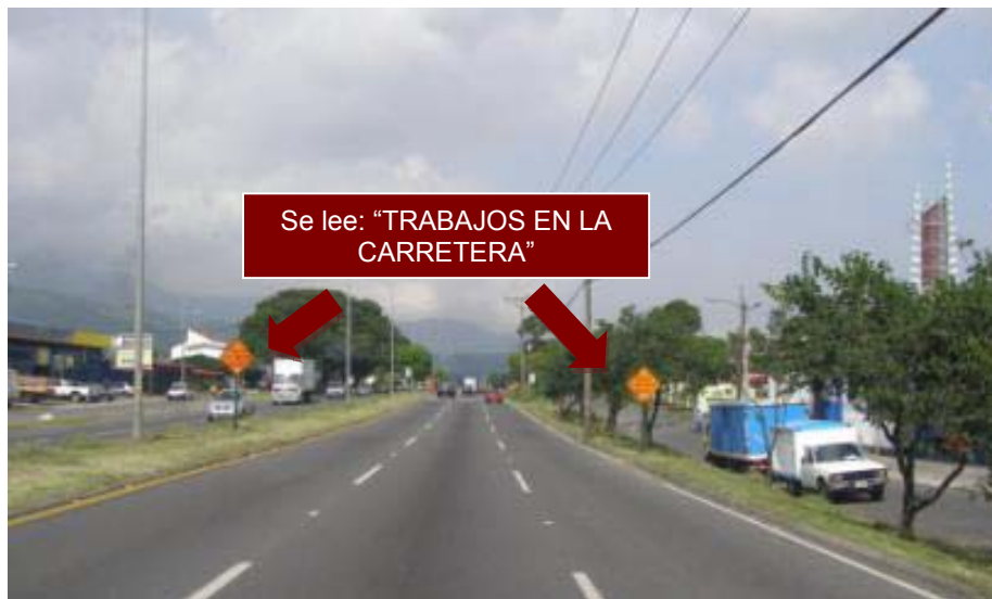
Fotografía 7. Demarcación vertical de inicio del trabajo. Acceso Este. Sentido Este-Oeste. 16/10/09
