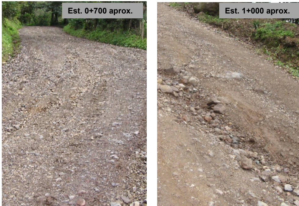
Fotografías No.1 y 2: Cárcavas en la superficie de ruedo. 05/11/09
