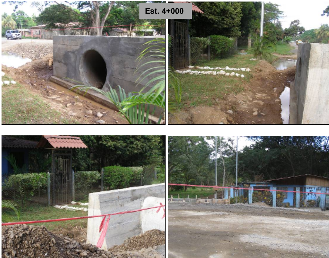
Fotografías No.24, 25, 26 y 27: Ubicación de tubería frente a casa de habitación y al local del Comité Acueducto de Artola. Est. Aprox. 4+000. 1 RUTA 911. 2/11/09
