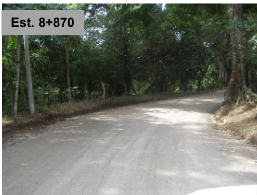
Fotografía No.23: Tramo de la sección de control 50443 en condiciones transitables. RUTA 911. 13/11/09
