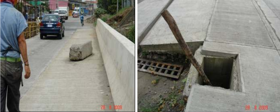
Fotografías No 15 y No 16. Obstáculos peligrosos en la vía.
