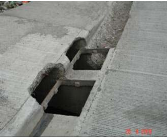
Fotografías No 13 y No 14. Obras de drenaje descubiertas sin protección ni señalización
