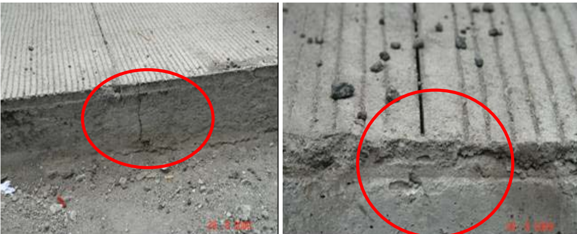
Fotografía No 9: Formación de grieta a la par del corte insuficiente realizado (28 de agosto del 2009)
