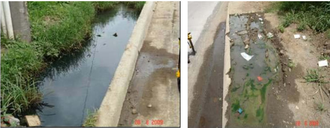
Fotografías No 11 y No 12. Estancamiento de agua (28 de agosto del 2009)
