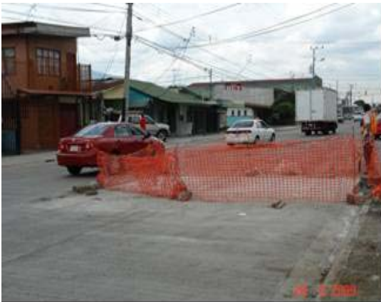
Fotografía No1. Sustitución de 2 losas de concreto (28 de agosto del 2009)
