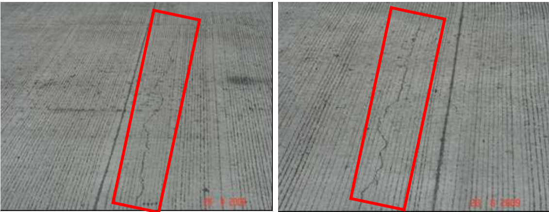
Fotografía No 7y No 8. Agrietamiento transversal de la losa (28 de agosto del 2009)
