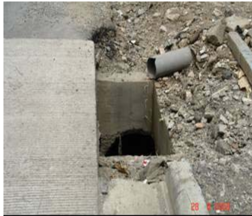
Fotografías No 13 y No 14. Obras de drenaje descubiertas sin protección ni señalización
