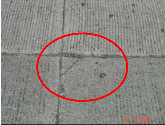
Fotografía No 5. Agrietamiento en la esquina de la losa (28 de agosto del 2009)
