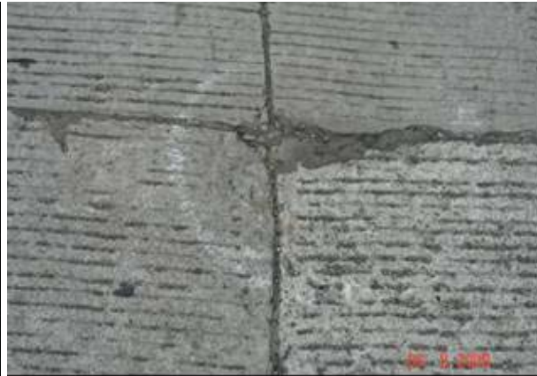
Fotografía No 4. Irregularidad de la junta (28 de agosto del 2009)
