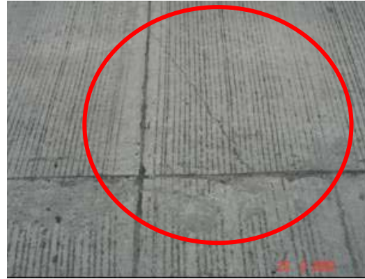
Fotografía No 6. Problemas en la unión de la junta (28 de agosto del 2009)
