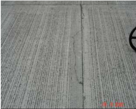
Fotografía No 3. Losa con deterioro y sin sello en la junta (28 de agosto del 2009)
