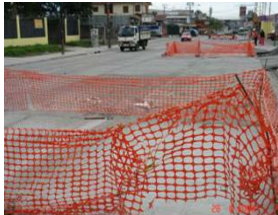
Fotografía No 2. Sustitución de losas de concreto (28 de agosto del 2009)
