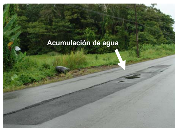
Fotografía No. 1 y 2: Áreas de bacheo inconclusas rellenas con mezcla asfáltica. Fecha 20 de enero de 2009, Ruta No. 36, sección de control 70050 y 70020.
