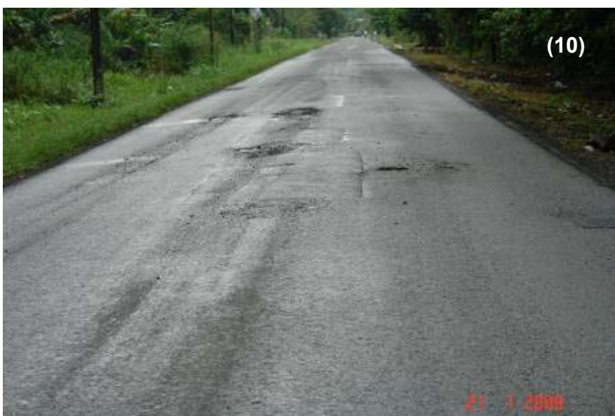
Fotografía No. 9 y 10: Zona con concentración de baches y agrietamientos "cuero de lagarto". Fecha de la visita 21 de enero del 2009. Ruta Nacional No. 36. Sección de control 70030.
