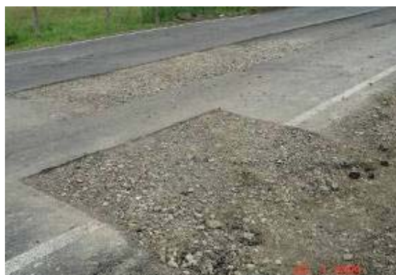
Fotografía No 3 y 4: Áreas de bacheo inconclusas rellenas con mezcla asfáltica y material granular. Fecha de la visita 20 de enero de 2009, Ruta 36, sección de control 70050.
