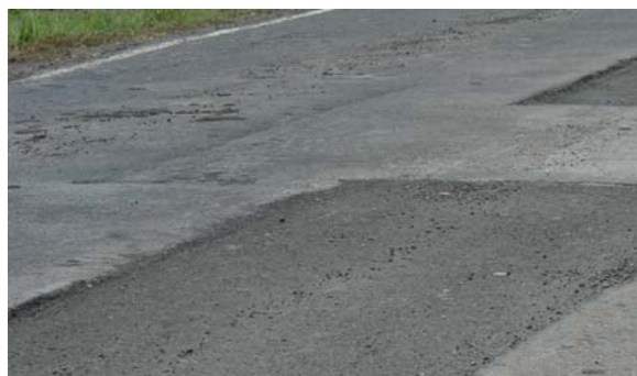
Fotografías No. 5 y 6: Falta de nivelación de la superficie del bache. Fecha de la visita 20 de enero del 2009, Ruta 36, sección de control 70050.
