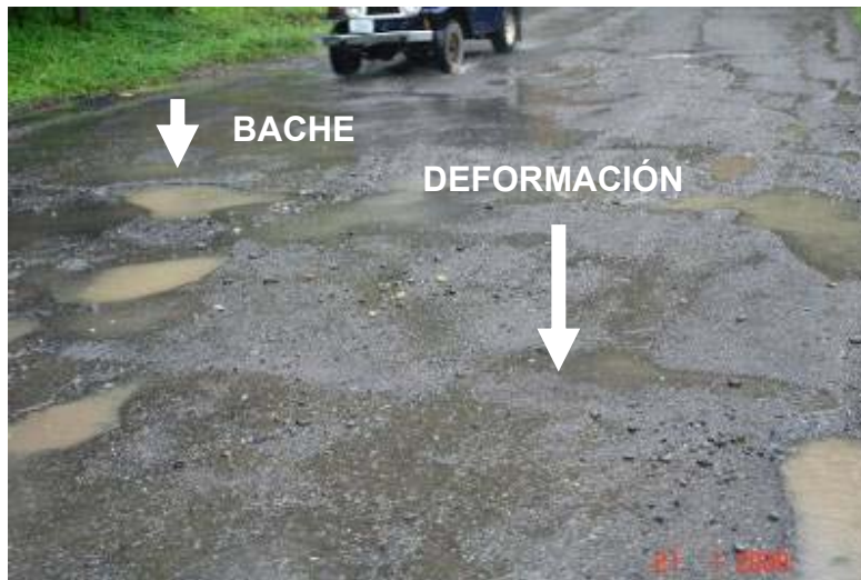
Fotografía No. 7: Concentración de baches de pequeñas dimensiones. Fecha de la visita 21 de enero del 2009. Ruta Nacional No. 36. Sección de control 70010
