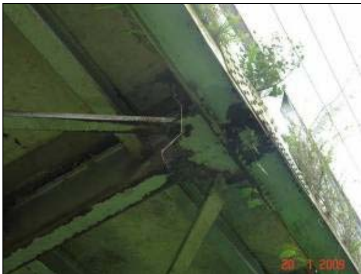
Fotografía No.17: Los elementos estructurales metálicos tienen acumulación de sedimentos y vegetación Ruta Nacional No. 36 Ruta Nacional No. 36, puente sobre el río Estrella. Fecha 20 de enero del 2009.
