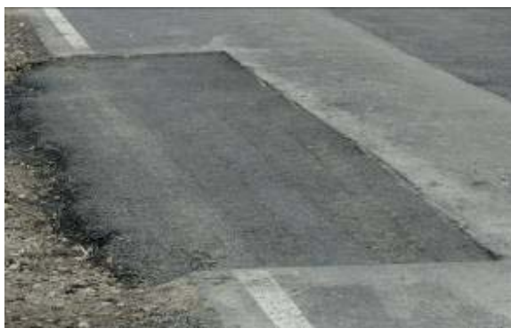
Fotografías No. 5 y 6: Falta de nivelación de la superficie del bache. Fecha de la visita 20 de enero del 2009, Ruta 36, sección de control 70050.
