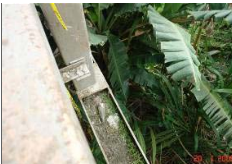
Fotografía No. 16: Los elementos estructurales metálicos muestran corrosión. Ruta Nacional No. 36 Ruta Nacional No. 36, puente sobre el río Estrella. Fecha 20 de enero del 2009
