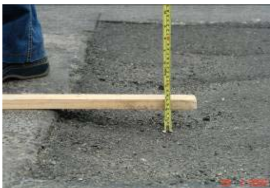
Fotografía No 3 y 4: Áreas de bacheo inconclusas rellenas con mezcla asfáltica y material granular. Fecha de la visita 20 de enero de 2009, Ruta 36, sección de control 70050.
