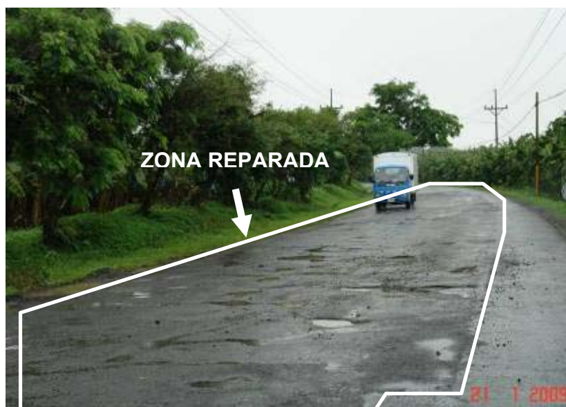
Fotografía No. 8: Zona con concentración de baches. Fecha de la visita 21 de enero del 2009. Ruta Nacional No. 36. Sección de control 70030.
