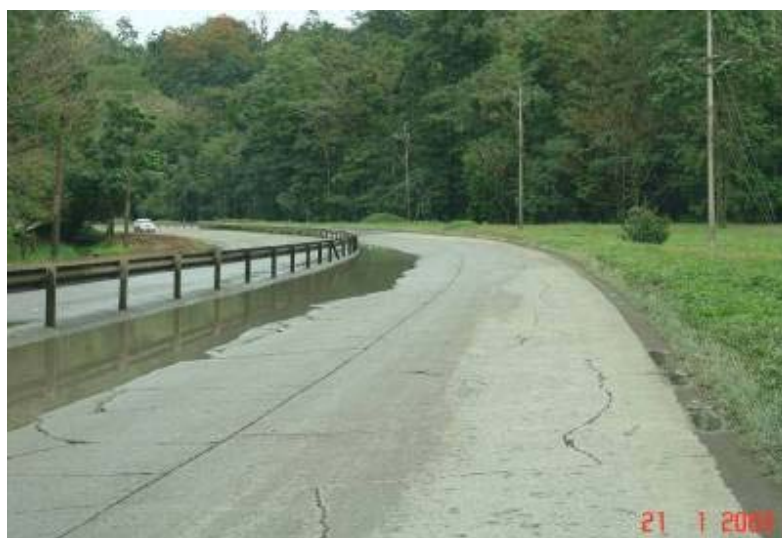
Fotografía No. 14: Acumulación de agua y falta de sellado en juntas y grietas. Ruta Nacional No. 240. Fecha de la fotografía 21 de enero del 2008.
