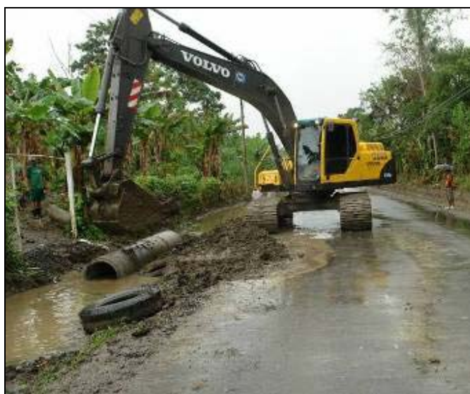
Fotografía No. 11: Ejecución de trabajos de paso peatonal, nótese la ausencia de conos en el área de trabajo. Fecha de la visita 21 de enero del 2009. Ruta Nacional No. 805, sección 70520.
