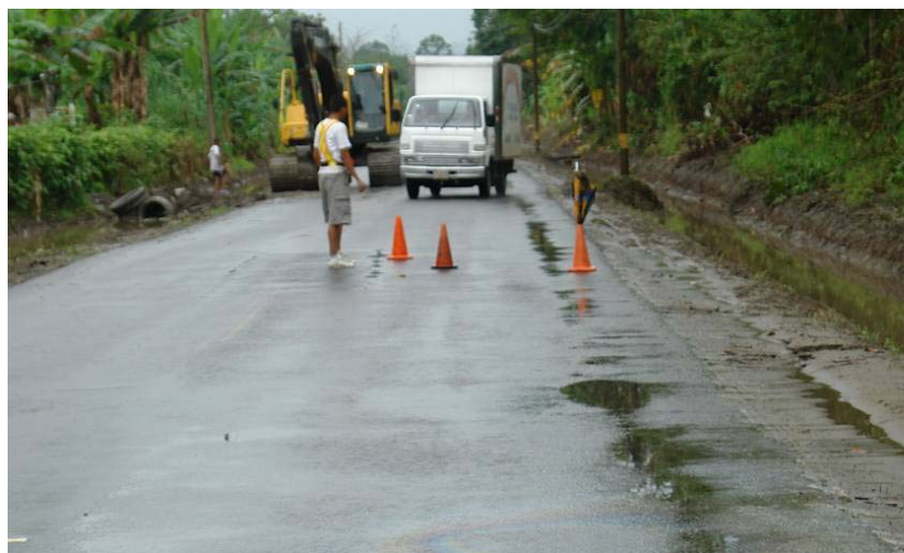
Fotografía No. 13: Ausencia del área de transición. Fecha 20 de enero de 2009. Ruta No. 805, sección de control 70520.
