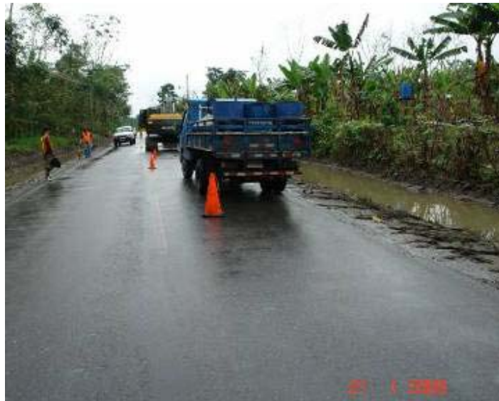
Fotografía No. 12: Delimitación del área de trabajo. Fecha 20 de enero del 2009. Ruta No. 805, sección de control 70520.
