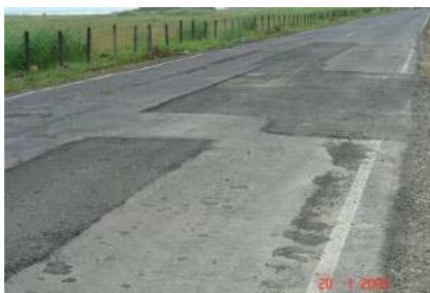
Fotografía No. 1 y 2: Áreas de bacheo inconclusas rellenas con mezcla asfáltica. Fecha 20 de enero de 2009, Ruta No. 36, sección de control 70050 y 70020.
