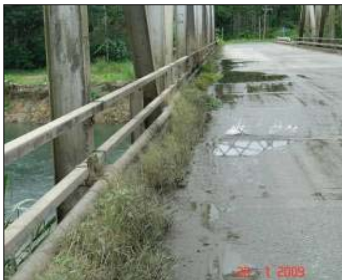
Fotografía No. 15: Acumulación de agua debido a problemas de drenaje causados por la acumulación de sedimentos y materia vegetal. Ruta Nacional No. 36, puente sobre el río Estrella. Fecha 20 de enero del 2009
