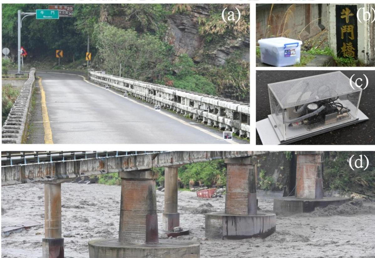
**Figura 23.** Monitoreo continuo del puente Niou Tou, Taiwán, durante un tifón Fanapi en el año 2010 con el sistema NTU-WSU.
