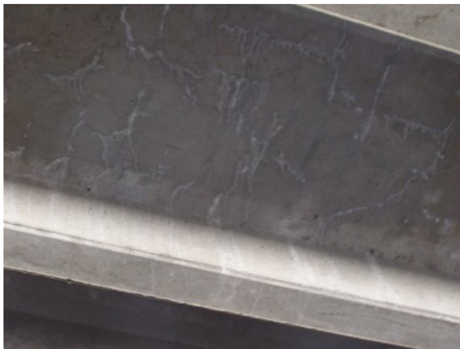
Figura 7. Detalle de las fisuras y eflorescencias observadas en la losa de la canaleta #10
