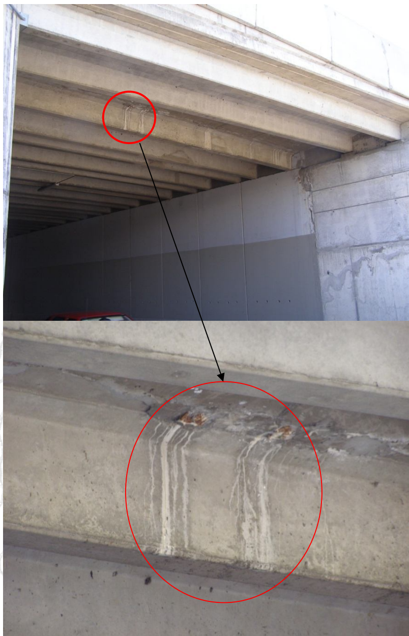
Figura 9. Detalle de las eflorescencias y oxidación encontradas en la unión entre la sección existente y la sección ampliada y en la canaleta #2
