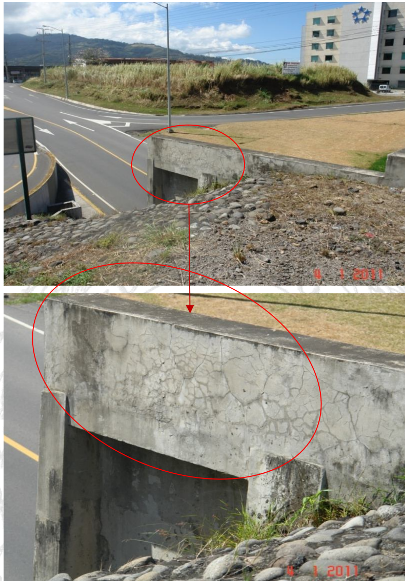
Figura 10. Agrietamiento observado en el aletón Sur del bastión Oeste
