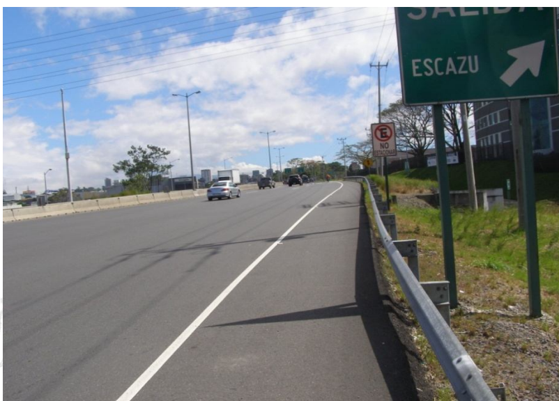
Figura 2. Vista del Paso superior Trejos Montealegre
