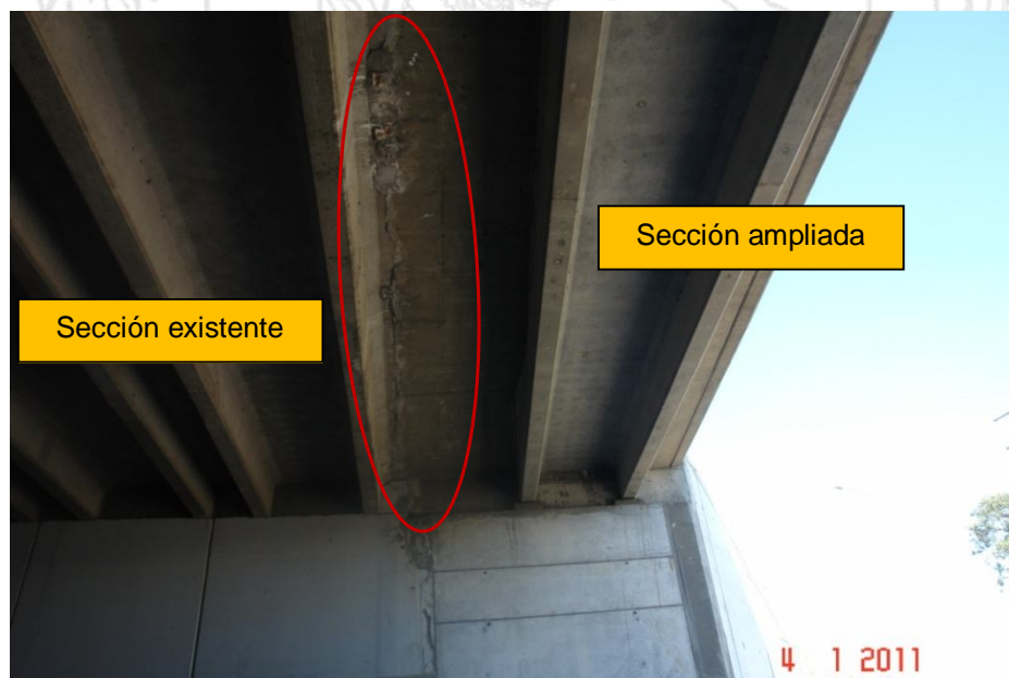
Figura 8. Eflorescencias observadas en la unión entre la sección existente y la sección ampliada
