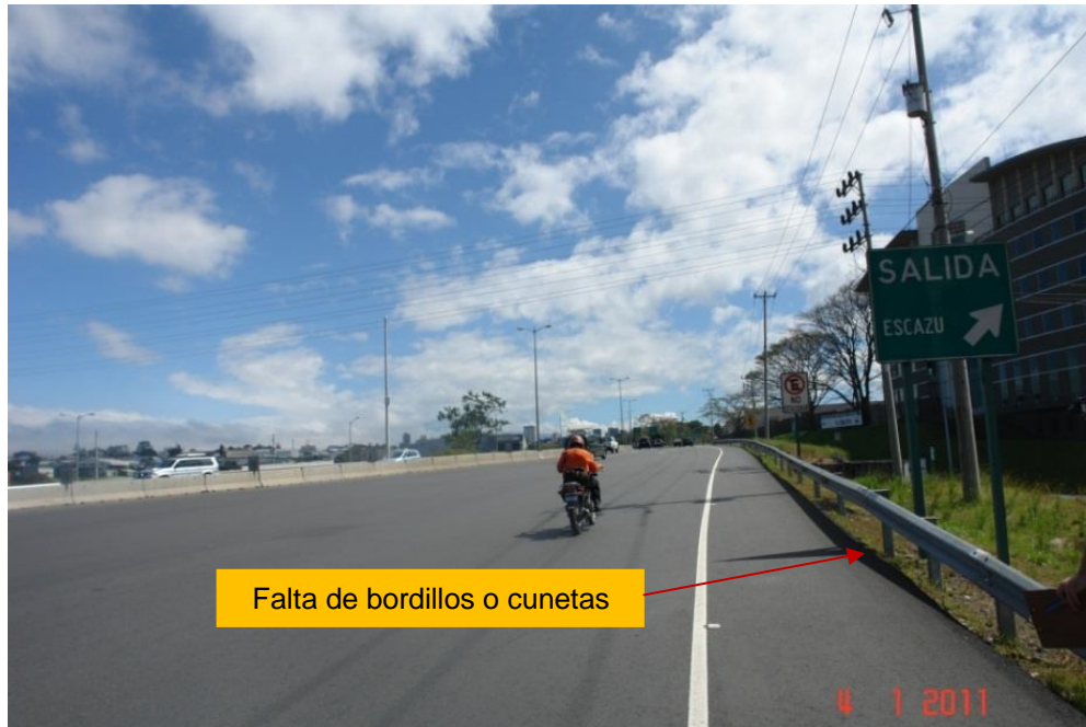
Figura 5. Ausencia de un sistema de drenaje en la superestructura
