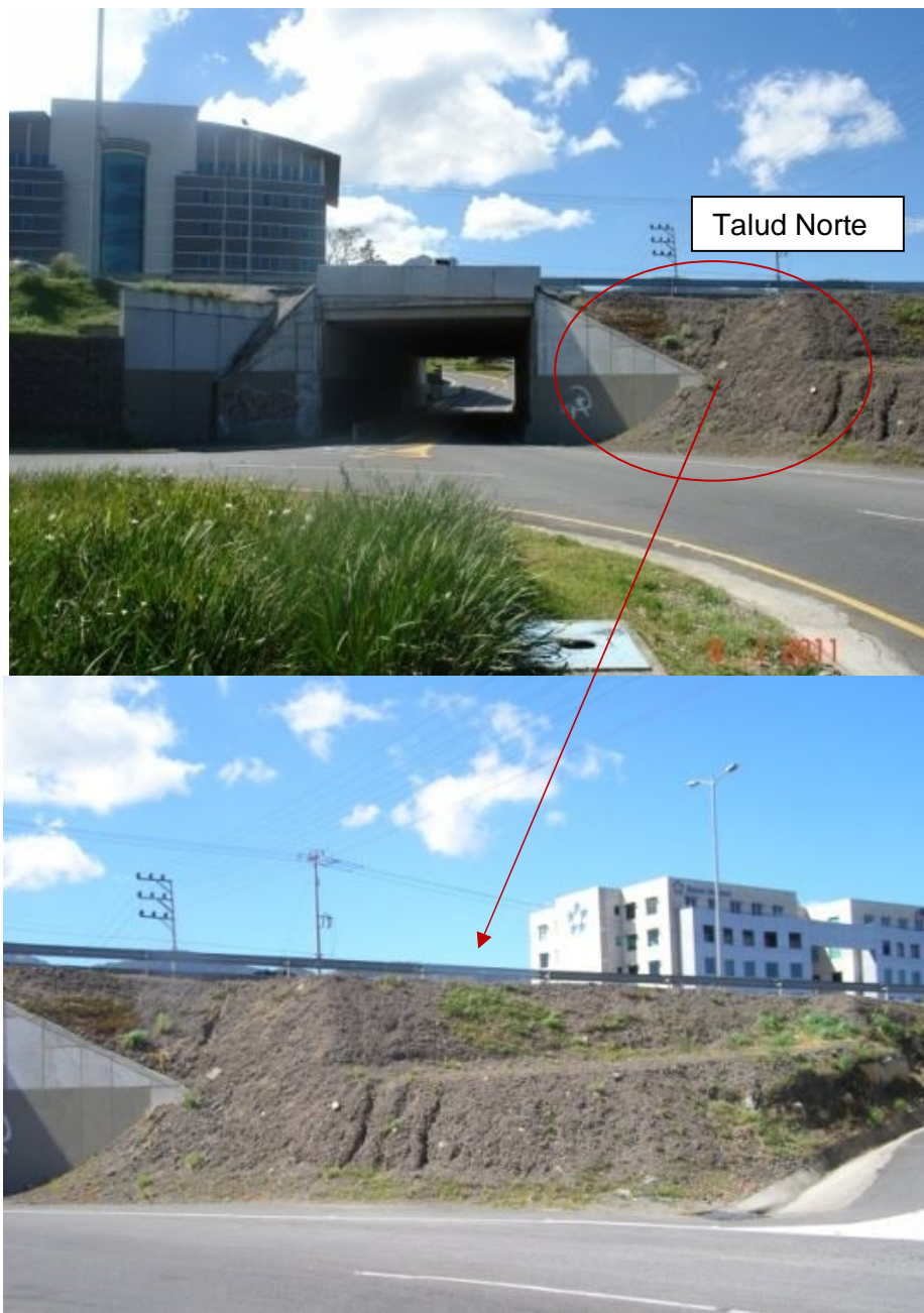
Figura 4. El talud Norte del bastión Oeste carece de protección contra la erosión
