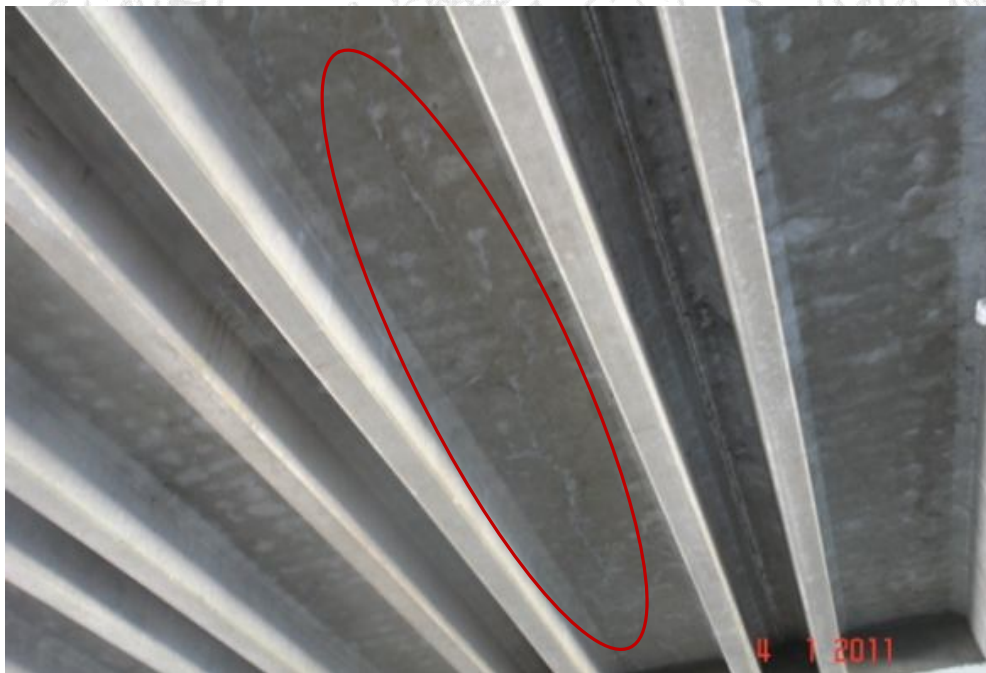
Figura 6. Agrietamiento longitudinal y eflorescencias observadas en la canaleta #10.
