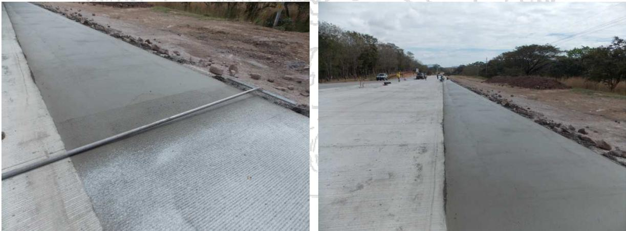
**Figura 4.** Construcción de losas de concreto en el proyecto Cañas-Liberia
