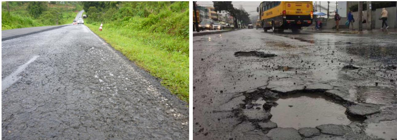
Figura 2. Tipos de deterioro asociados al daño por humedad en la mezcla asfáltica
