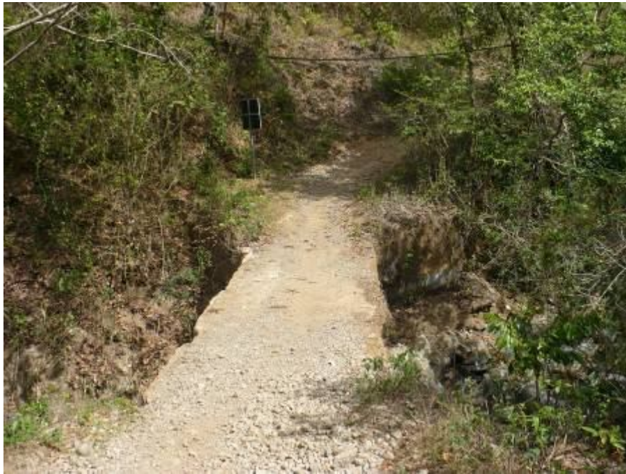
Figura 2. Vista a los largo de la línea centro del puente Quebrada Honda- Quebrada Honda.
