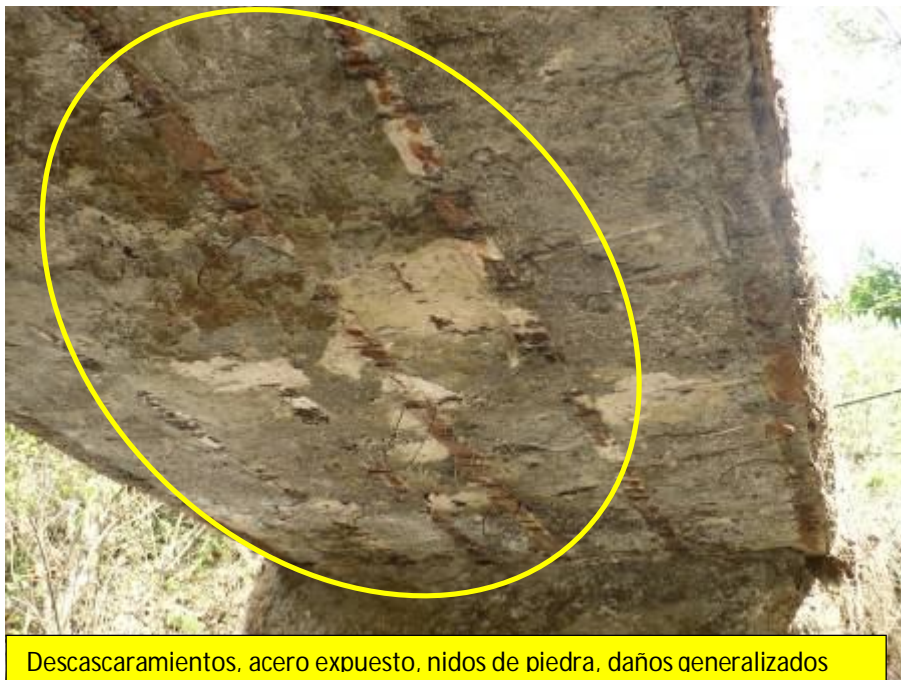
Figura 3. Vista inferior del puente Quebrada Honda
