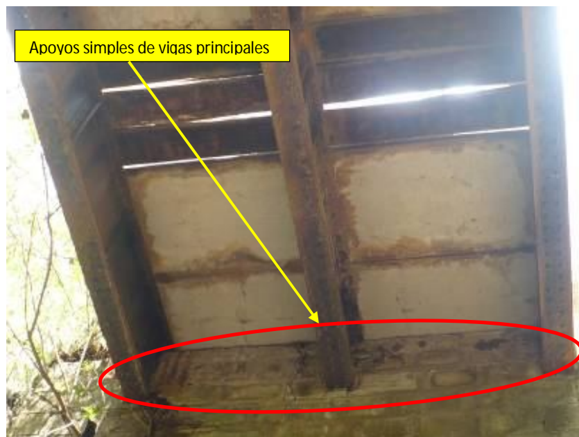
Figura 4. Apoyo simple de vigas principales,
