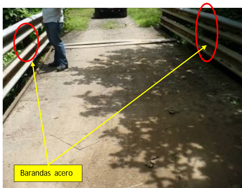
Figura 5. Barandas de acero, flojas y con corrosión.
