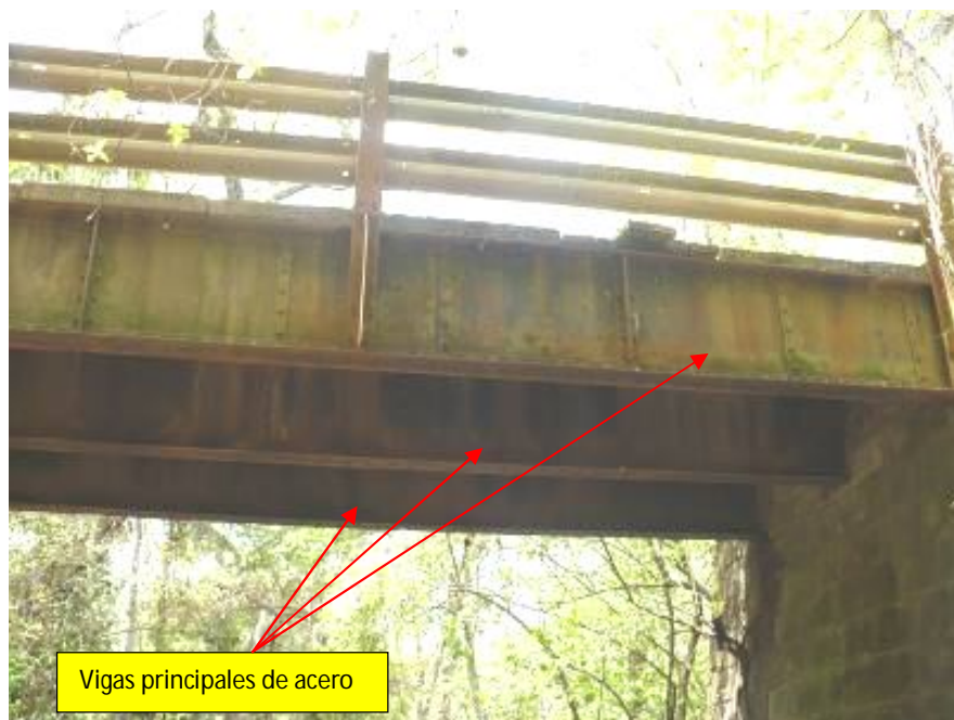
Figura 3. Vista inferior del puente Concepción
