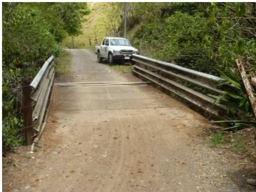
Figura 2. Vista a lo largo de la línea centro del puente Concepción-Quebrada Concepción.
