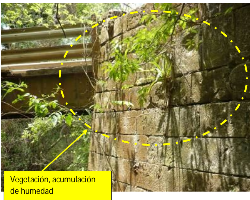
Figura 12. Aletones de mampostería en buen estado.
