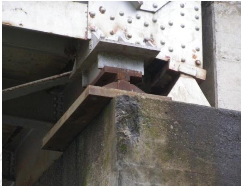
Figura 16. Vista del apoyo original y el apoyo temporal sobre el bastión Sureste.
