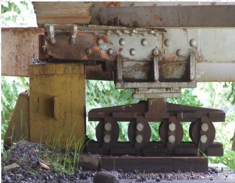
Figura 17. Vista de los apoyos provisionales sobre el bastión Noroeste.
