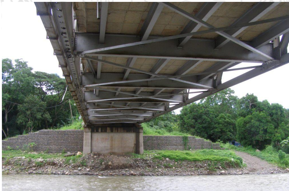
Figura 3. Vista inferior del puente (en dirección hacia Barranca).
