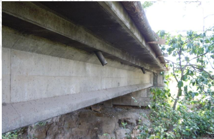
Figura 3: Vista lateral de uno de los puentes
