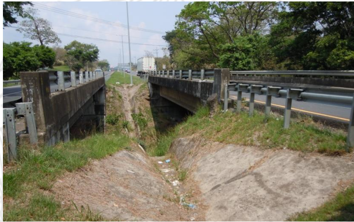
Figura 2: Vista a lo largo de la línea de centro de los puentes
