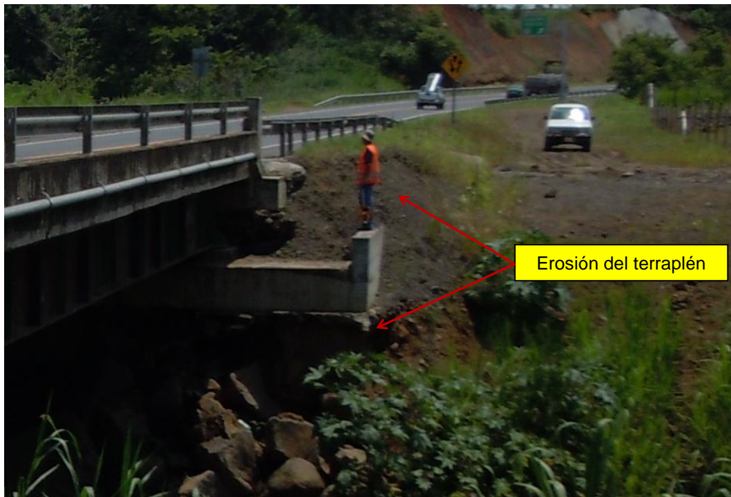
Figura 8. Erosión del terrapién Este del acceso Noroeste.
