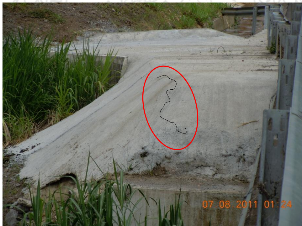
Figura 7. Agrietamiento en la protección de concreto del terraplén Este del acceso Sureste.
