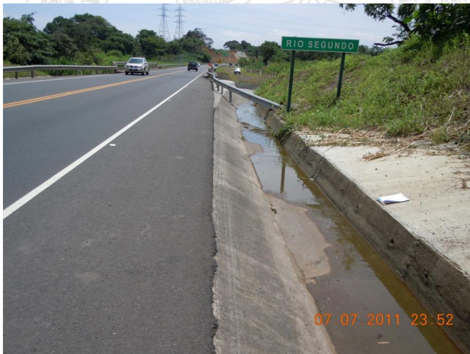
Figura 5. La señalización del puente consiste sólo en el rótulo con el nombre.
