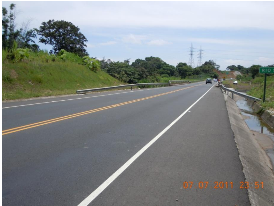
Figura 4. Sistema de contención vehicular tipo flex-beam en los accesos al puente.
