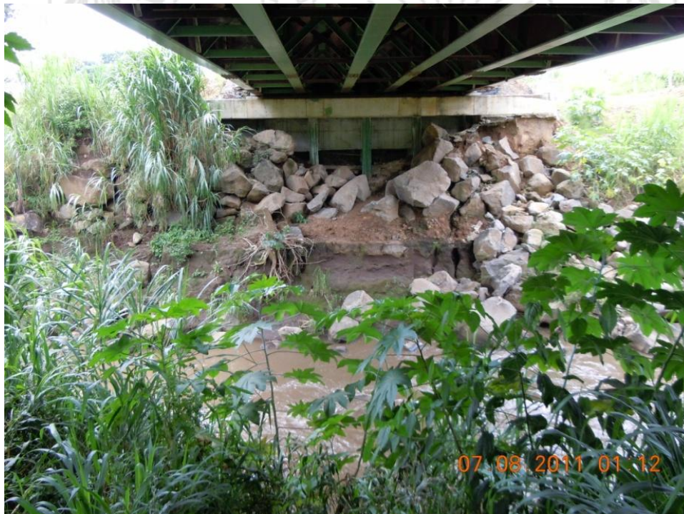
Figura 11. Erosión en las márgenes del río y pérdida del enrocado de protección del talud (bastión Noroeste)
