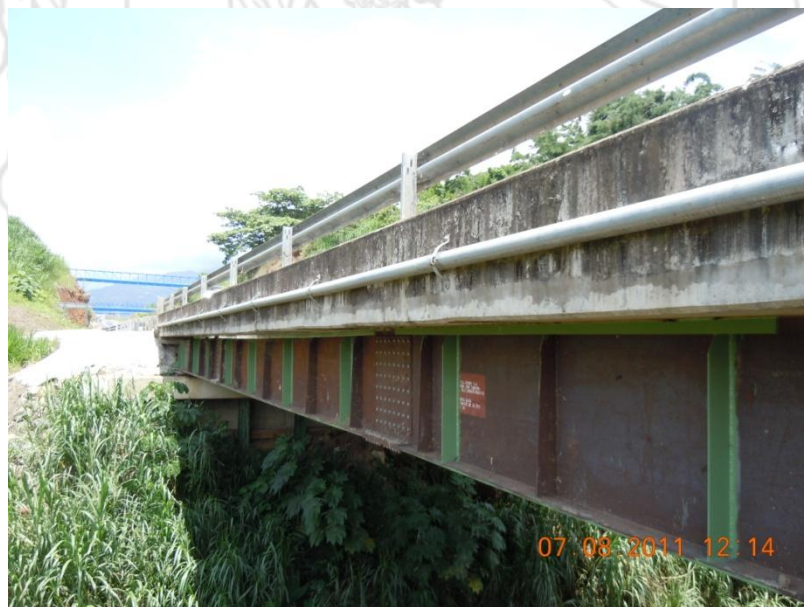
Figura 3. Vista lateral del puente
