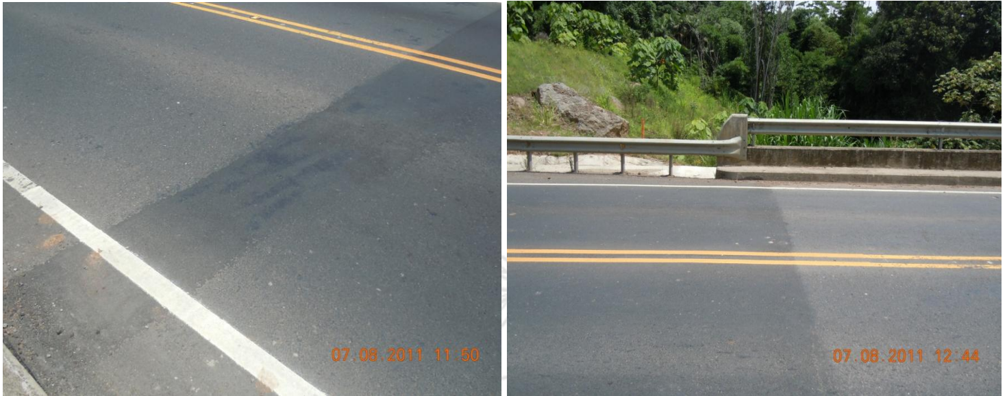
Figura 10. Aparente inexistencia de juntas de expansión en accesos. (Evidencia de puente tipo semi-integral)
