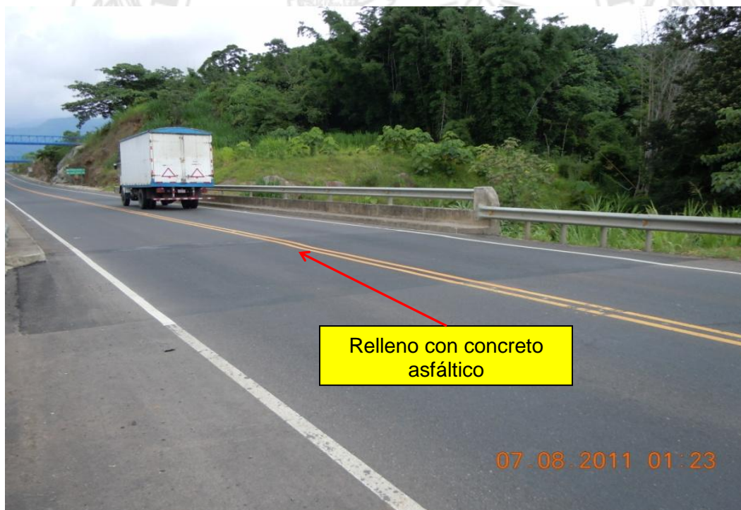
Figura 9. Relleno con concreto asfáltico para la nivelación en el acceso Noroeste.
