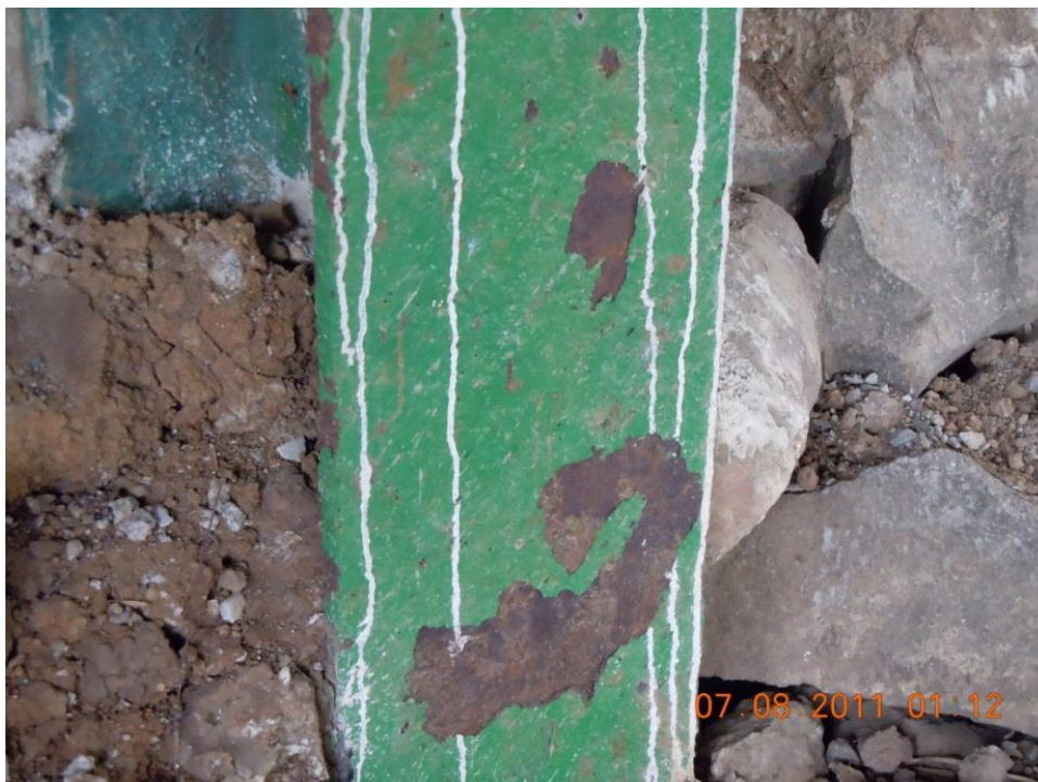
Figura 12. Desprendimiento de la pintura de protección aplicada sobre los pilotes.
