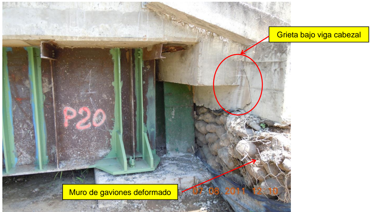
Figura 6. El muro de contención de gaviones en el acceso Noroeste bajo la viga cabezal muestra una aparente deformación fuera de su plano.
