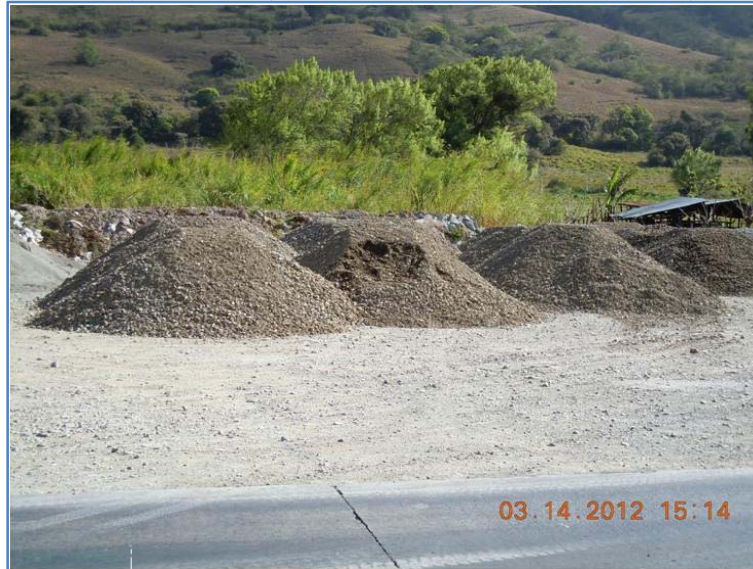
Fotografía 1. Material de subbase apilado cerca de la estación de pesaje de Ochomogo
