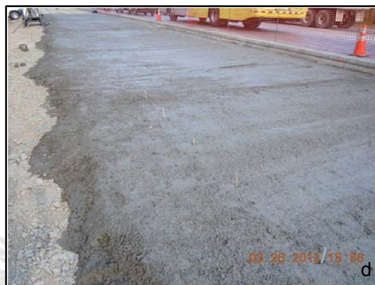
Fotografía 2. Proceso de colocación del material de toba cemento plástica.
