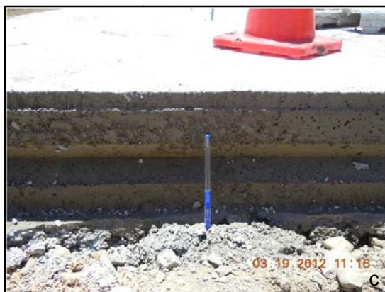
Fotografía 2. Proceso de colocación del material de toba cemento plástica.
