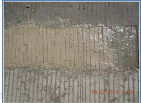
Fotografía 5. Proceso reparación del deterioro de la losa de cemento hidráulico.
