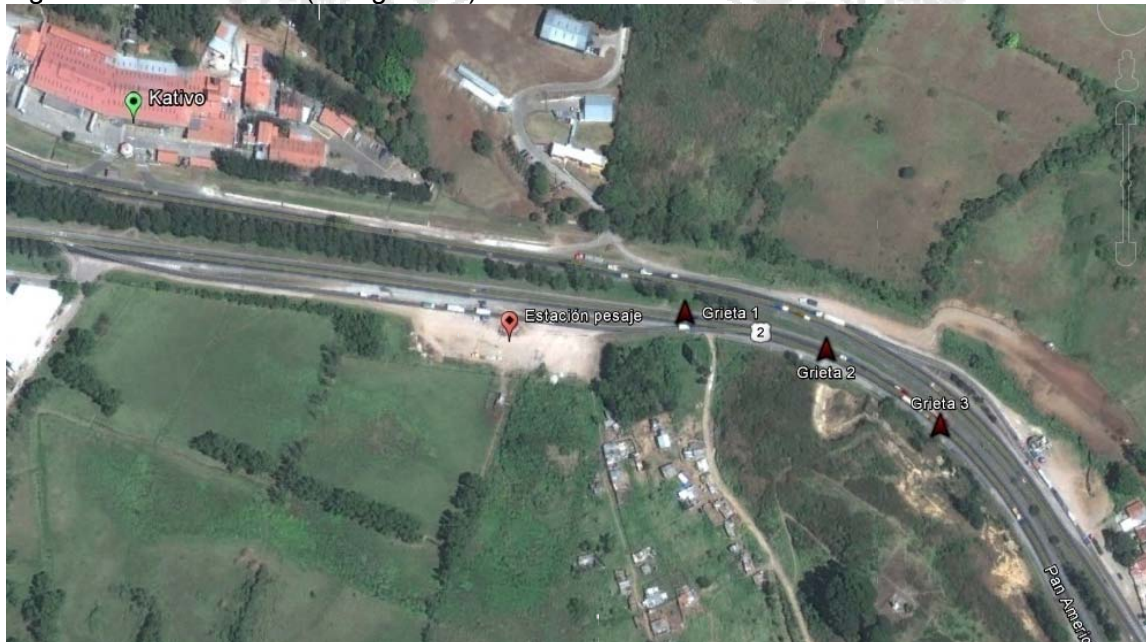
Figura 6. Ubicación de grietas en el proyecto.
