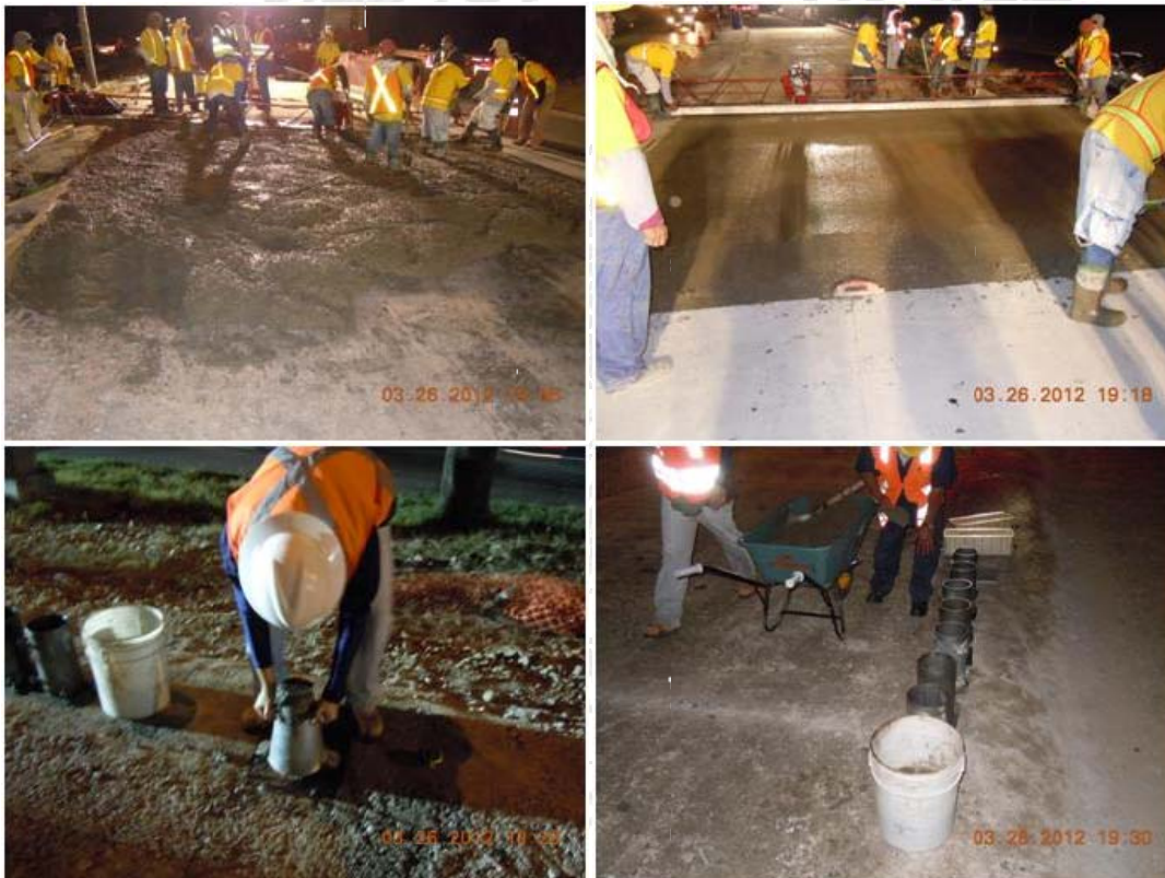
Fotografía 3. Proceso de colocación de la losa de cemento hidráulico.
