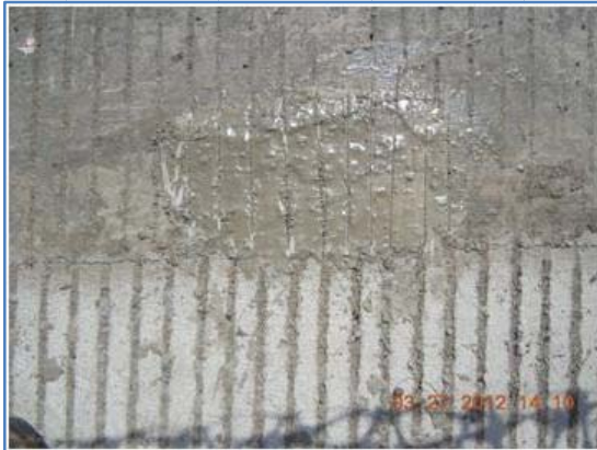
Fotografía 5. Proceso reparación del deterioro de la losa de cemento hidráulico.
