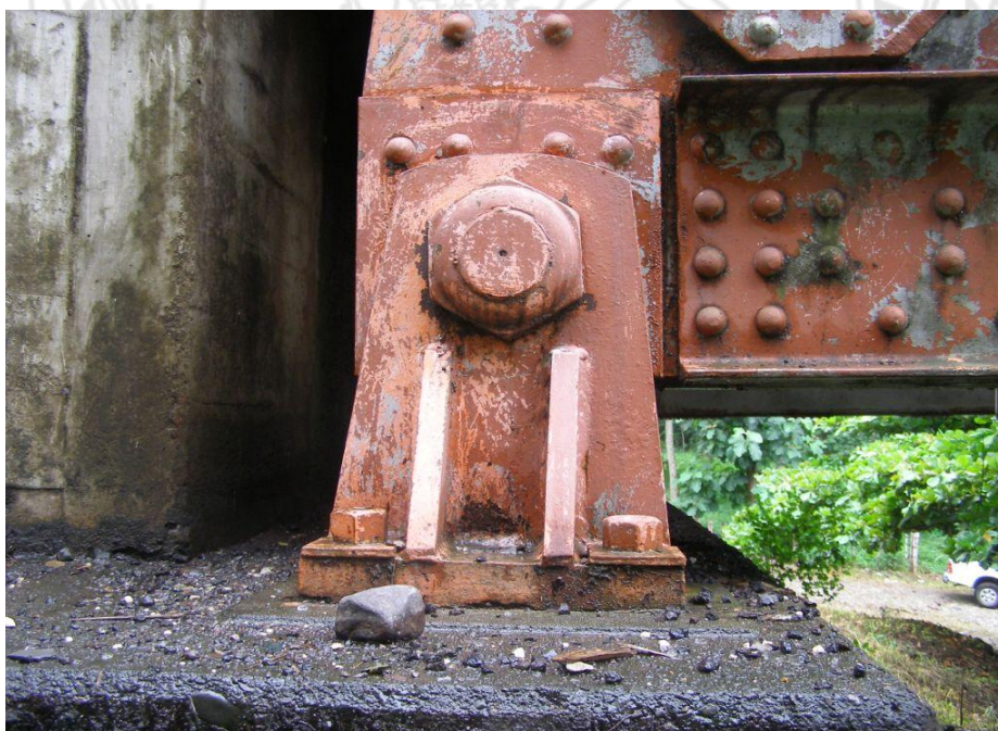
Figura 17. Los apoyos exhiben descascaramiento de la pintura y están continuamente expuestos a la humedad.
