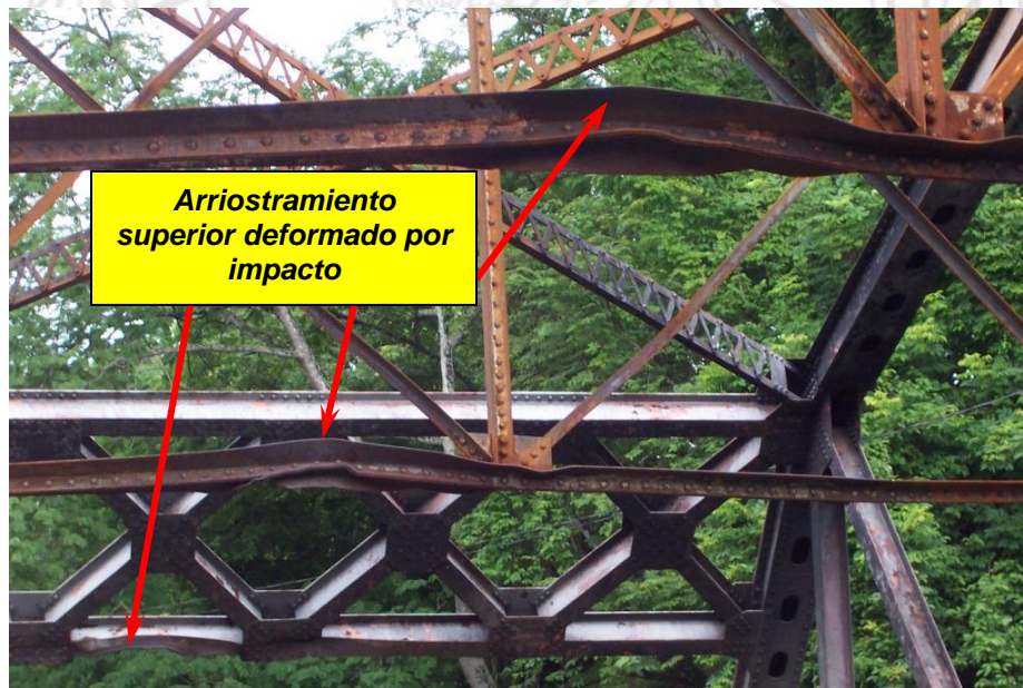
Figura 15. Deformación del arriostramiento superior debido al impacto de vehículos.
