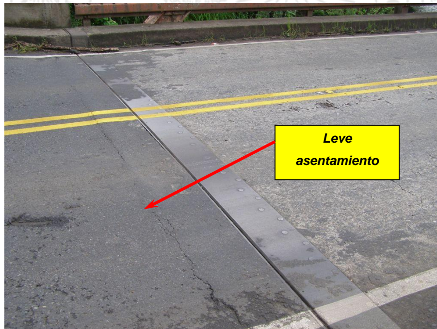
Figura 7. Junta de expansión sobre el bastión Sur donde se observa asentamiento de la superficie justo antes de entrar al puente.
