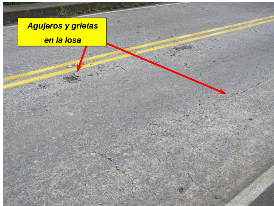
Figura 6. Agujeros y grietas en la losa del puente.
