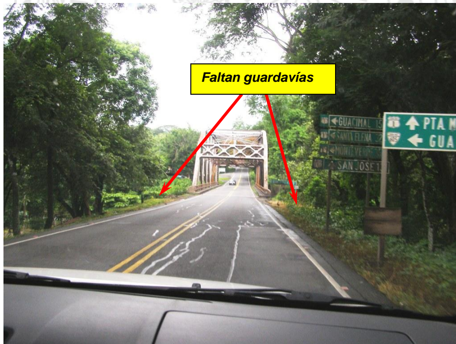
Figura 5. Faltante de guardavías en ambos acceso al puente.
