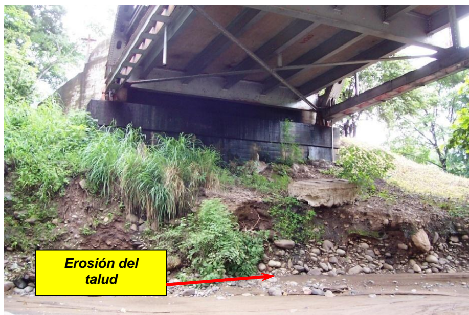
Figura 8. Vista del bastión Norte mostrando la erosión del talud bajo el bastión.
