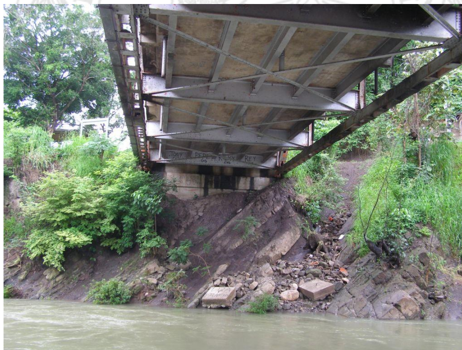
Figura 9. Vista mostrando la erosión del talud bajo el bastión Sur y la erosión del talud a un costado del bastión debido a la ausencia de un sistema de drenaje.
