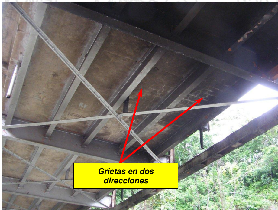
Figura 11. La losa exhibe grietas en dos direcciones
