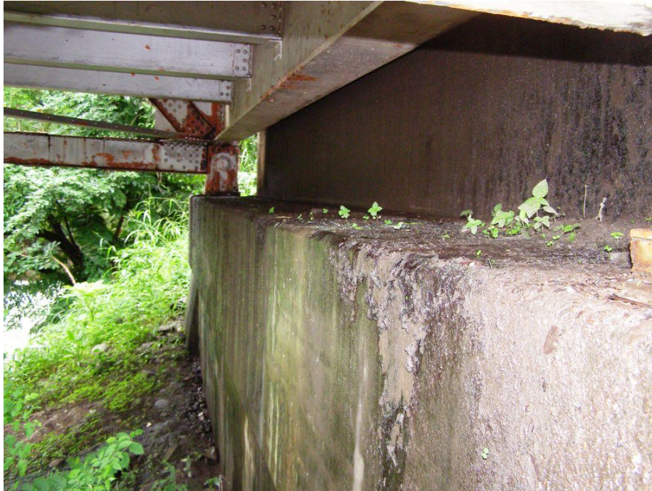
Figura 10. Indicios de agua filtrada a través de la junta de expansión sobre la viga cabezal del bastión y corrosión de los apoyos.
