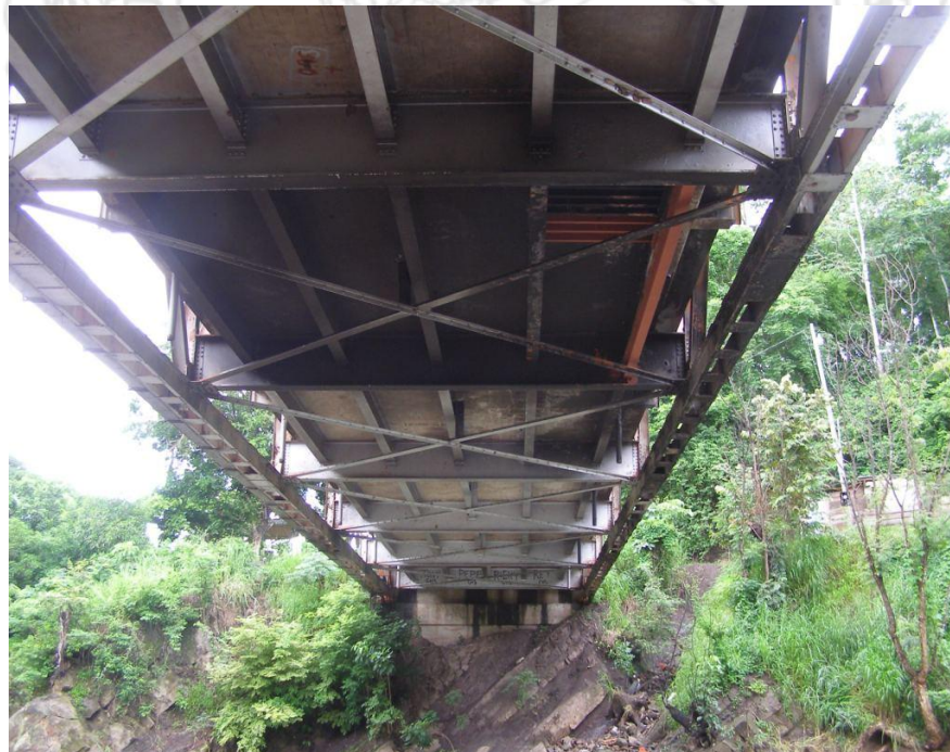
Figura 3. Vista inferior del puente.
