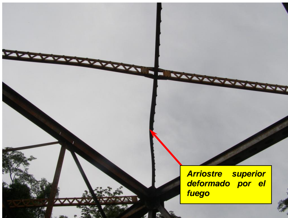
Figura 16. Deformación de un elemento del sistema de arriostramiento superior debido al fuego.
