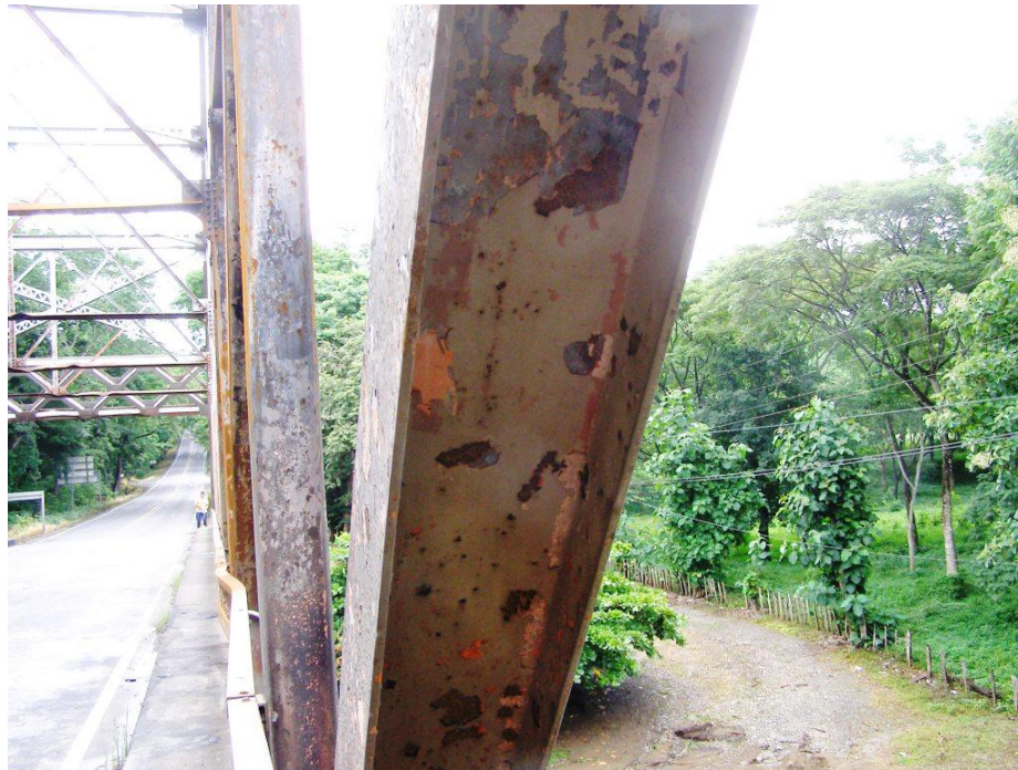
Figura 12. Corrosión típica en los elementos de la cercha.
