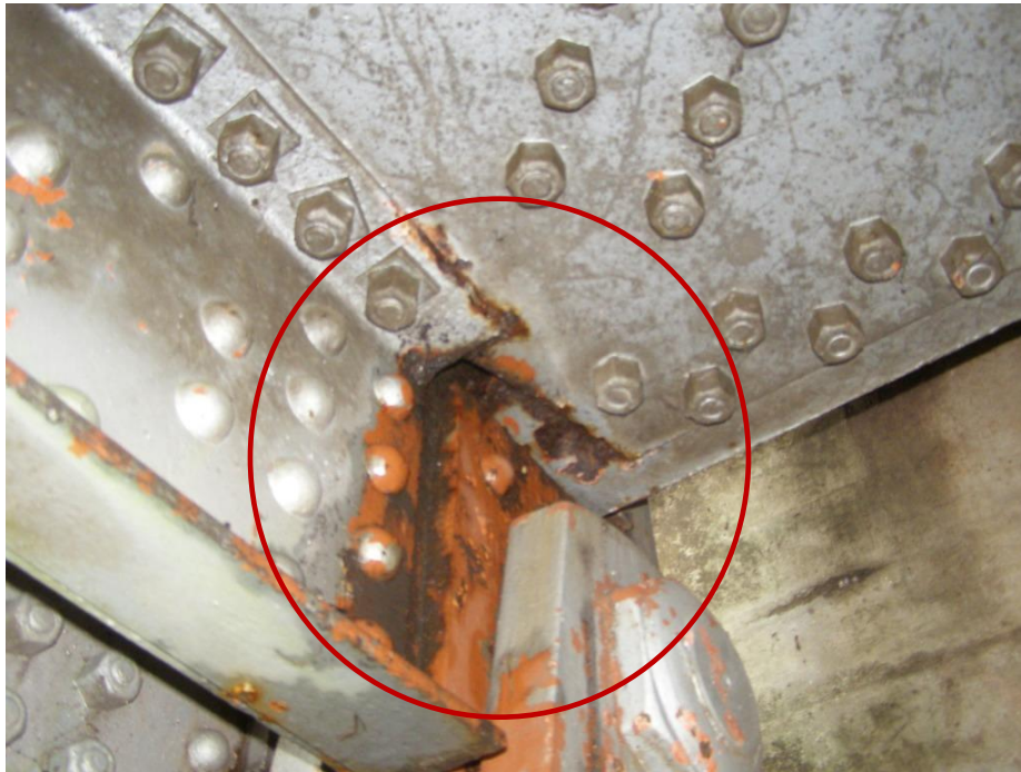
Figura 18. Los apoyos exhiben corrosión debido a la humedad que existe en los bastiones.
