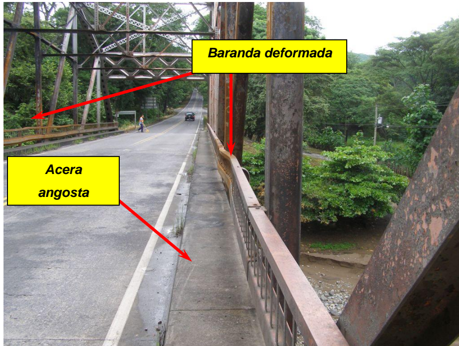
Figura 4. Baranda deformada y acera peatonal angosta.
