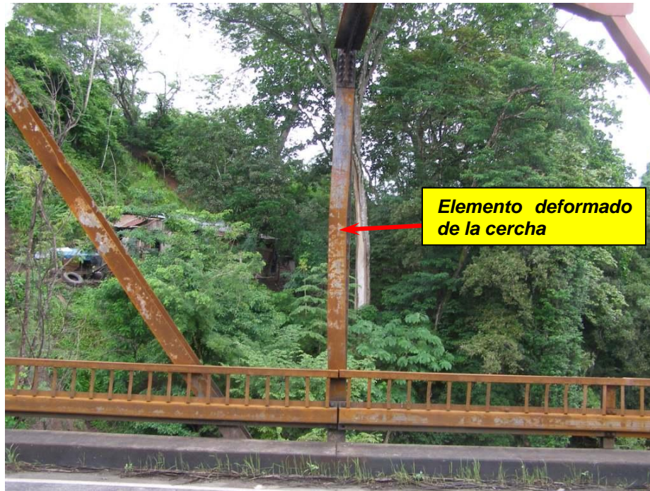
Figura 14. Vista del elemento vertical deformado de la cercha.
