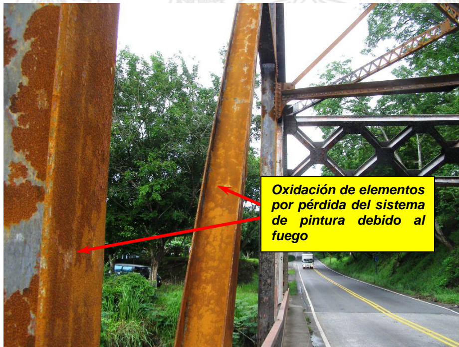
Figura 13. Oxidación típica en los elementos de la cercha expuestos al fuego debido a la pérdida de la pintura de protección.
