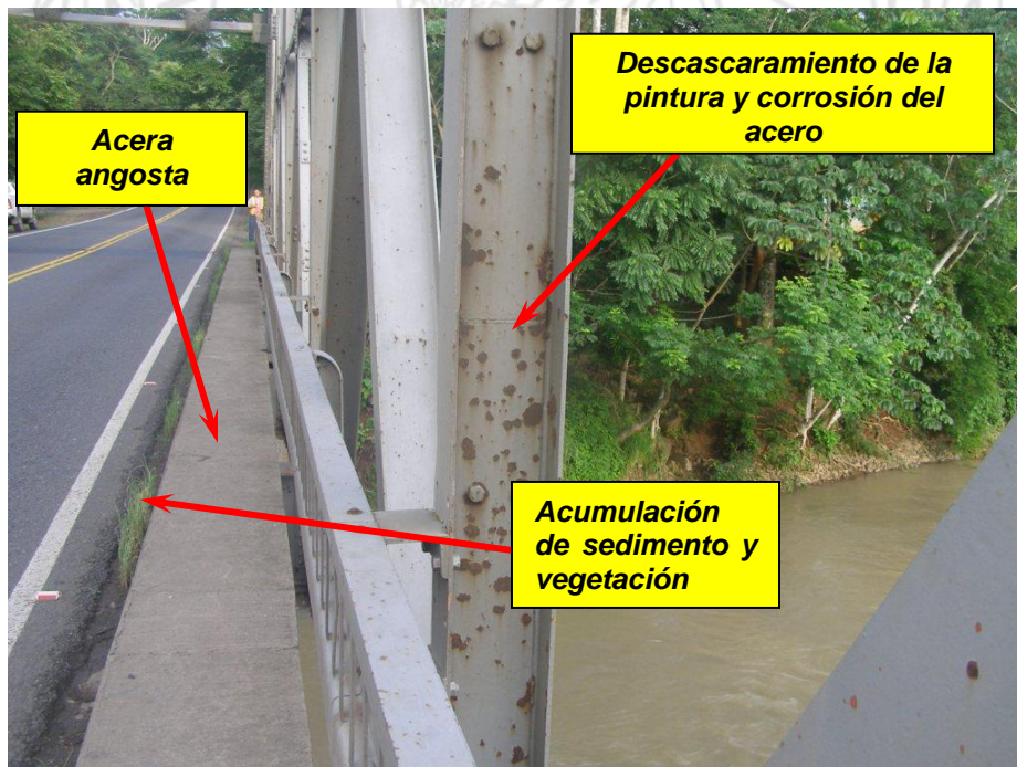
Figura 7. Vista mostrando acera angosta, descascaramiento de la pintura, piquetes de corrosión y acumulación de sedimento y vegetación a lo largo del bordillo.
