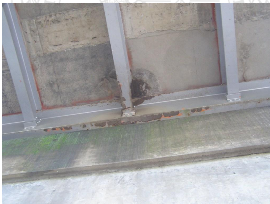
Figura 15. Corrosión de la viga transversal producida por el agua infiltrada por la junta de expansión (bastión Noroeste).
