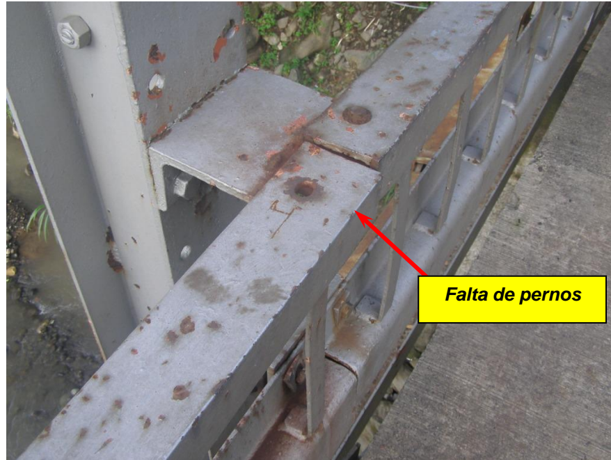
Figura 4. Pernos faltantes en la baranda.
