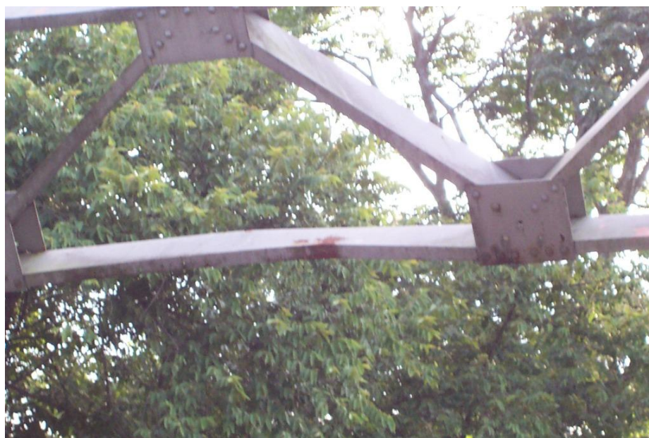
Figura 14. Elemento del portal impactado por un vehículo.
