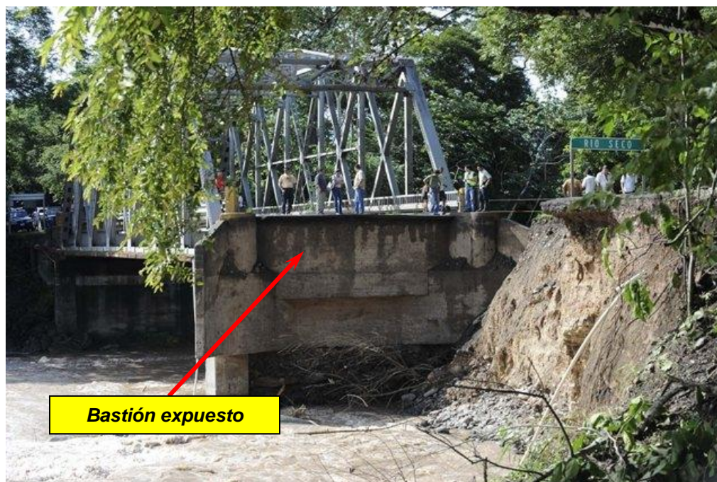
Figura 20. Vista mostrando el daño por erosión del acceso Noroeste debido a la crecida del río. (Foto tomada de La Nación digital 29-07-2010).
