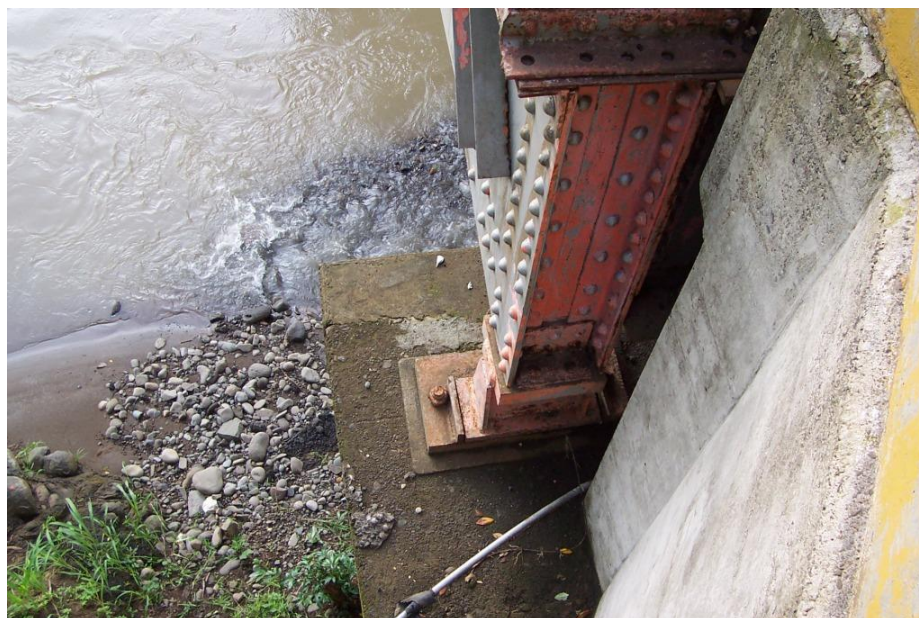
Figura 18. Apoyo sujeto a la humedad el cual muestra oxidación y corrosión. Adicionalmente, es visible la limitada longitud de asiento con que cuenta el apoyo.
