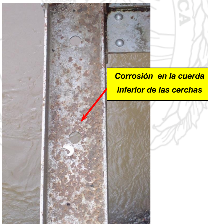
Figura 13. Corrosión típica en la cuerda inferior de la cerchas.
