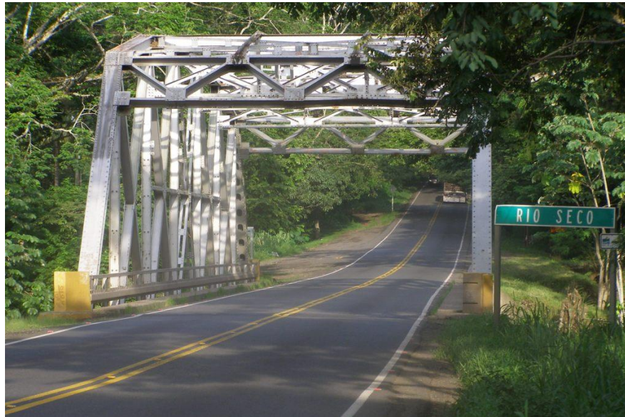
Figura 2. Vista general del puente.
