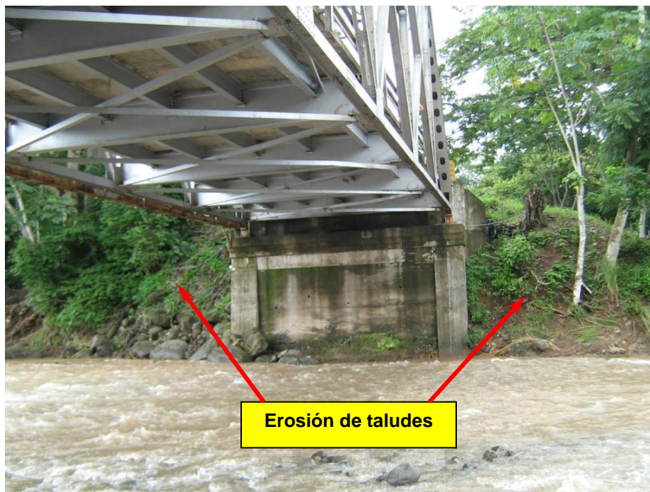
Figura 8. Erosión de los taludes junto a los aletones del bastión Sureste.
