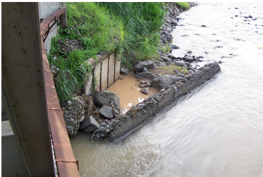
Figura 12. Vista mostrando elementos de protección del relleno de aproximación junto al bastión Noroeste que existía antes de que el río erosionara el relleno de aproximación.
