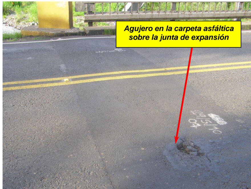
Figura 10. Junta de expansión obstruida sobre el bastión Noroeste.
