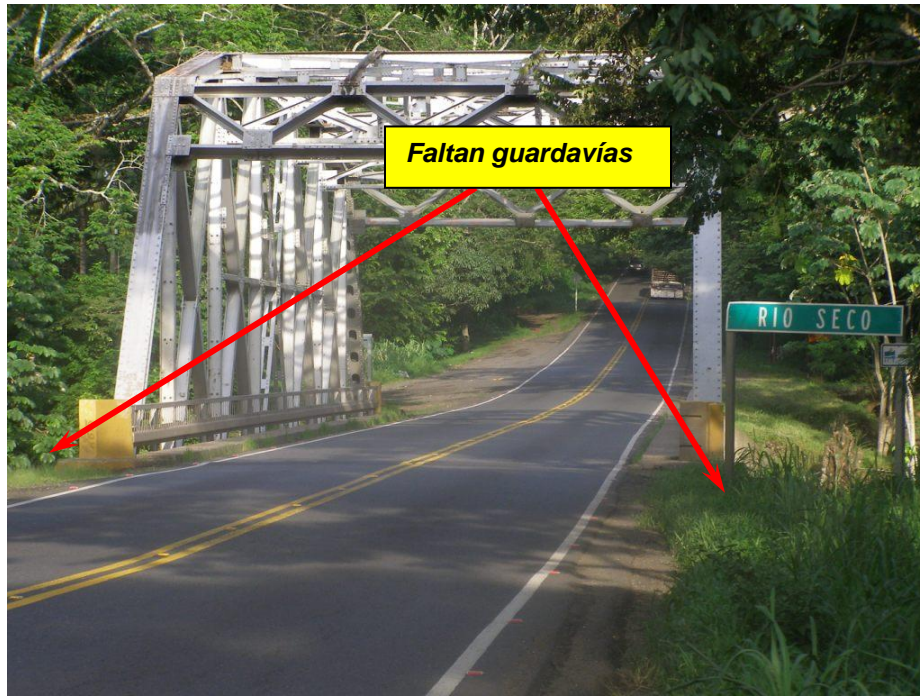
Figura 6. Faltante de guardavías en los accesos al puente.
