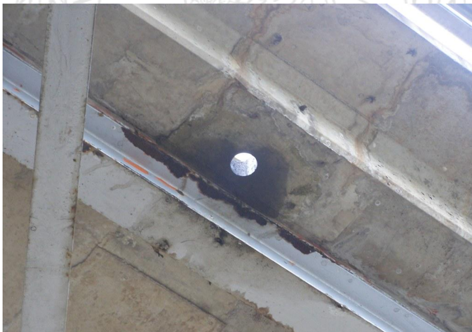
Figura 9. Vista de un ducto de drenaje donde se muestra la humedad en la superficie de concreto y la corrosión de la viga de acero por la falta de un tubo de drenaje que se extienda más allá de la superficie inferior de la viga de acero.
