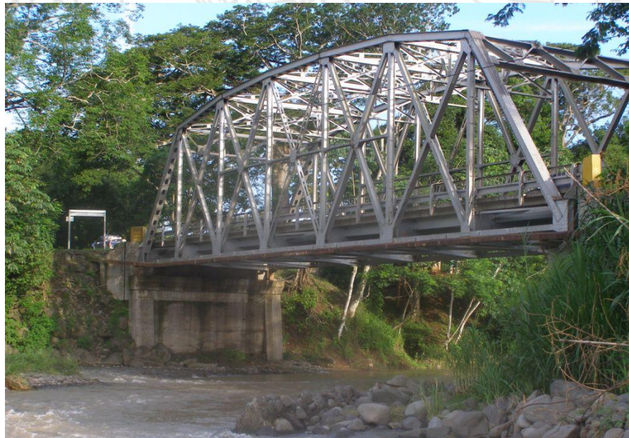
Figura 3. Vista lateral del puente.
