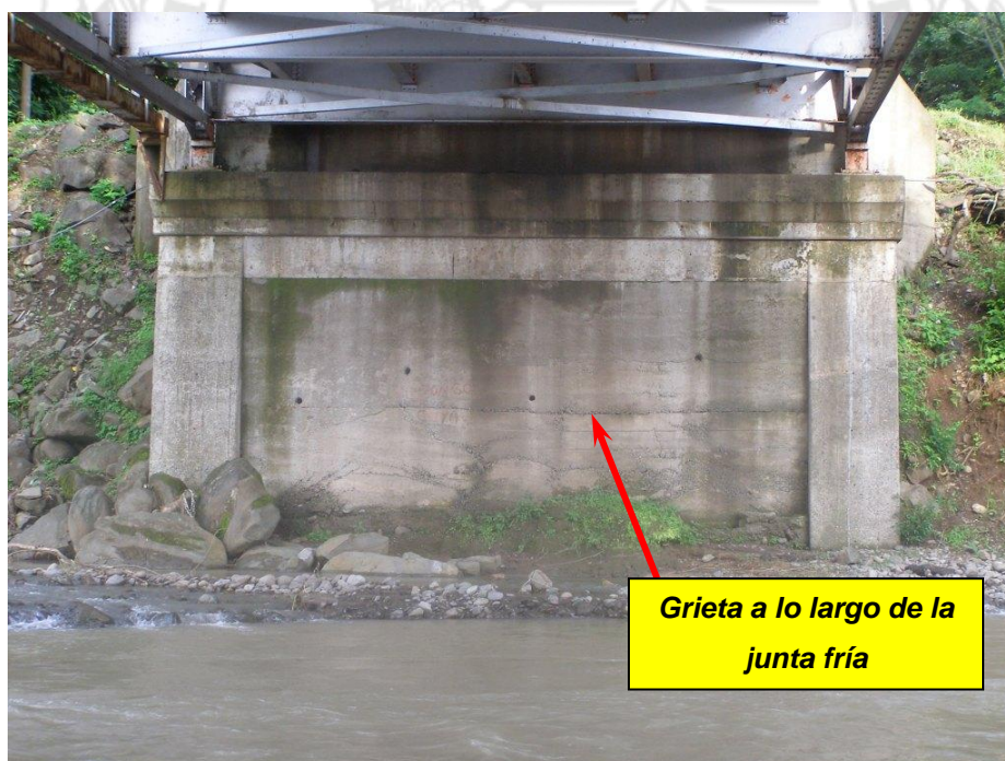
Figura 19. Nidos de piedra superficiales en el muro pantalla del bastión Sureste y abertura a lo largo de la junta fría.
