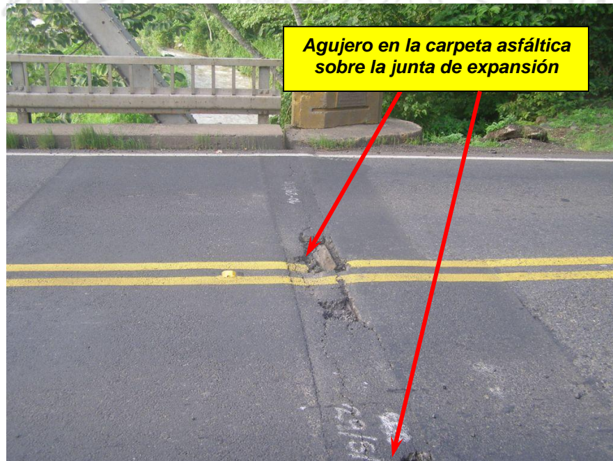
Figura 11. Junta de expansión obstruida sobre el bastión Sureste.
