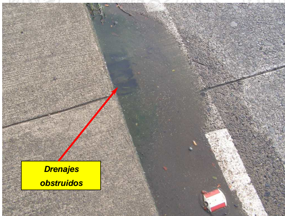
Figura 7. Se observaron varios drenajes obstruidos.
