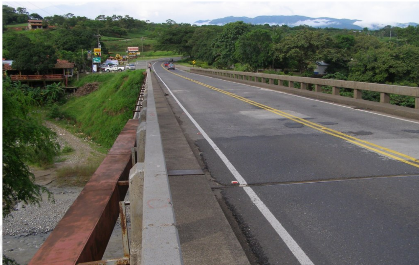
Figura 2. Vista a lo largo de la línea centro del puente.
