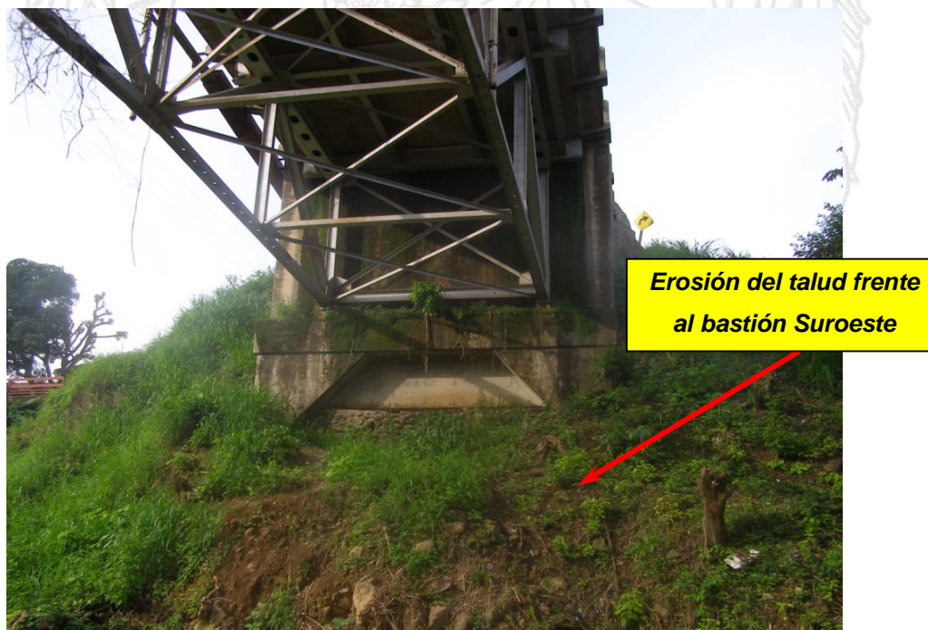
Figura 15. Erosión del talud bajo el bastión Suroeste.
