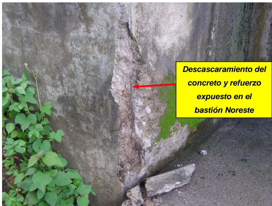
Figura 14. Descascaramiento del concreto y refuerzo expuesto en el bastión Noreste.
