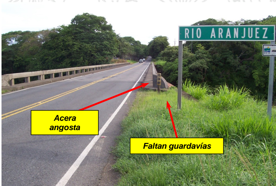
Figura 5. Vista mostrando acera peatonal angosta, falta de guardavías, ausencia de iluminación, baranda sin pintura retrorreflectiva.
