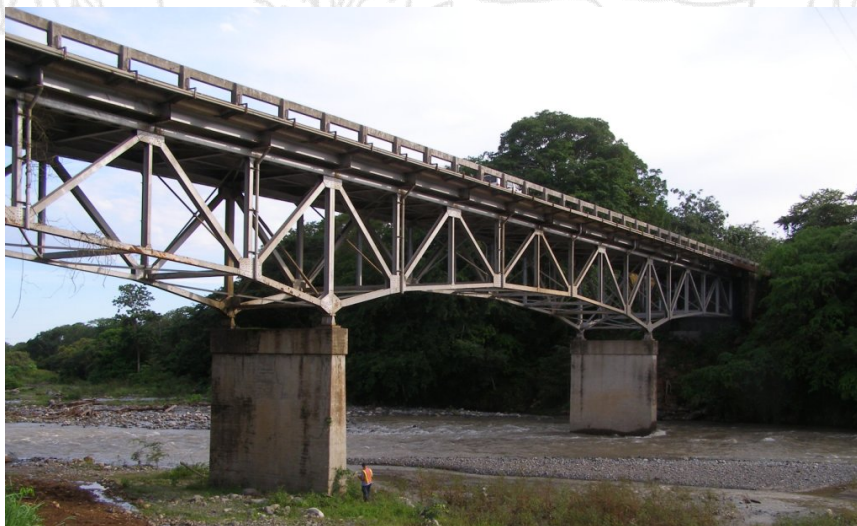
Figura 3. Vista lateral del puente.
