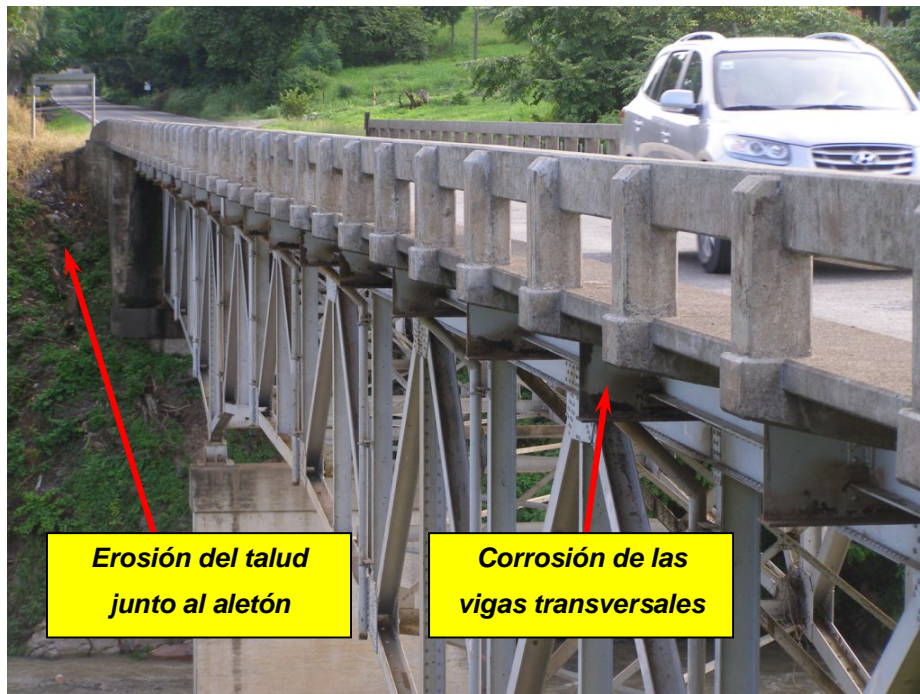
Figura 6. Se observó erosión leve del talud junto a los aletones de ambos bastiones.
