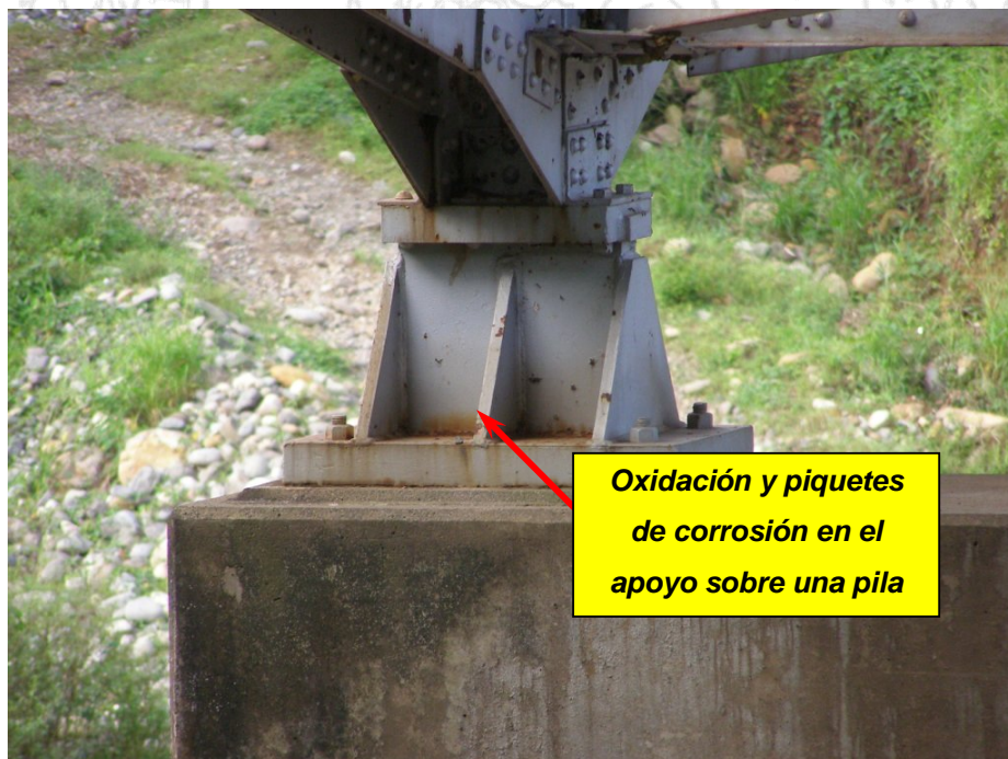
Figura 13. Oxidación y corrosión del apoyo sobre la pila Noreste.
