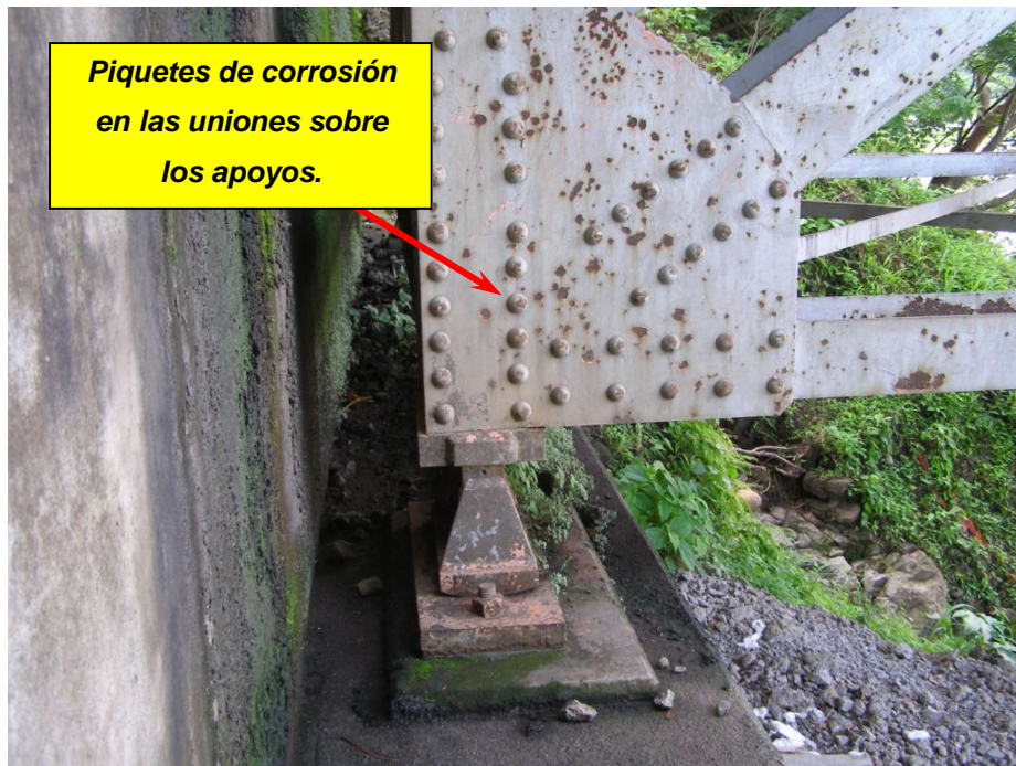
Figura 12. Oxidación y corrosión del apoyo sobre el bastión Noreste. Además se observa filtración de agua y sedimento acumulado
