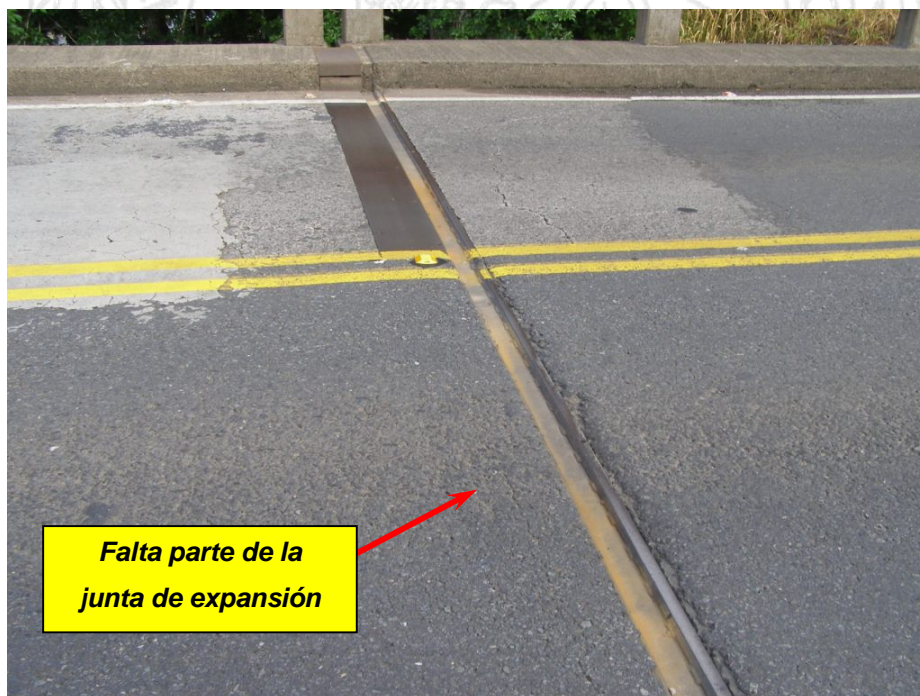
Figura 9. La junta de expansión sobre el bastión Suroeste muestra la falta de elementos de acero.
