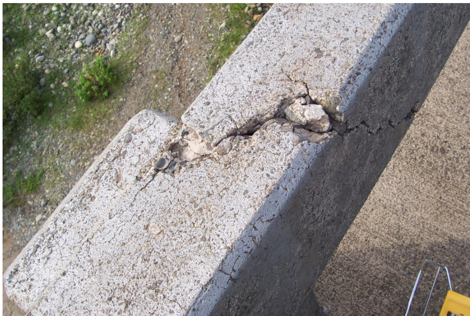
Figura 4. Vista mostrando agrietamiento localizado en una de las barandas.
