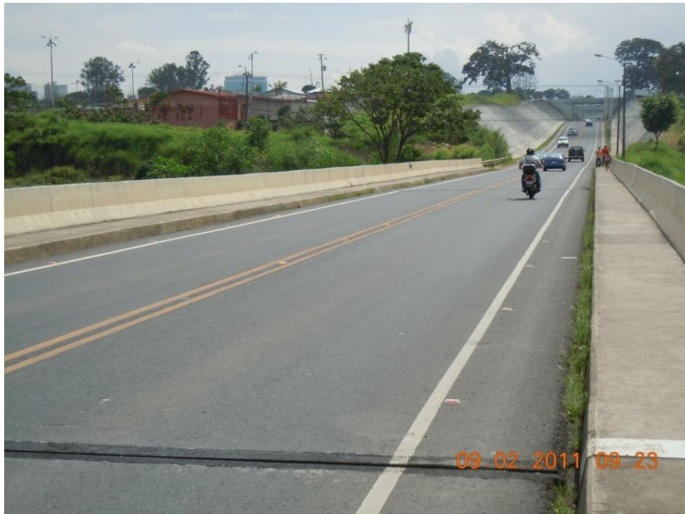
Figura 2. Vista a lo largo de la línea centro
