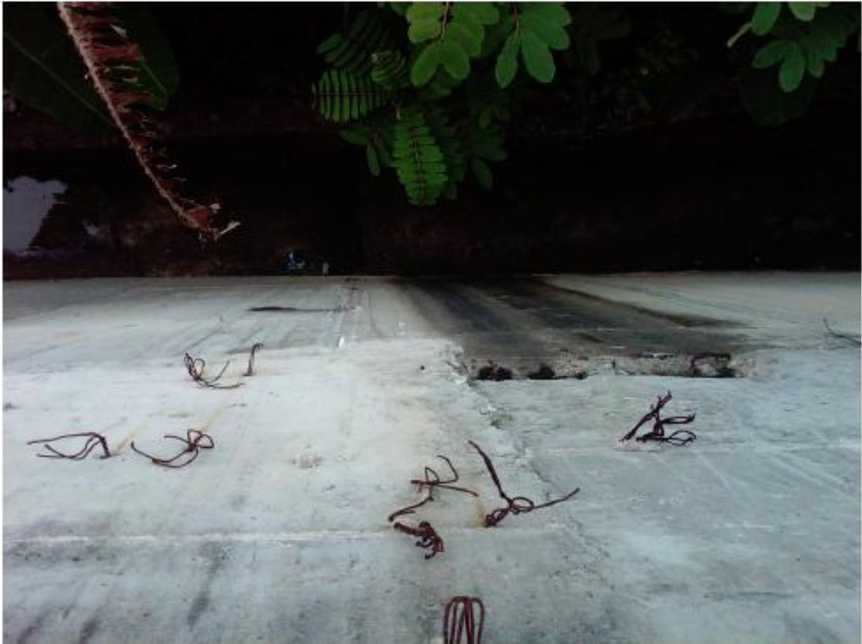
Fotografía 2: Deformaciones excesivas observadas en el muro de retención visto desde la parte superior
