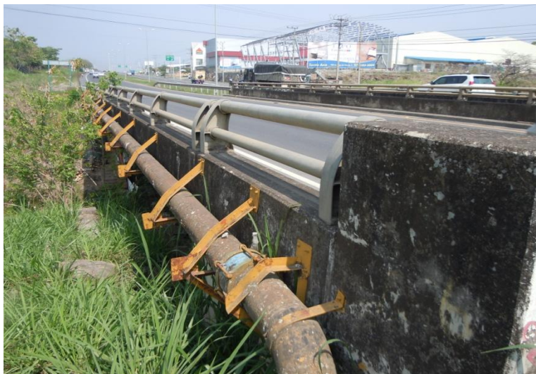
Figura 3: Vista lateral del Puente sobre el Río Caraña
