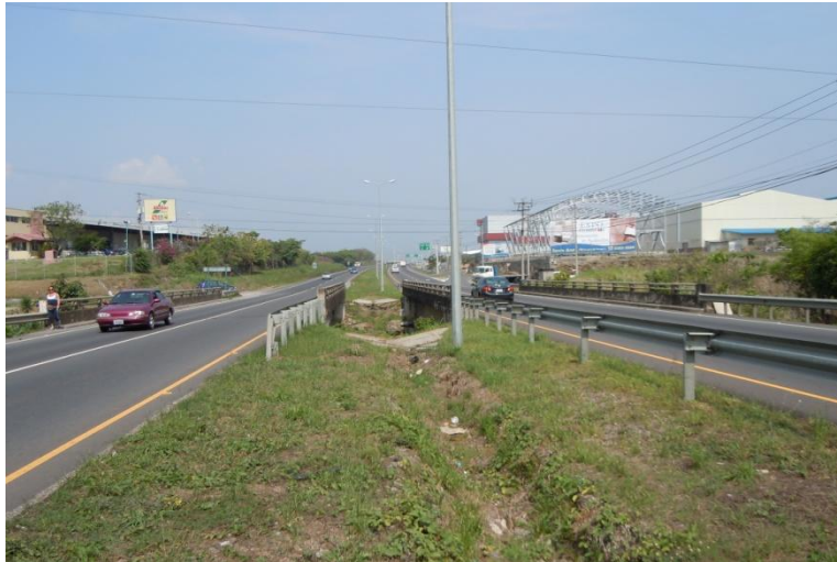
Figura 2: Vista a lo largo de la línea de centro del Puente sobre el Río Caraña
