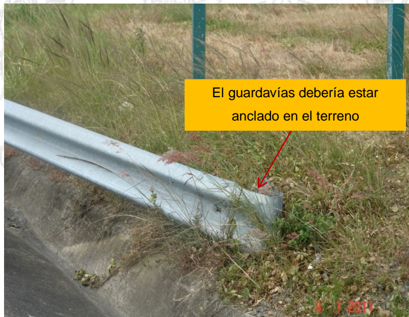
Figura 5. Anclaje inadecuado del guardavía al terreno en el acceso Sureste (Sentido San José-Caldera)
