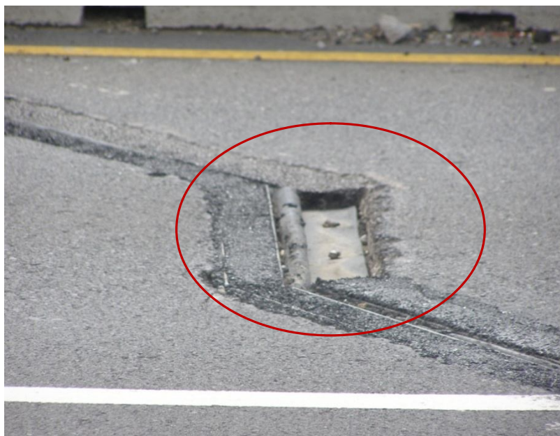
Figura 10. Pérdida de material de relleno de la junta de expansión sobre el bastión Noroeste (sentido San José-Caldera)
