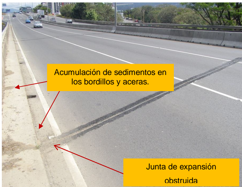
Figura 8. Acumulación de sedimentos en las aceras y bordillos y obstrucción de la junta de expansión
