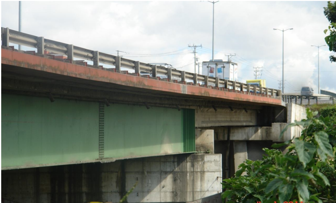
Figura 4. Las barandas se construyeron con vigas y postes del sistema “flex-beam”
