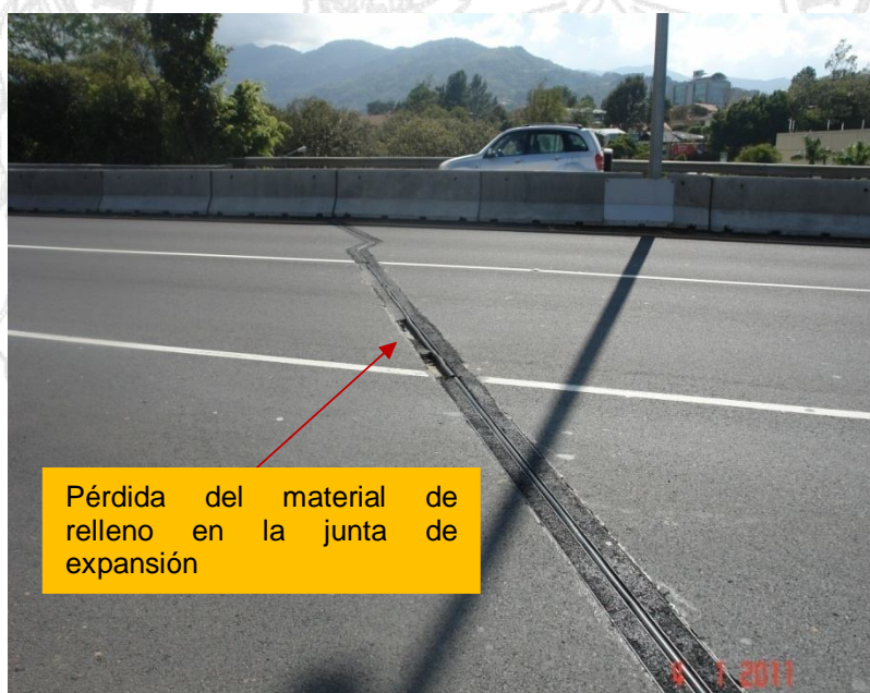
Figura 9. Junta de expansión sobre el bastión Sureste (sentido San José-Caldera)
