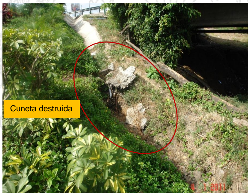
Figura 7. Sistema de drenaje deficiente en el acceso Noroeste (Caldera).
