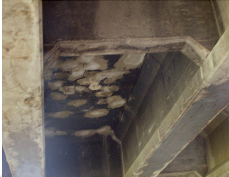
Figura 12. Reparaciones en la superficie inferior de la losa existente (Sentido San José – Caldera)
