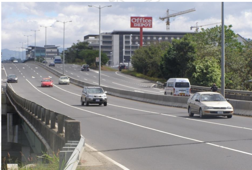
Figura 2. Vista a lo largo de la línea centro del puente sobre el Río Agres
