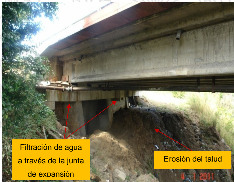
Figura 15. Erosión del talud frente al bastión Noroeste y filtración de agua a través de la junta de expansión
