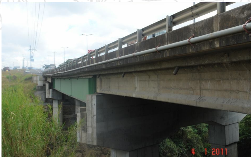
Figura 3. Vista lateral del puente sobre el Río Agres
