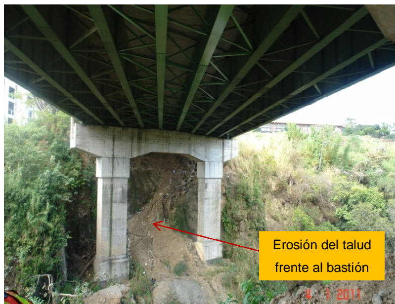
Figura 14. Erosión del talud frente al bastión Noroeste
