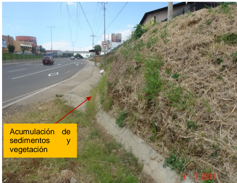
Figura 6. Acumulación de sedimentos y vegetación en las cunetas
