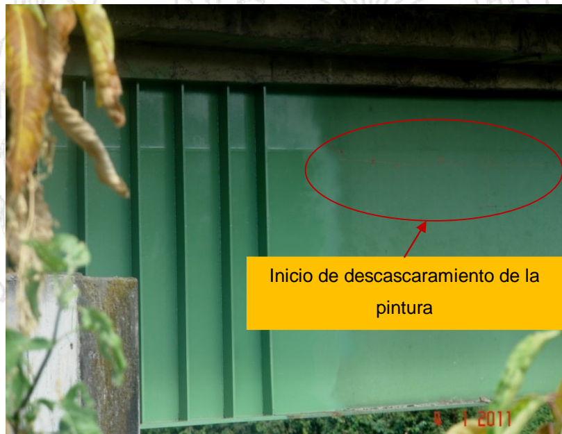
Figura 13. Inicio de descascaramiento de la pintura observado en la viga externa en el sentido Caldera - San José.
