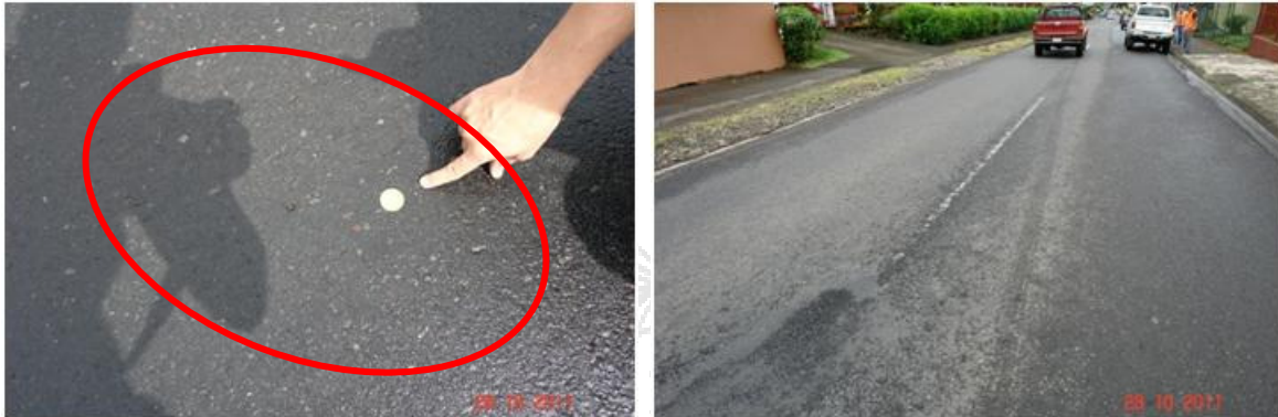
Figura 7. Desprendimiento (ambas) y desnudamiento (derecha) del agregado.
