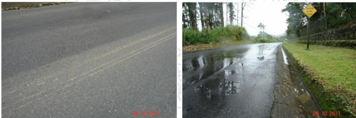
Figura 9. Exudación (izquierda) y roderas con una película de agua delgada (derecha).
