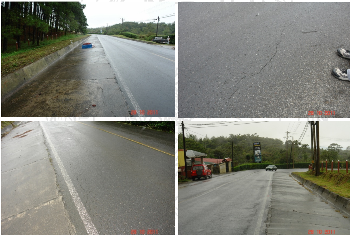
Figura 6. Agrietamientos diversos hallados a lo largo de la ruta visitada.
