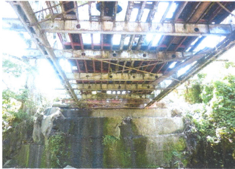
Figura 3. Vista inferior del puente El Bochinche.
