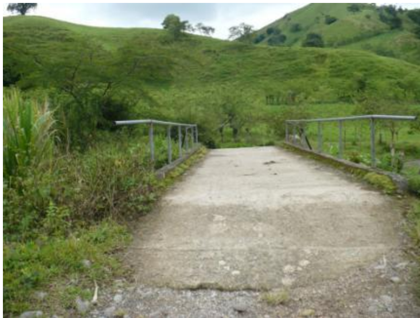
Figura 2. Vista a lo largo de la línea centro del puente San Pedro, Quebrada Micas.
