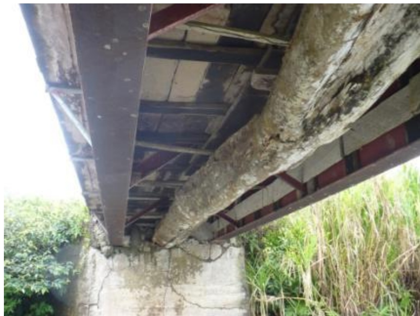
Figura 3. Vista inferior del puente San Pedro, Quebrada Micas.
