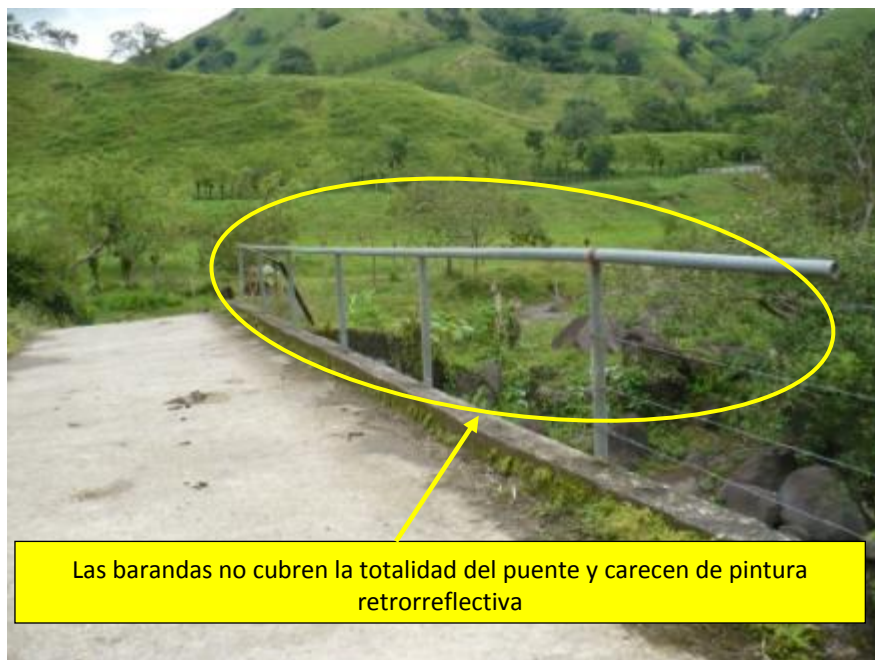
Figura 4. Barandas de acero existentes en el puente.
