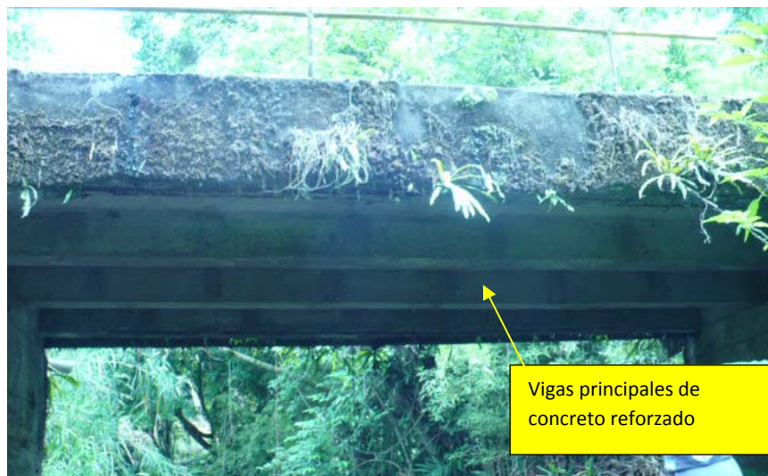
Figura 4. Sistema de vigas principales de concreto reforzado.
