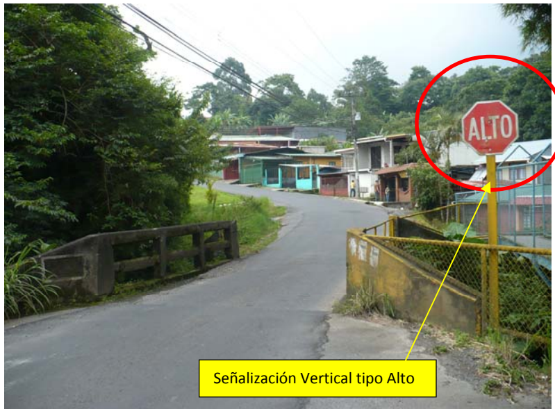
Figura 3. Puente Salitrillos - Río Torres, vista hacia el Noreste.
