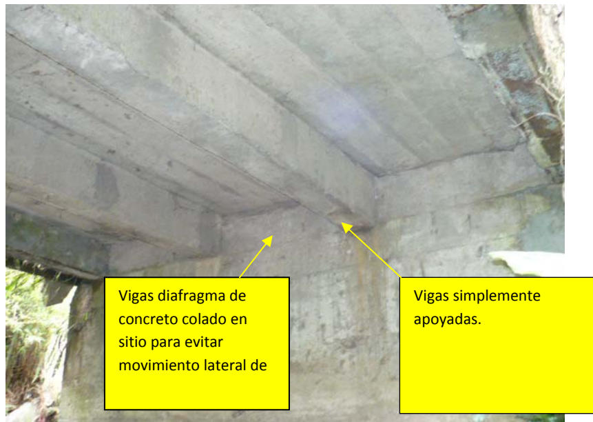
Figura 5. Vista inferior del puente.
