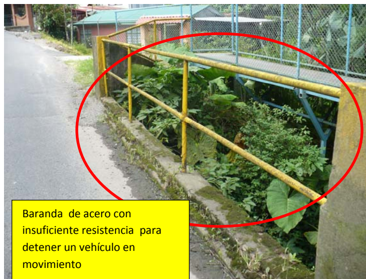
Figura9. Baranda de acero utilizada para sustituir la baranda original de concreto.
