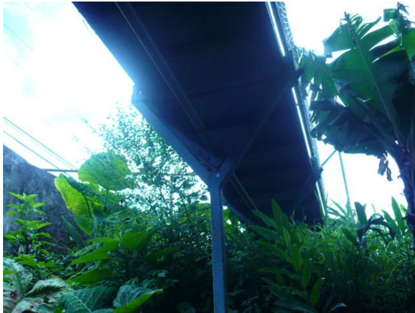
Figura 6. Puente peatonal de cercha de acero ubicado al costado Este del puente.
