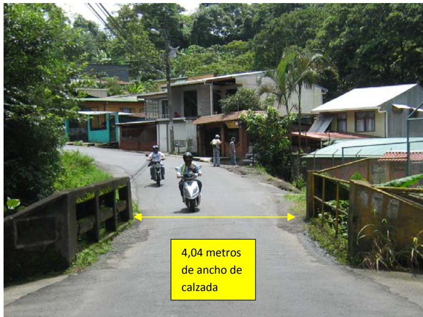
Figura11. El puente es de un solo carril y tiene un reducido espacio de maniobra
